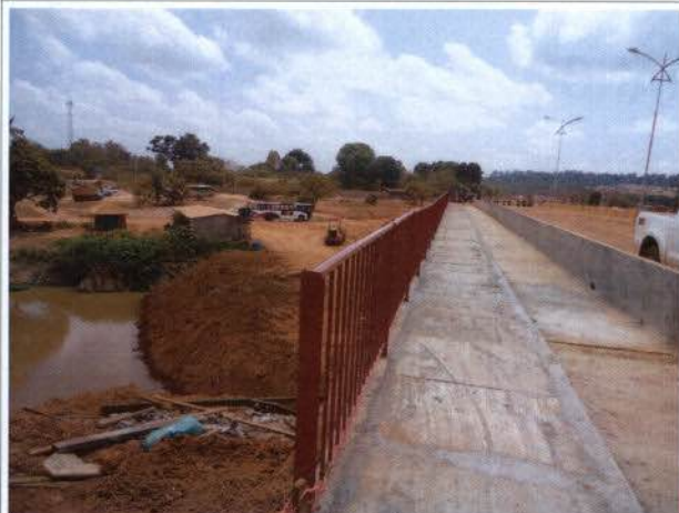
Foto 3 – Presença de material (solo) entre os vãos de uma das novas pontes implantadas pela Norte Energia.
