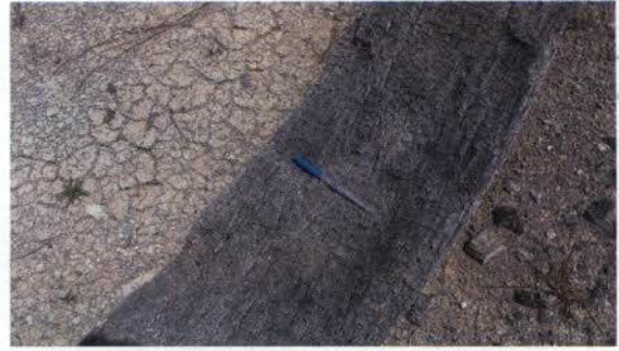
Foto 13: Enterrio de tora que não deveriam ter sido enterrados.
