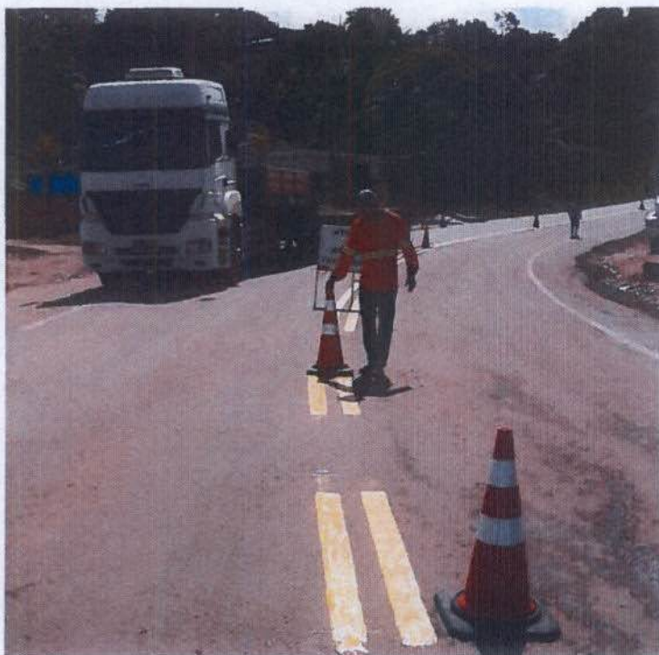
Figura 6 - Pintura de sinalização horizontal, com faixa descontinua, (lado Belo Monte do Pontal).
