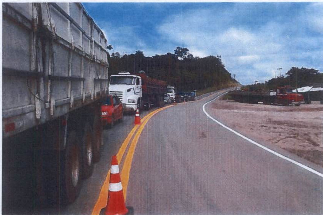
Figura 9 - Pintura de sinalização horizontal, com faixa contínua, (lado Belo Monte).
