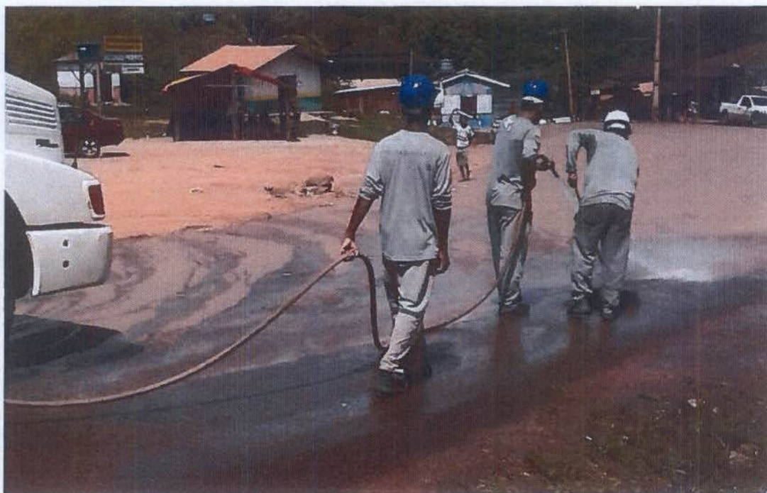
Figura 1 – Limpeza da pavimentação para pintura da pista, (lado Belo Monte do Pontal).
