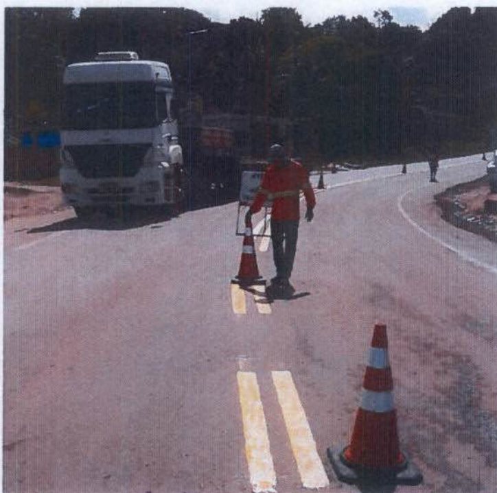
Figura 6 - Pintura de sinalização horizontal, com faixa descontinua, (lado Belo Monte do Pontal).
