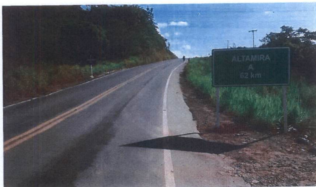
Figura 16 - Sinalização horizontal (faixas e tachas) e sinalização vertical (Placa 2x2 totalmente refletiva) - lado Belo Monte.
