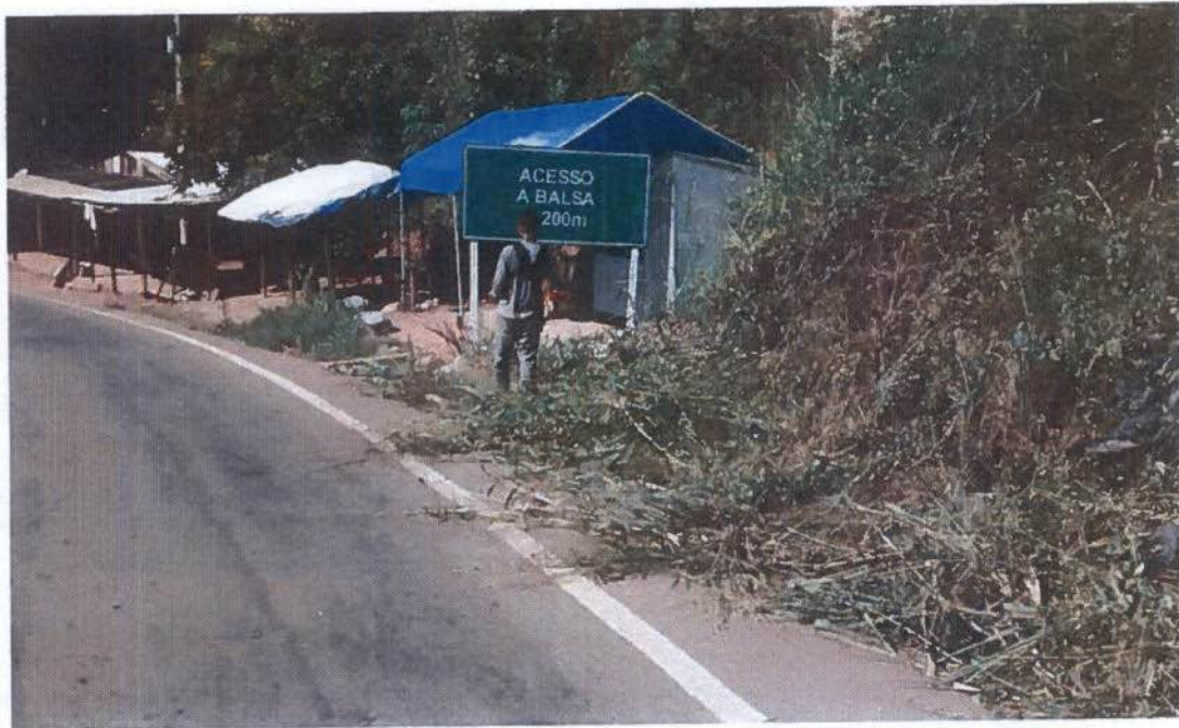
Figura 15 - Sinalização vertical, instalação de placas e roçagem da vegetação para adequada visualização do dispositivo, (lado Belo Monte).
