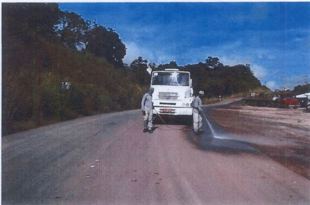
Figura 2 - Limpeza da pavimentação para pintura da pista, (lado Belo Monte).
