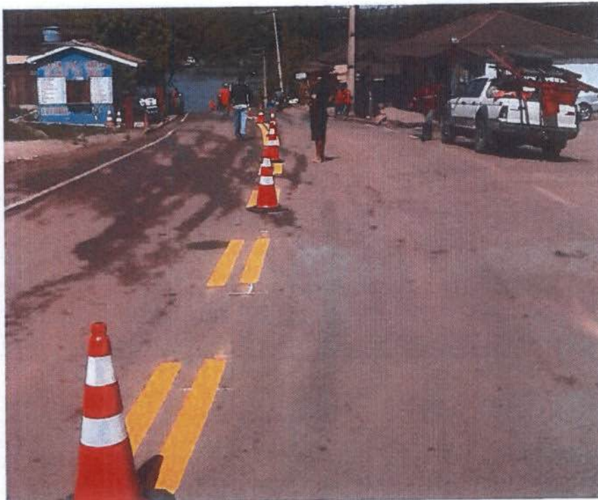
Figura 7 - Pintura de sinalização horizontal, com faixa descontinua, em intersecção de rua, (lado Belo Monte do Pontal).
