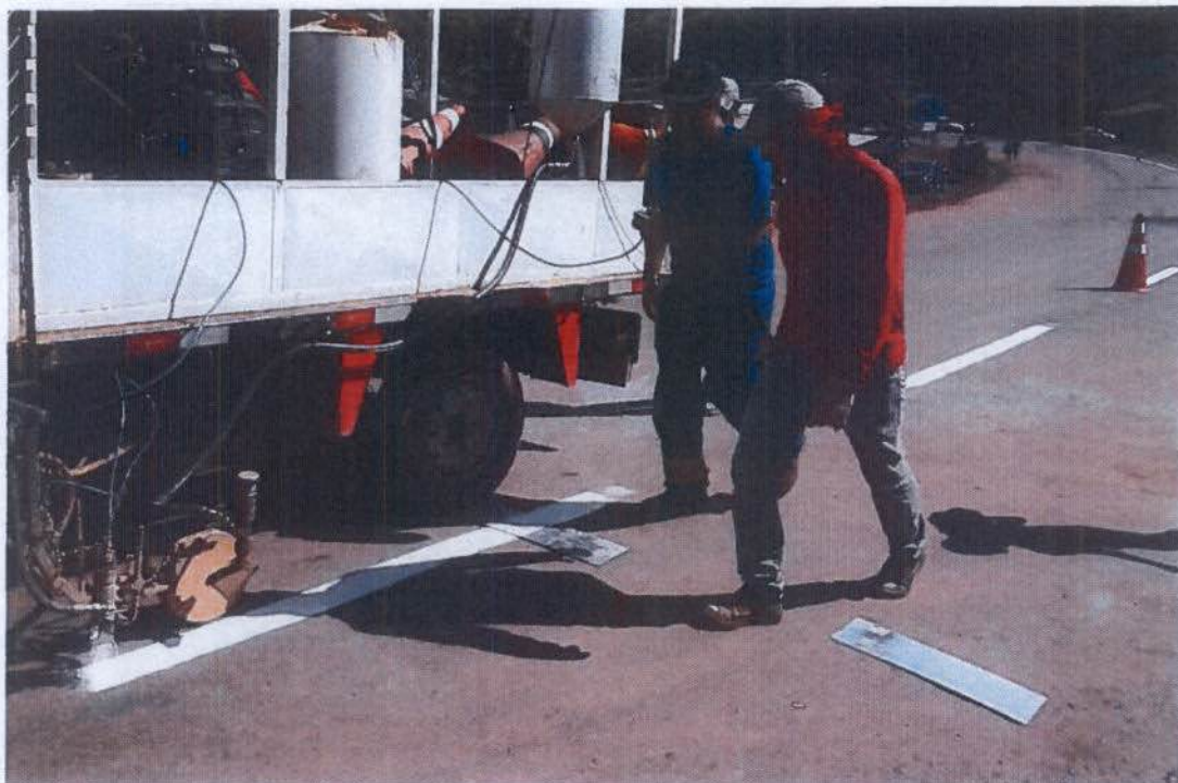
Figura 5 - Pintura de sinalização horizontal, com retirada de corpo de prova, (lado Belo Monte).
