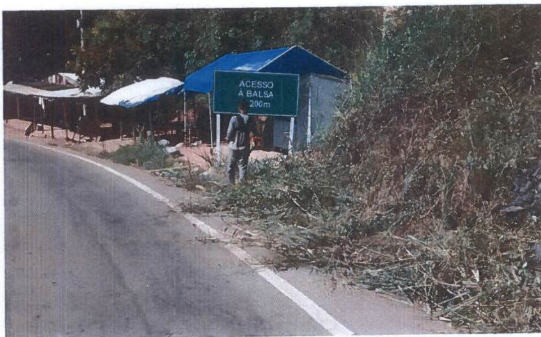
Figura 15 - Sinalização vertical, instalação de placas e roçagem da vegetação para adequada visualização do dispositivo, (lado Belo Monte).
