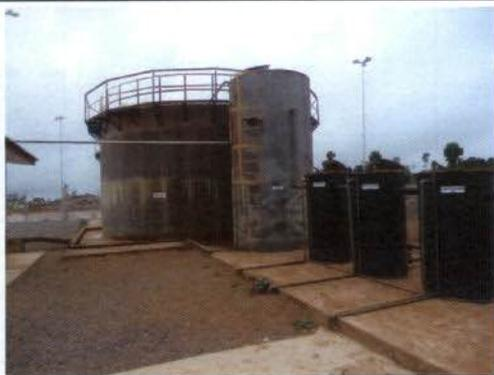
**Foto 13** – Sistema de Tratamento de Lixiviado (STL) do aterro sanitário de Altamira em operação.
