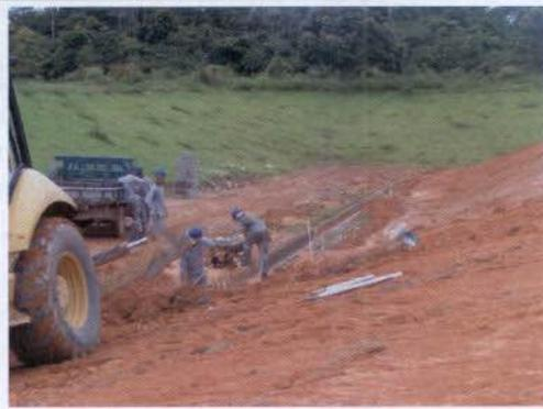
**Foto 12** – Manutenção nas canaletas da Célula 1.
