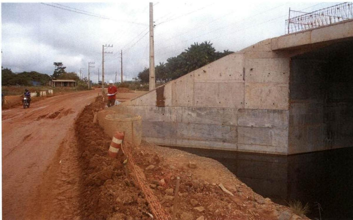
Figura 4. Ponte em galeria na Transamazônica sobre afluente do Igarapé Ambé e via atual (detalhe para o desnível entre a ponte e a via)
