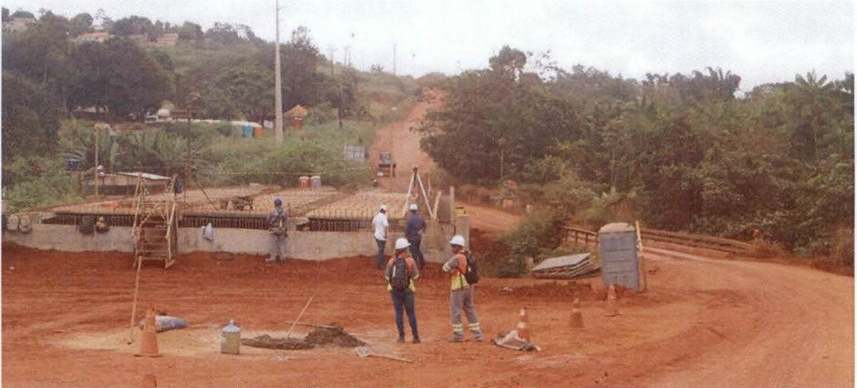
*Figura 2. Ponte em construção e ponte atual da Transamazônica sobre o Igarapé Altamira, momento da medição da cota com GPS geodésico*
