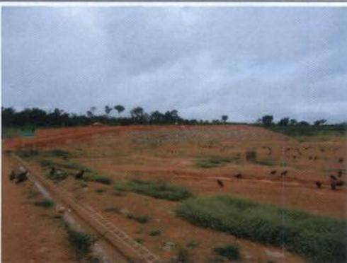
**Foto 9** – Célula 1 sendo corrigida no aterro Sanitário de Altamira.
