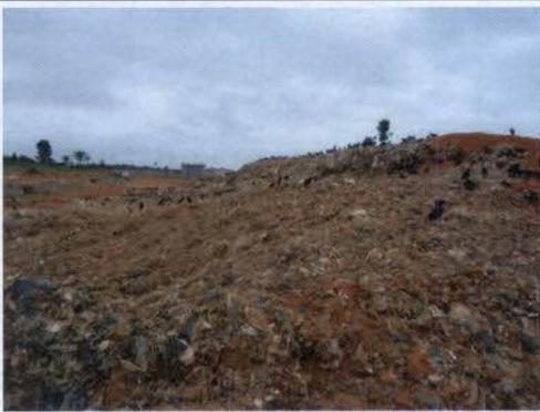
**Foto 11** – Resíduos ainda expostos na Célula 2 – esta célula ainda vai passar pelo processo de correção.
