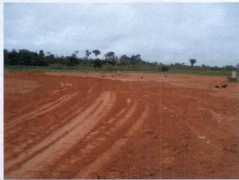
**Foto 10** – Foto tirada sobre a Célula 1 – detalhe para o lançamento adequado do solo sobre os resíduos.
