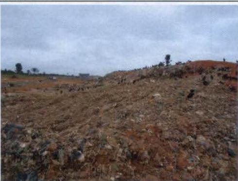
**Foto 11** – Resíduos ainda expostos na Célula 2 – esta célula ainda vai passar pelo processo de correção.
