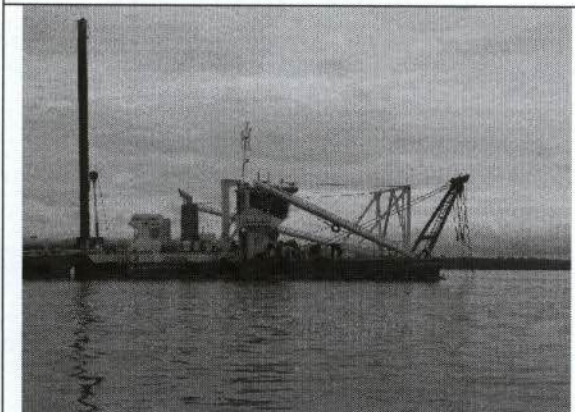
Foto 19 – Dragagem de extração de areia operando na jazida 2.
