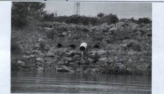
Foto 15 – Local de restituição de água da bacia de sedimentação – Jazida 1.
