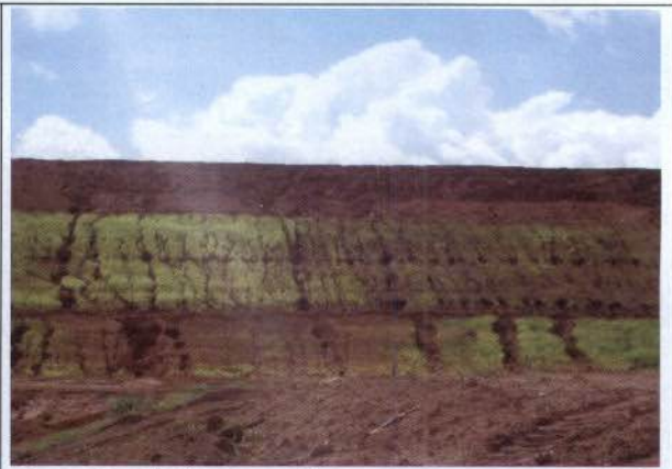
Foto 8 – Sulcos erosivos presentes na maioria dos diques.
