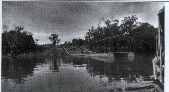
Foto 16 – Captação de água bruta do CCBM.
