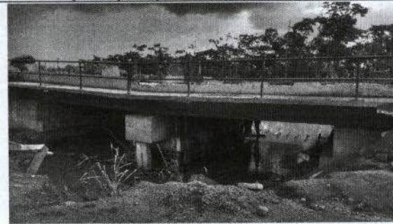
Foto 7 – Ponte da av. Transposição.
