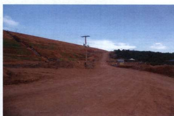
Foto 6 – Escadas de drenagens para escoamento da água nos diques.
