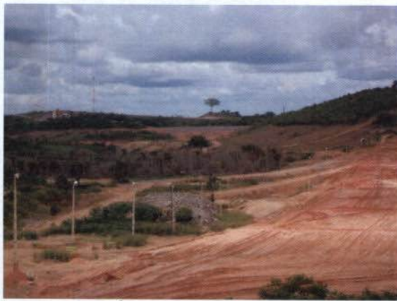
Foto 31 – Área suprimida do reservatório intermediário próximo a um dique.
