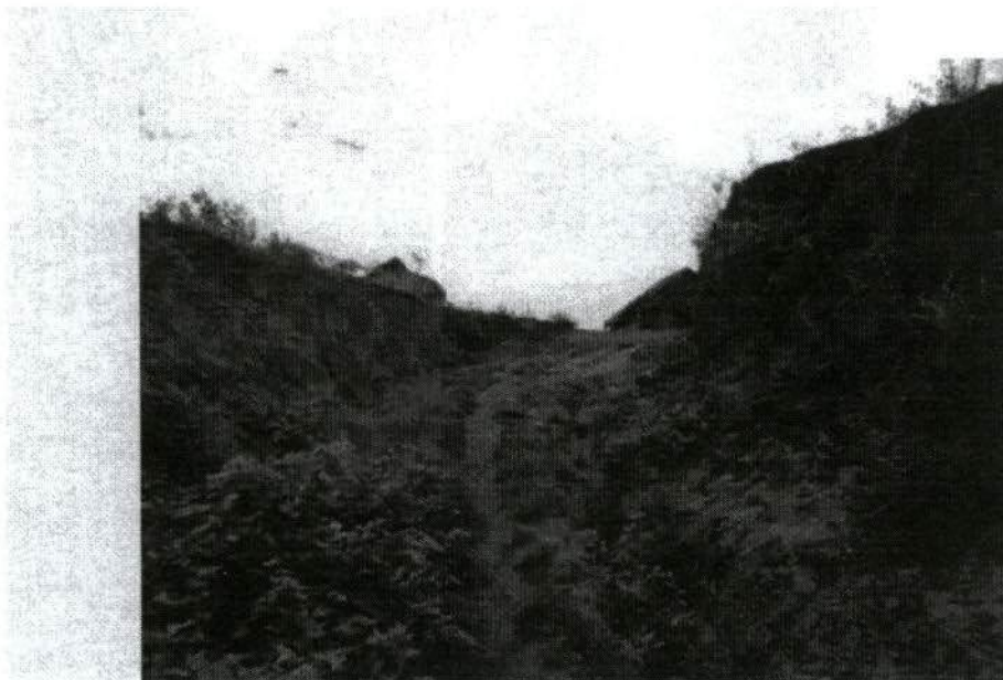
Foto 05 – Processo erosivo acelerado no acesso feito para passagem de maquinário para limpeza da área para construção das casas na Aldeia Raio do Sol, etnia Parakanã, às margens do rio Xingu.
