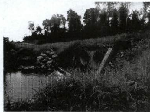
Foto 4 – Bueiros instalados sob o Travessão 50.
