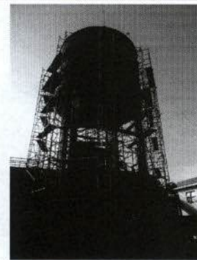
Foto 2 – Obras na Estação de Tratamento de Água de Altamira.
