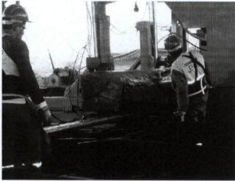
Foto 31 – Serraria em funcionamento.
