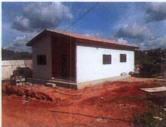
Foto 01 – Construção da moradia de Pedro Benjô Cardoso no Povoado de Belo Monte
