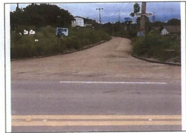
Foto 04- Melhoria da pavimentação em Belo Monte do Pontal
