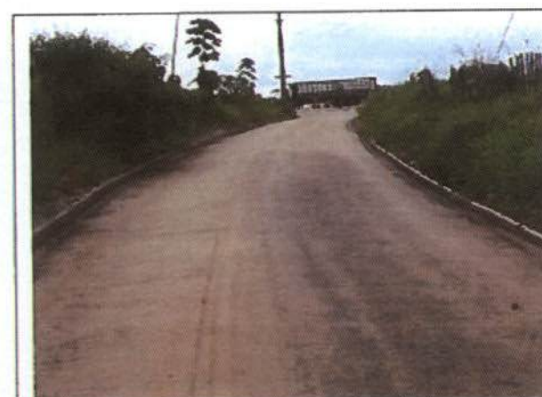
Foto 05- Melhoria da pavimentação em Belo Monte do Pontal
