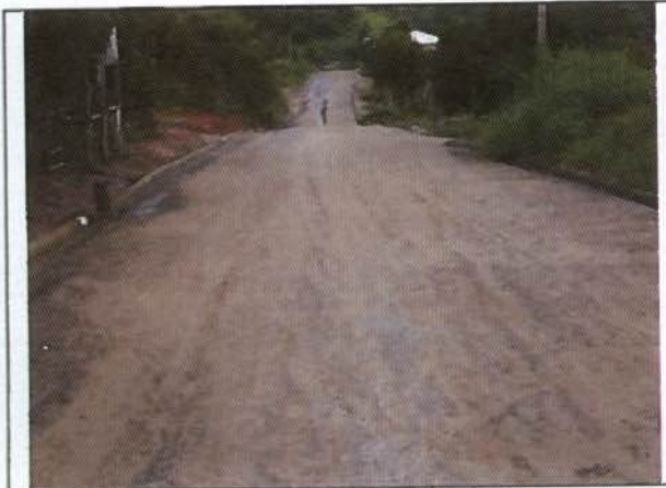
Foto 01- Melhoria da pavimentação em Belo Monte do Pontal
