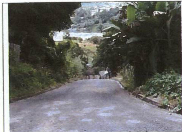
Foto 03- Melhoria da pavimentação em Belo Monte do Pontal
