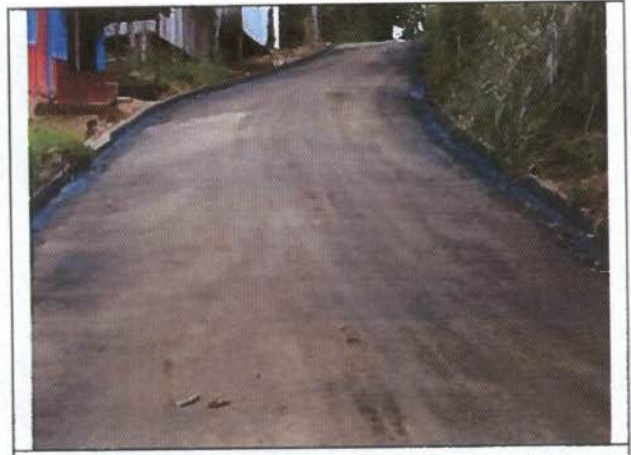
Foto 02- Melhoria da pavimentação em Belo Monte do Pontal
