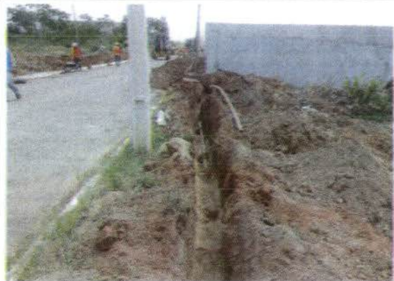
Figura 6 – Instalação de tubulação para rede de distribuição.
