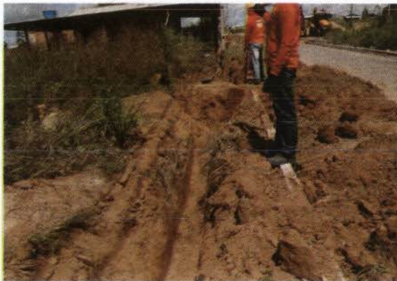
Figura 3 – Fechamento das valas após a instalação da tubulação em complementação a rede.
