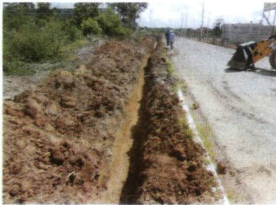
Figura 1 – Abertura de valas para ampliação da rede.
