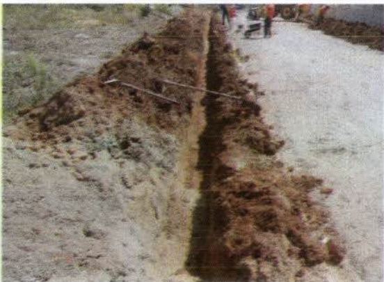
Figura 5 – Preparação de vala, com leito de areia.
