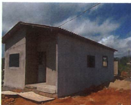
Foto 01 – Construção da moradia de Pedro Benjó Cardoso no Povoado de Belo Monte
