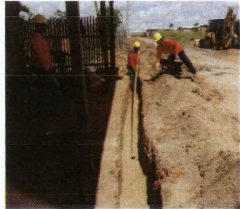
Figura 2 – Após preparação de vala, com leito de areia, instalação de tubulação para rede de distribuição.
