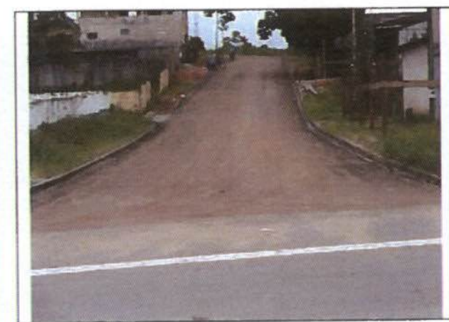
Foto 06- Melhoria da pavimentação em Belo Monte do Pontal
