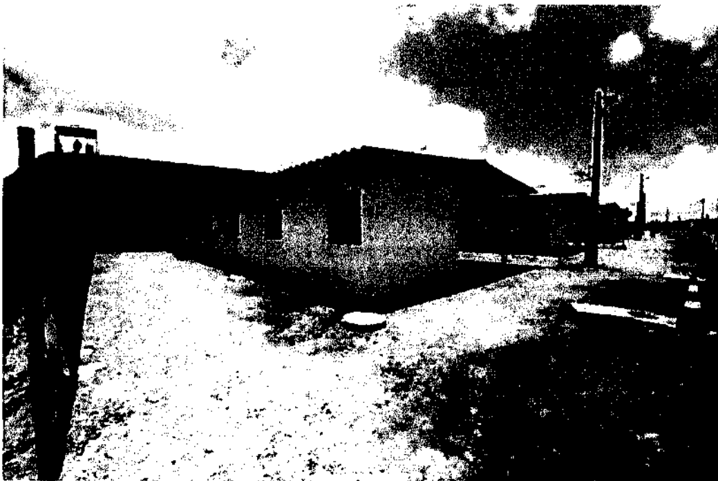
Figura 7 – Vista de detalhe das residências para os trabalhadores já concluídas e em condições de habitação no RUC São Joaquim
