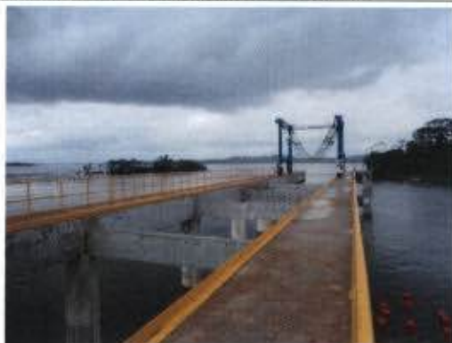
Foto 65 – Travel Lift instalado sobre o Pier de Jusante do STE – equipamento que tem a função de erguer as grandes embarcações.
