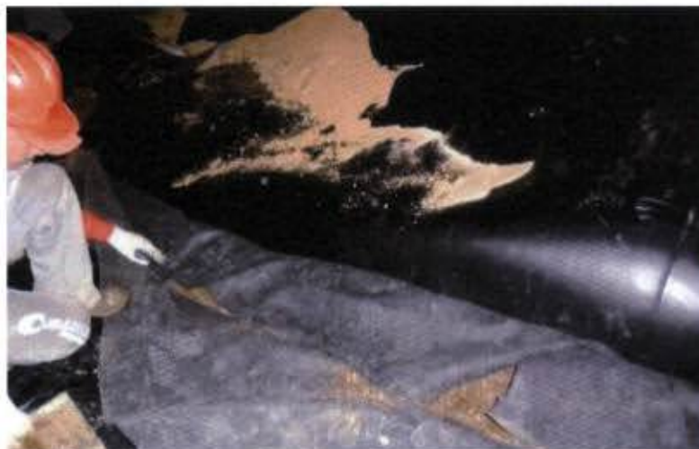
Foto 2.1-1 Detalhe do dreno interno com geomembrana não-tecido
