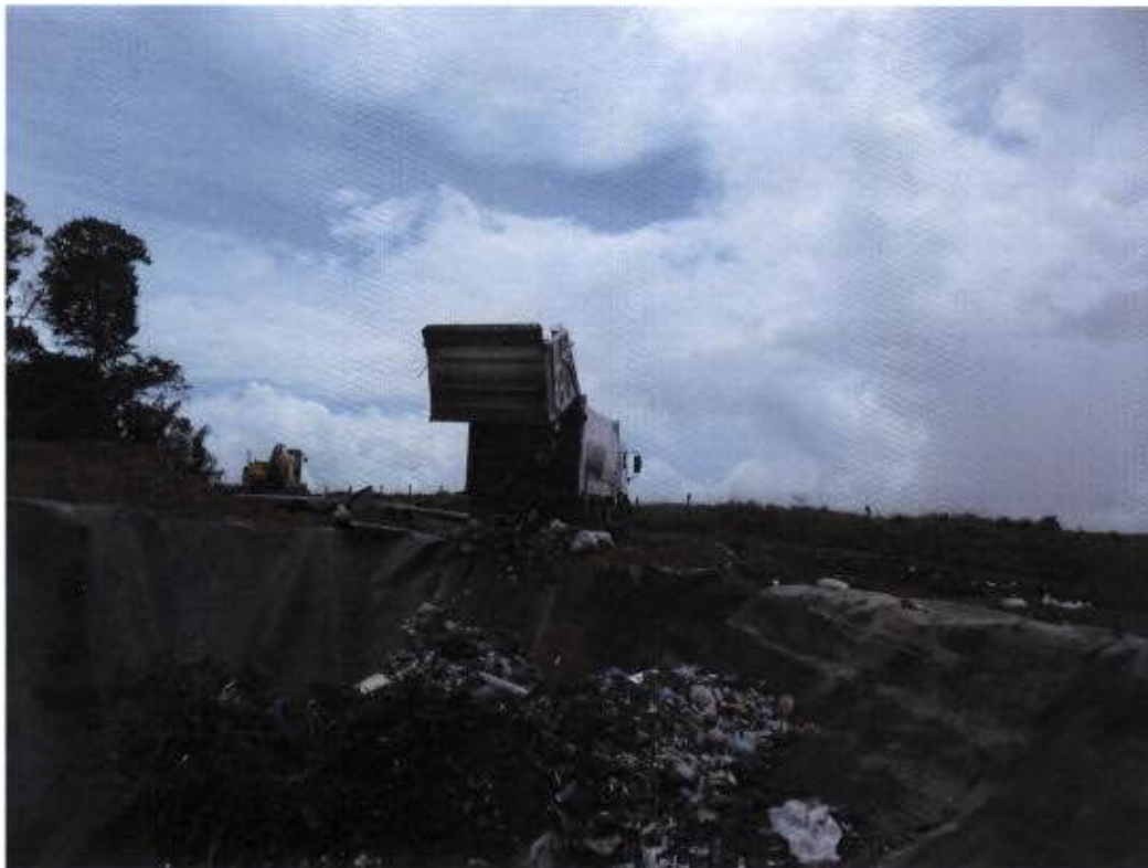
Figuras 2 e 3 Primeira célula do aterro sanitário de Vitória do Xingu já em operação
