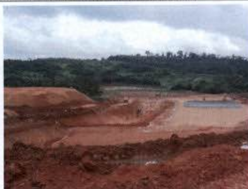
Foto 57 – Construção do Dique 28.
