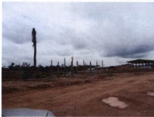
Foto 51 – Área onde será instalado o viveiro do canteiro Canal de Derivação.
