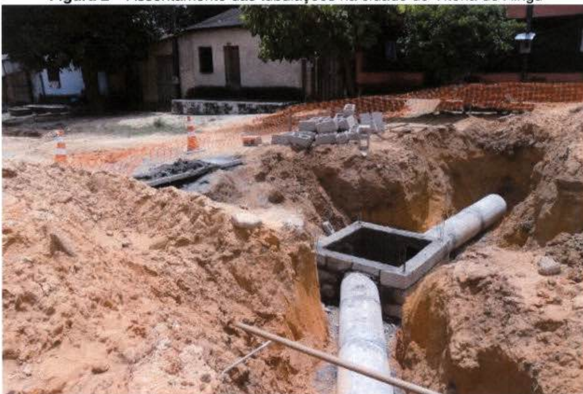
Figura 3 – Execução das obras dos poços de visita (PV's)
