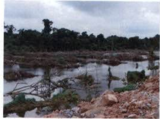
Foto 48 – Área suprimida onde não houve retirada de material e com as chuvas foi alagada. Este material deveria ter sido retirado a época da supressão.
