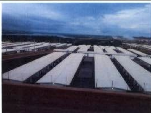
Foto 5 – Vista parcial dos alojamentos no canteiro Belo Monte.
