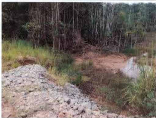
Foto 33 – Lançamento de cordão de rocha em APP para contenção de erosão.
