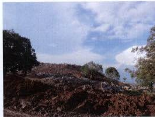
Foto 56 – Material sendo lançado em área que não passou por processo de supressão de vegetação – Bota-fora BF4 do sítio construtivo Belo Monte.
