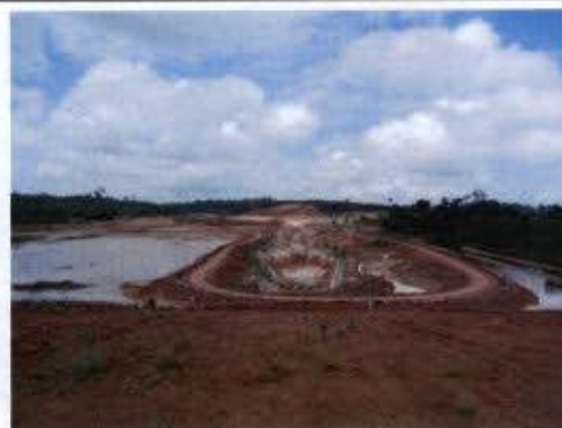
Foto 59 – Construção do Dique 19B.
