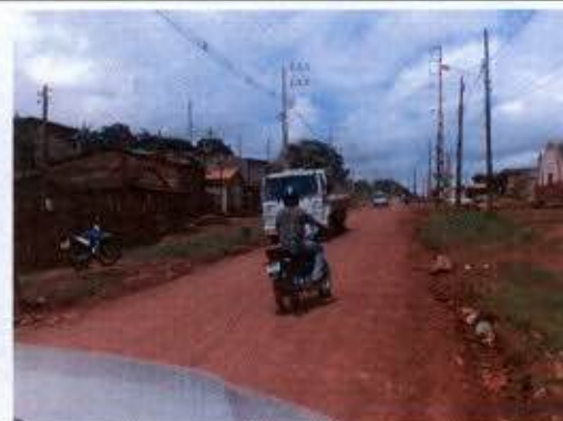
Foto 30 – Aspecto da BR-230 cortando a cidade de Altamira, com habitações e linhas de distribuição de energia elétrica em faixa de domínio da rodovia.
