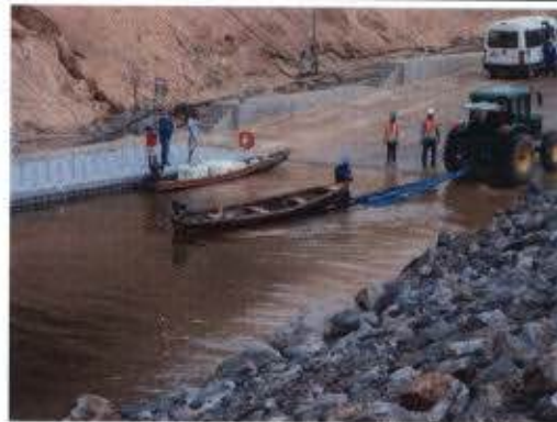
Foto 64 – Rabeta sendo transportada da rampa de jusante para a rampa de montante do STE.
