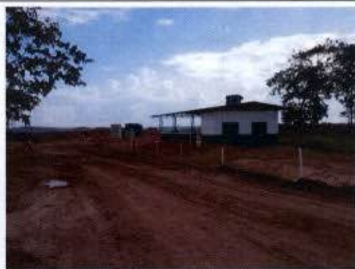
Foto 11 – Galpão de triagem de resíduos instalado pela Norte Energia que não vem sendo utilizado pelos catadores.
