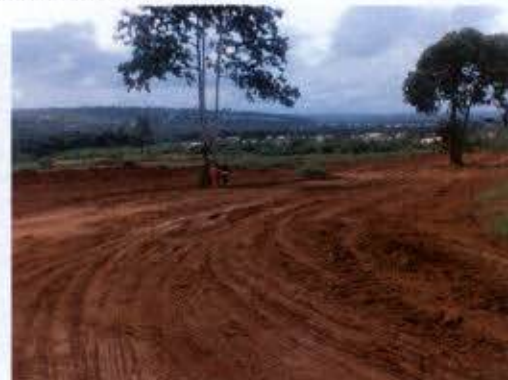
Foto 28 – Terraplanagem na gleba Jatobá.
