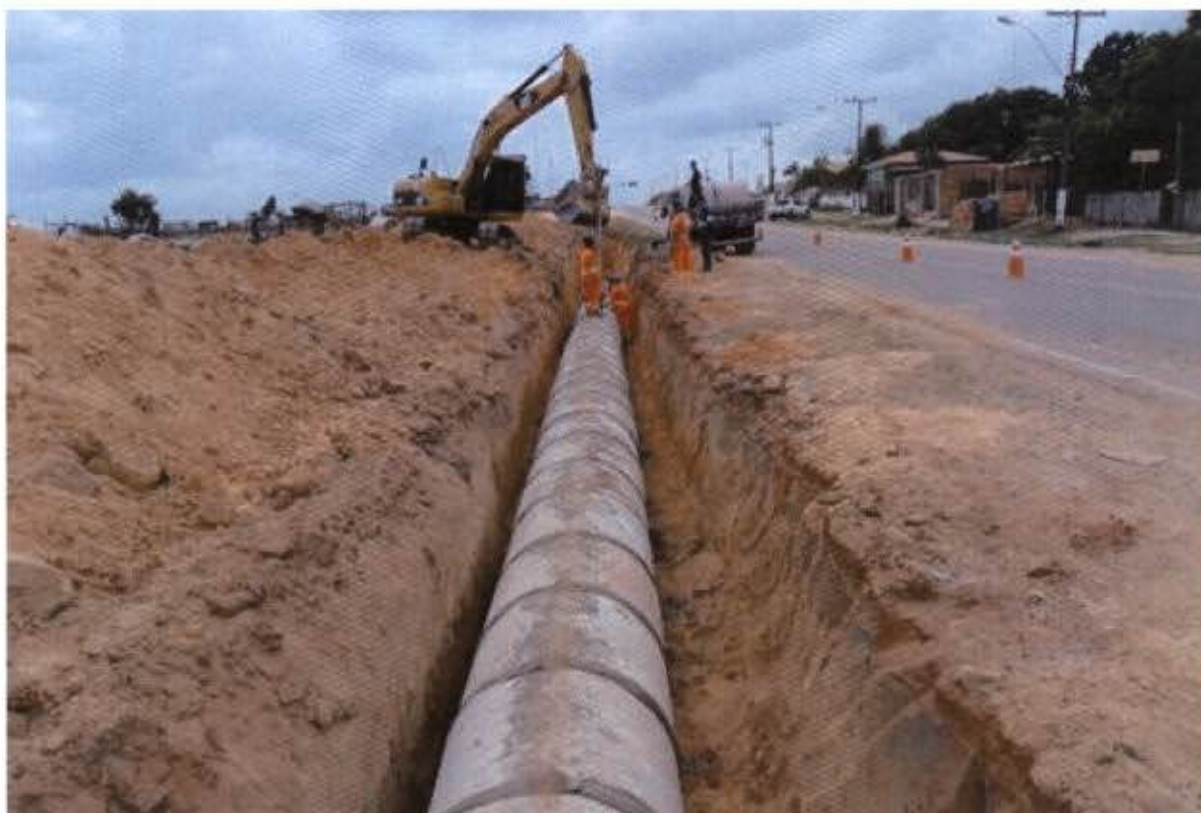
Figura 2 – Assentamento das tubulações na cidade de Vitória do Xingu
