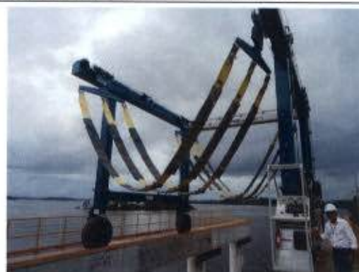
Foto 66 – Travel Lift instalado sobre o Pier de Jusante do STE.
