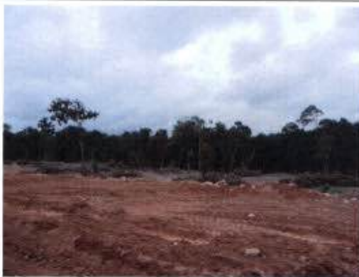
Foto 49 – Área suprimida em desconformidade com o POS. Supressão de madeira e brocagem realizados ao mesmo tempo.
