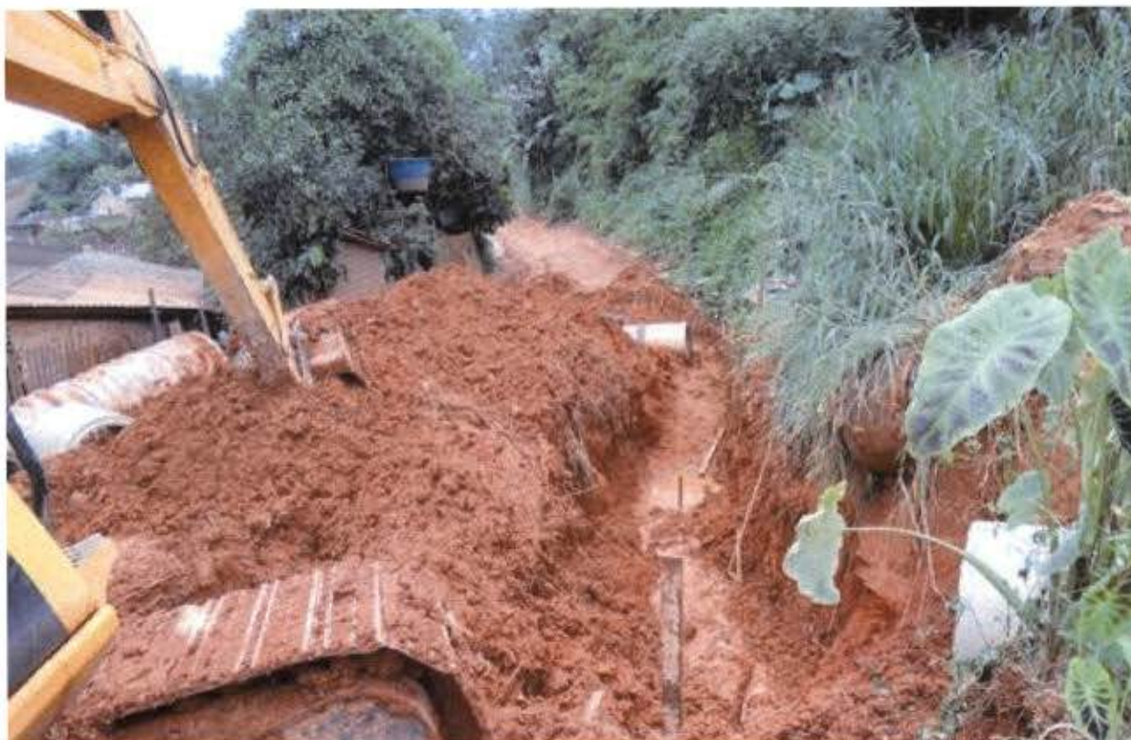
Figura 5 – Abertura das valas para assentamento das tubulações em Belo Monte
