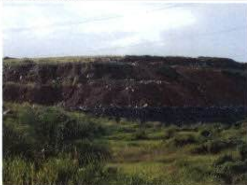
Foto 53 – Uma das faces do Bota-fora BF3 do sítio construtivo Belo Monte – Taludes e bermas irregulares.
