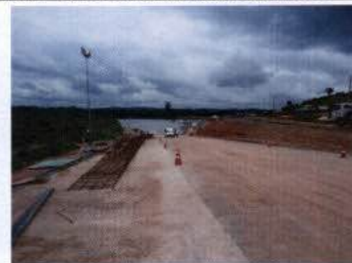
Foto 62 – Rampa de Montante do Sistema de Transposição de Embarcações.
