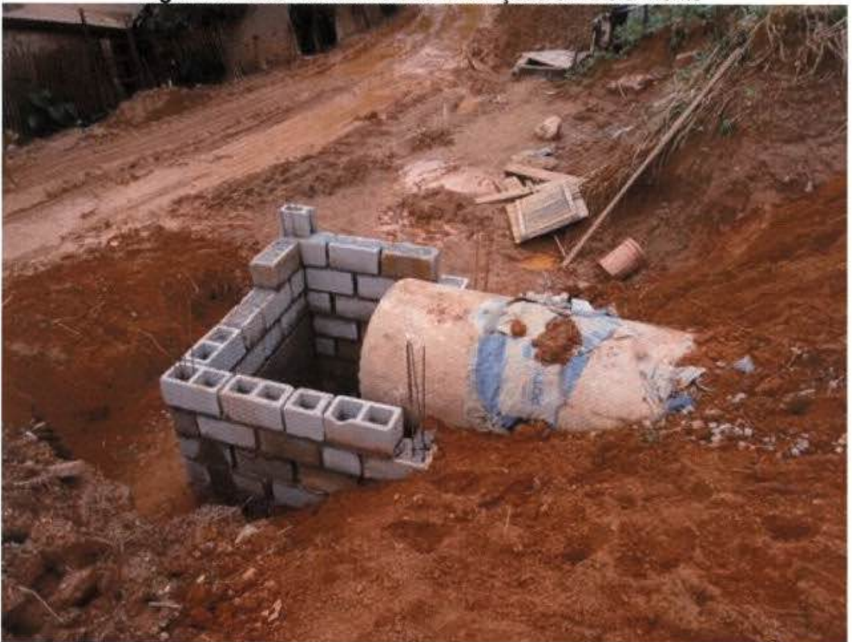
Figura 7 – Execução dos poços de visita (PV's) em Belo Monte
