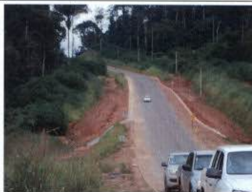
Foto 34 – Sistema de drenagem superficial sendo instalado no Travessão km 27 – em apenas um pequeno trecho do travessão o sistema foi implantado.
