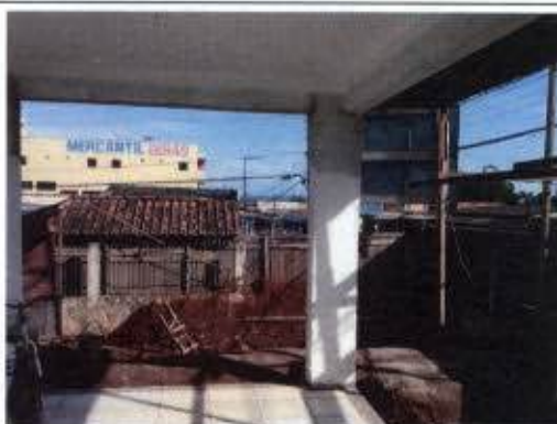
Foto 18 – Aspecto da construção da UBS Brasília.
