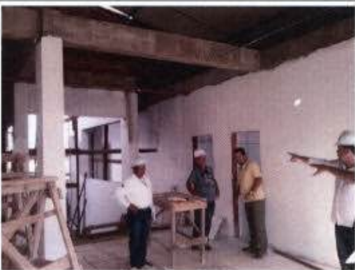
Foto 19 – Aspecto da construção da UBS Brasília.
