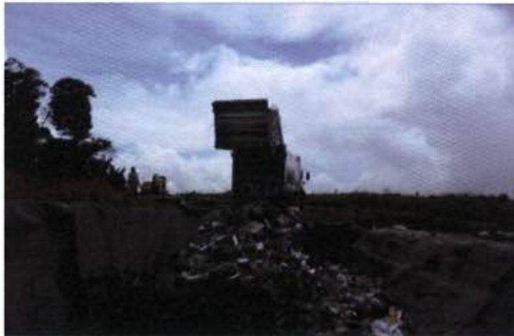
Foto 2.1-2 Resíduos sendo dispostos na célula pelo caminhão da Prefeitura.
