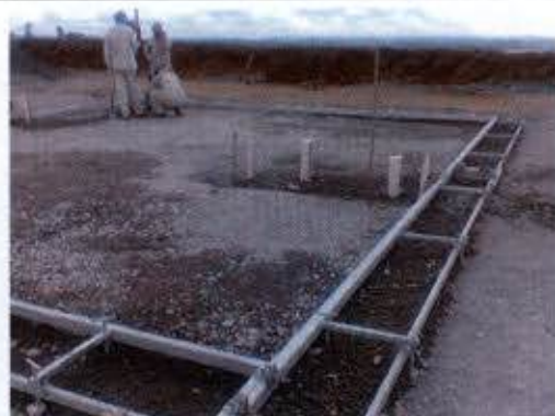
Foto 27 – Detalhe da implantação do radiator, gleba Jatobá.
