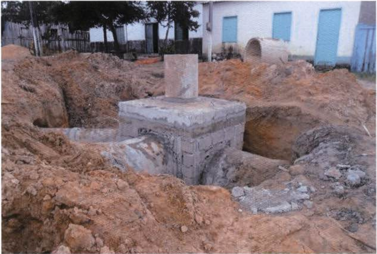
Figura 4 – Finalização das obras dos poços de visita (PV's)
