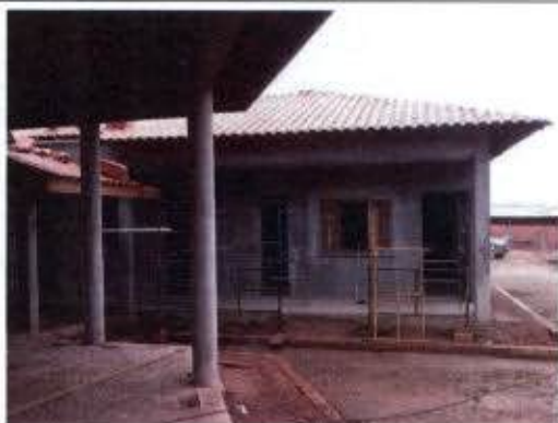
Foto 1 – Construção de escola em Vila Izabel, Anapu.
