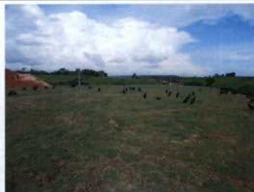
Foto 10 – Uma das células do Projeto de Remediação do Lixão já finalizada.
