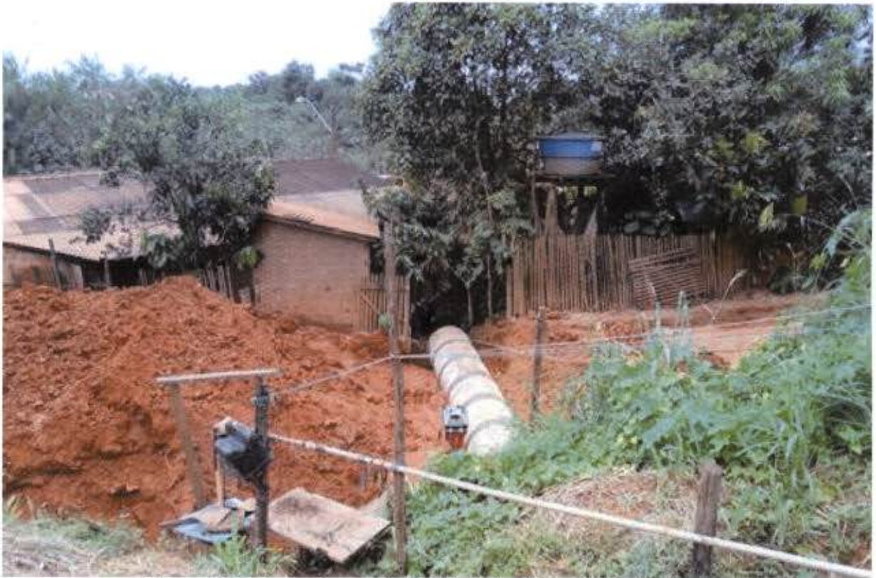
Figura 6 – Assentamento das tubulações em Belo Monte
