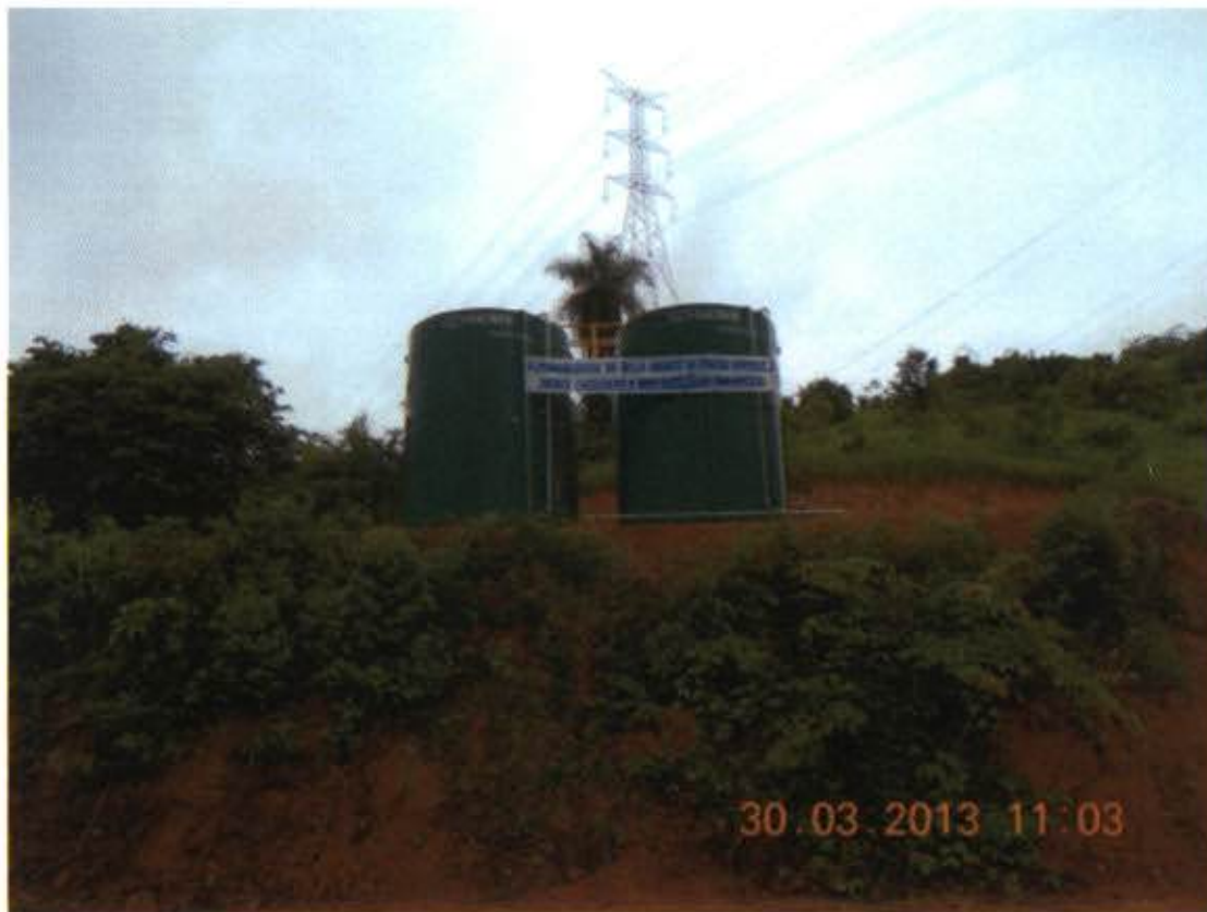
Figuras 5 e 6 - Tanques dispostos da ETE Belo Monte do Pontal – Município de Anapu
