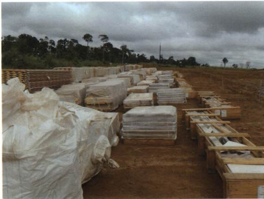
Figura 5 – Implantação das obras para a vila residencial dos trabalhadores em Altamira – Painéis das casas
