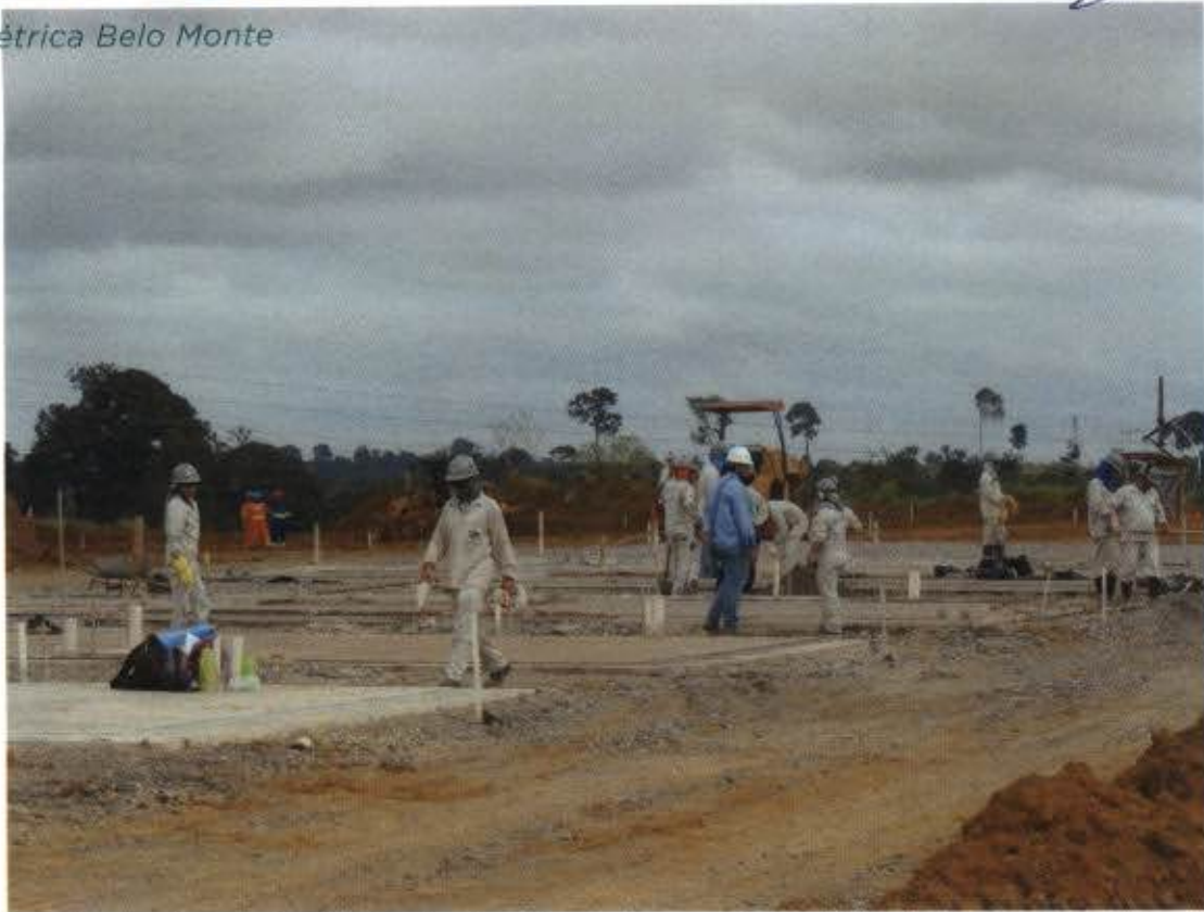
Figura 4 – Implantação das obras para a vila residencial dos trabalhadores em Altamira – Radiers executados
