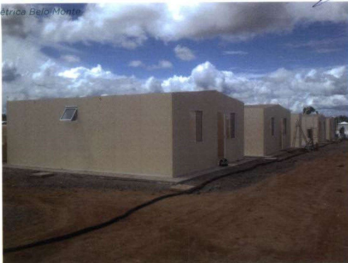
Figura 6 – Implantação da vila residencial dos trabalhadores em Belo Monte – Montagem das casas
