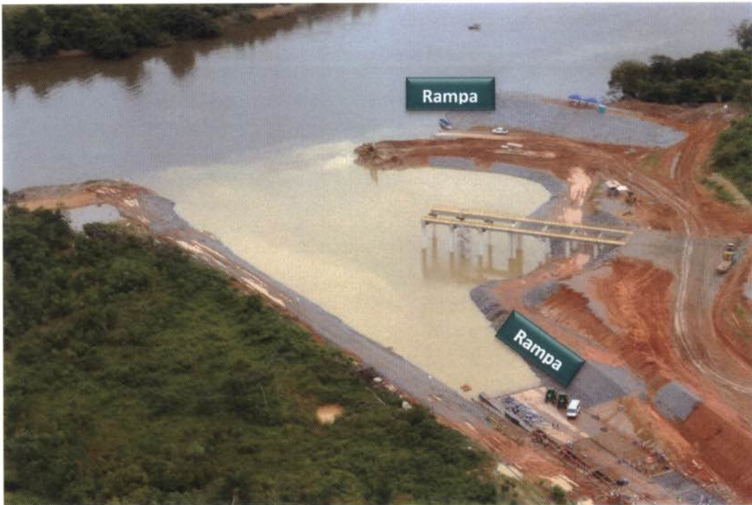
Sistema de Transposição de Embarcações - Pier montante
