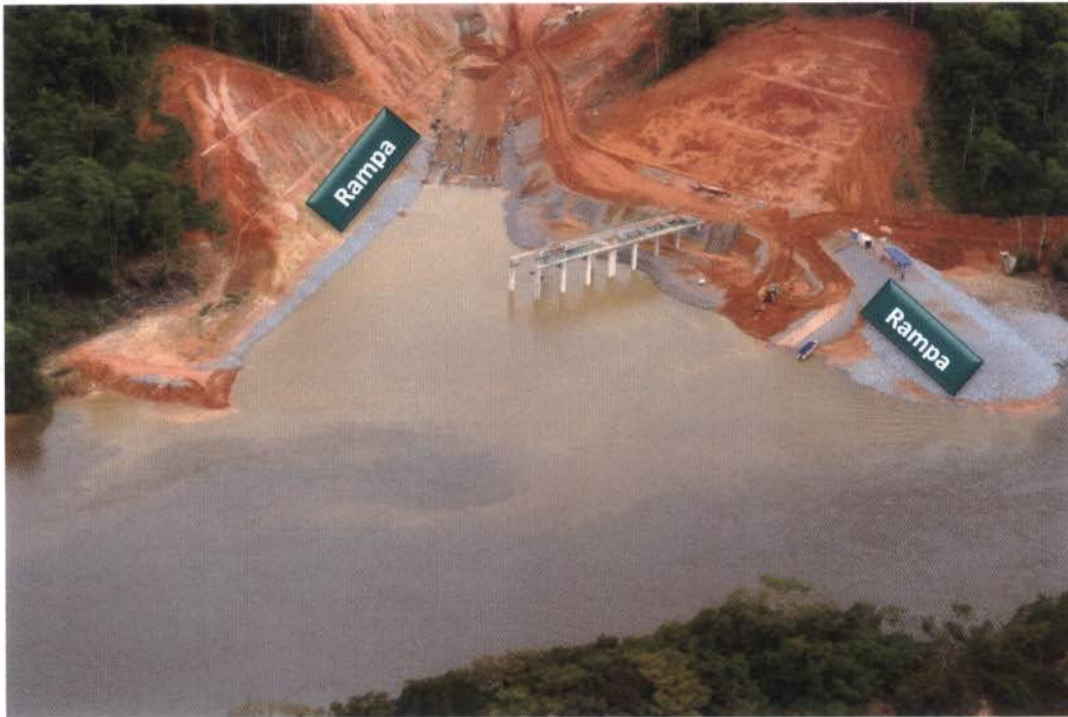
Sistema de Transposição de Embarcações - Pier jusante
