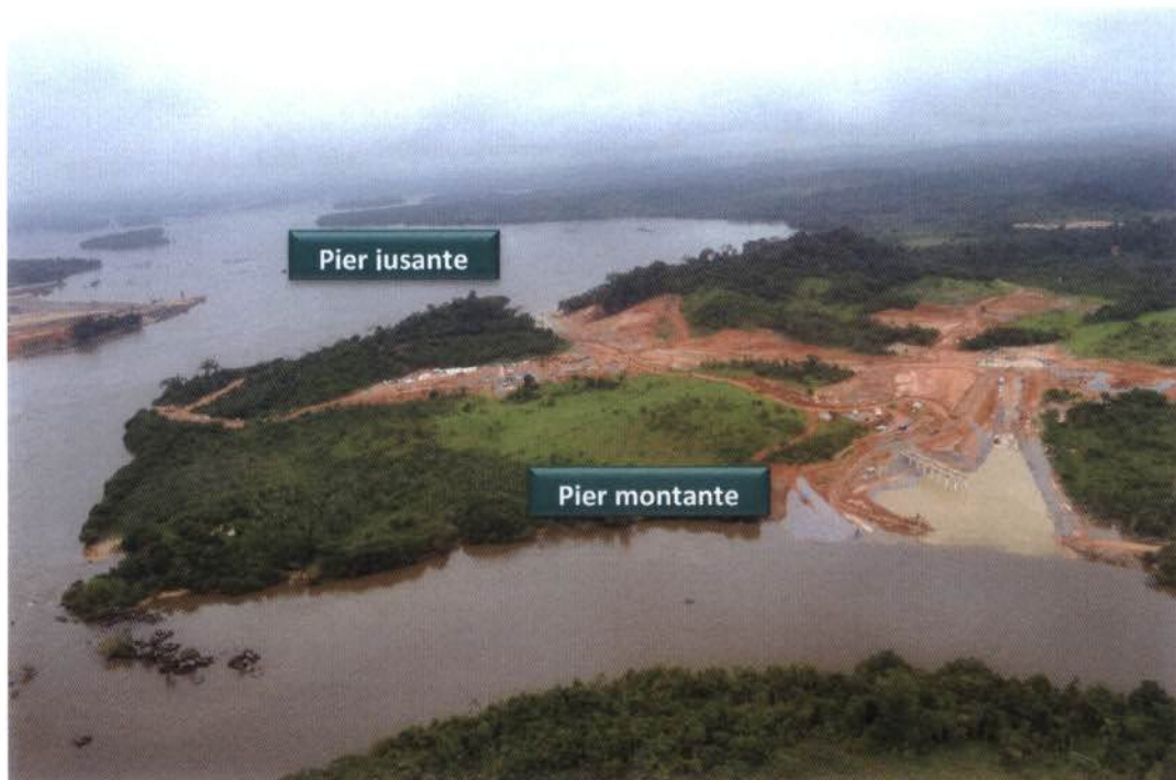
Sistema de Transposição de Embarcações – Vista Geral
