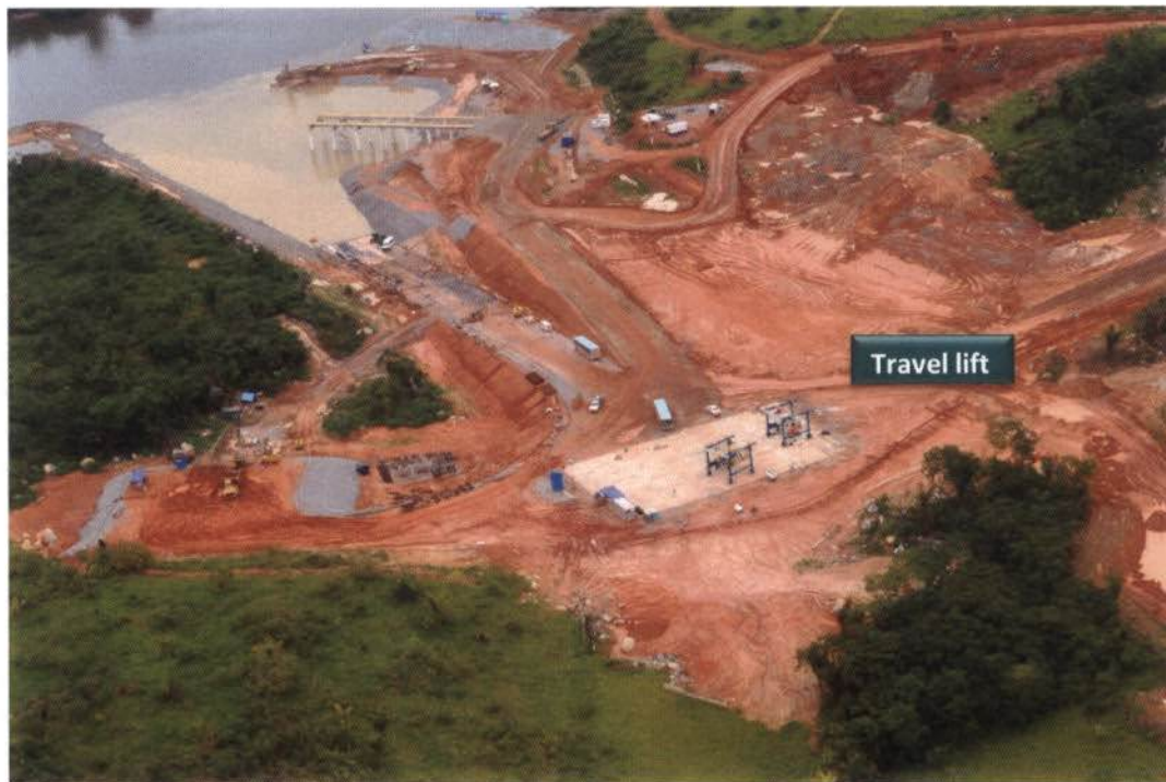
Sistema de Transposição de Embarcações - Pier montante
