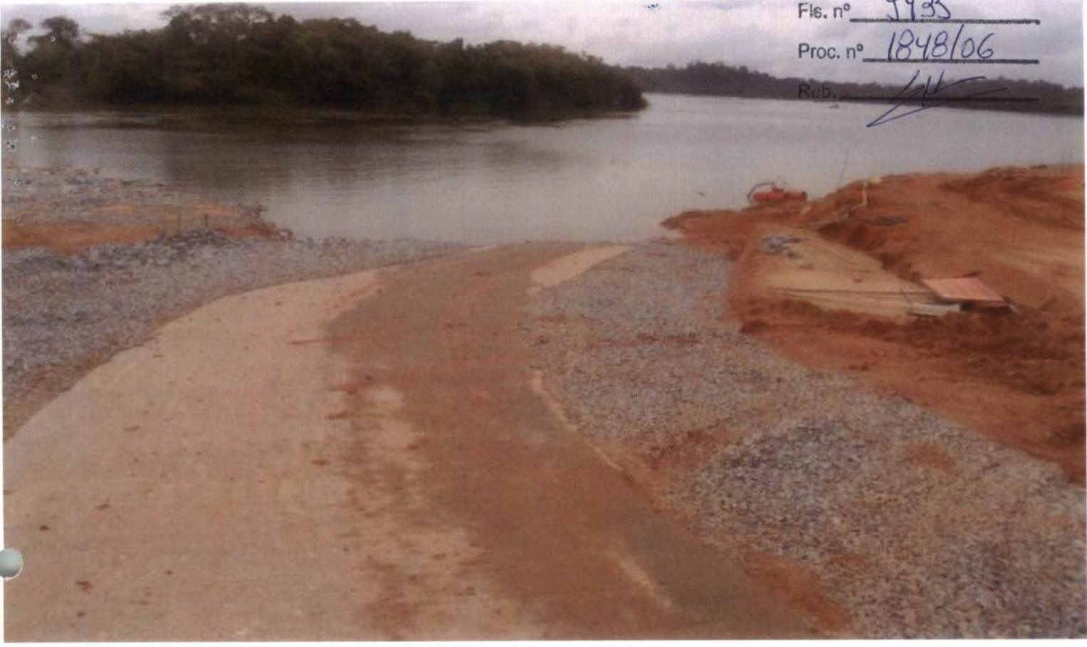
Rampa para pequenas embarcações, solução provisória
