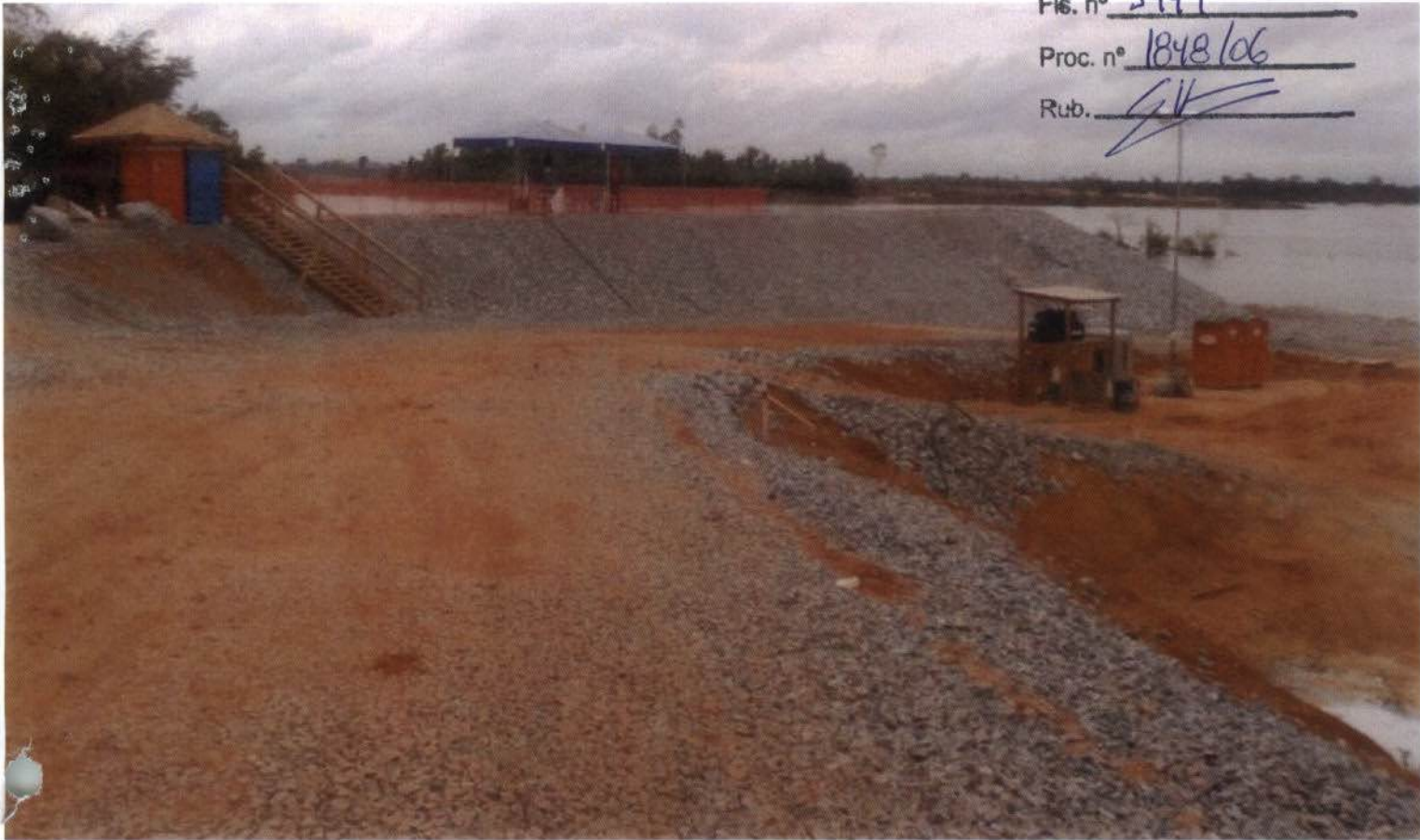
Rampa para pequenas embarcações, solução provisória
