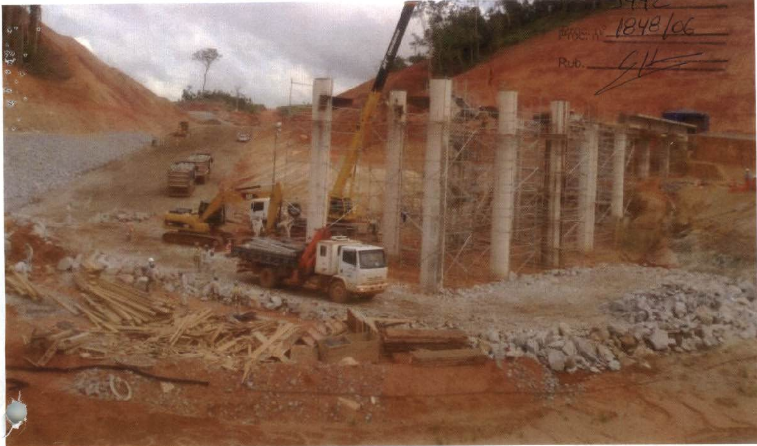
Pier de jusante situação das obras pilares e rampa de acesso
