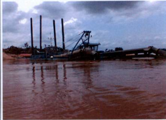
8. Dragagem próxima a parede da ensecadeira
