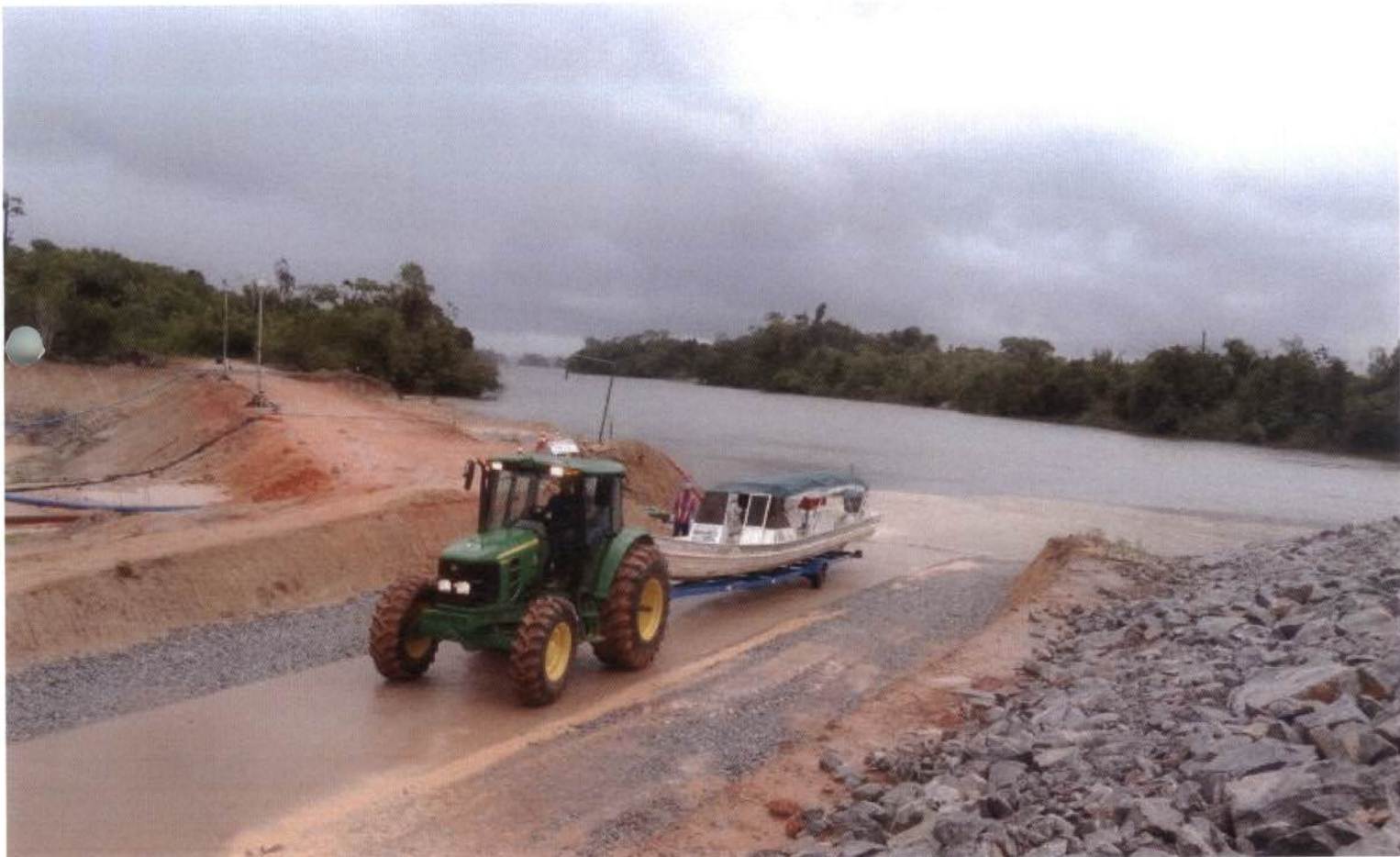
Operação de retirada de embarcação do rio no teste do sistema
