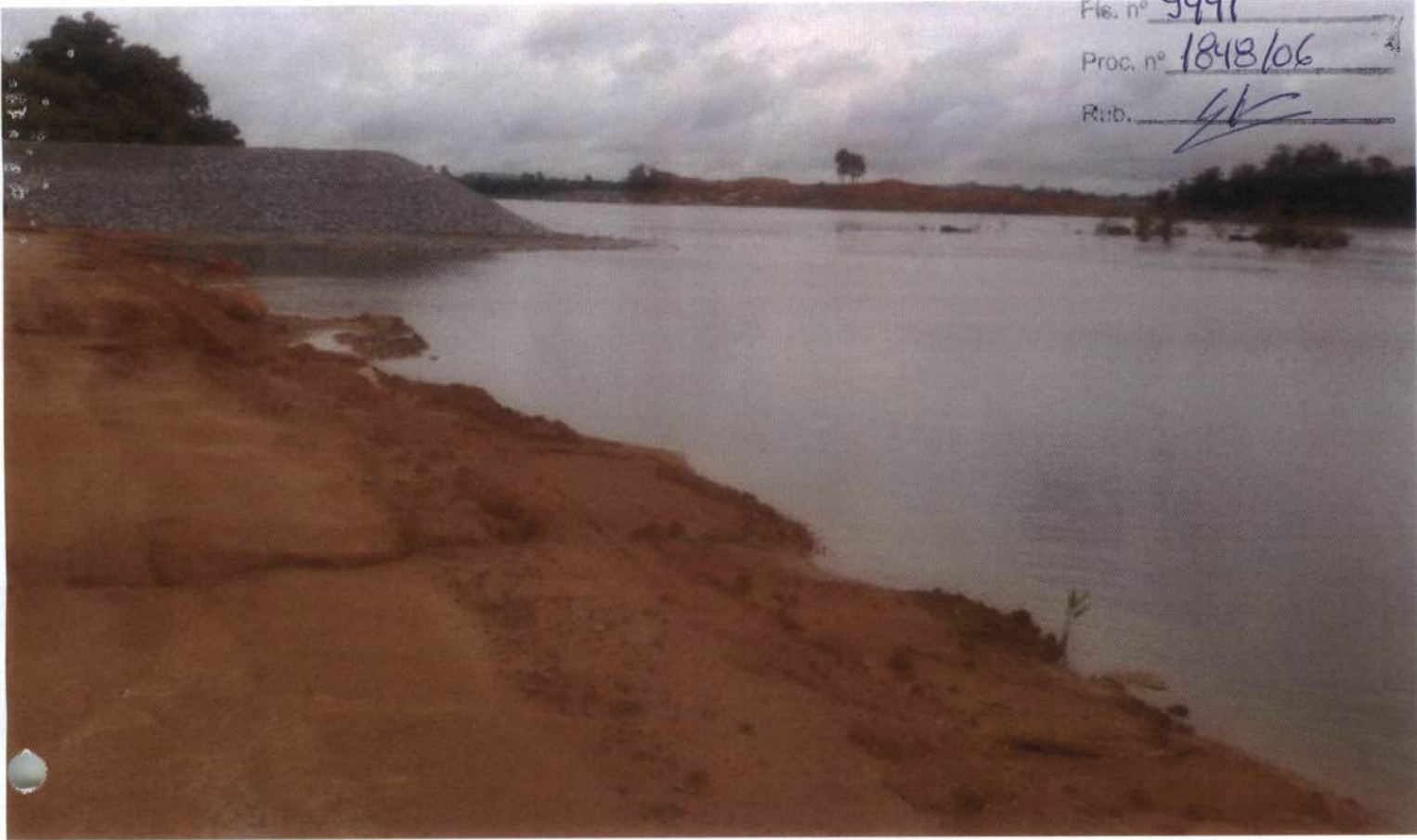
de jusante do píer de jusante, note-se o espigão lançado para direcionar o fluxo.
