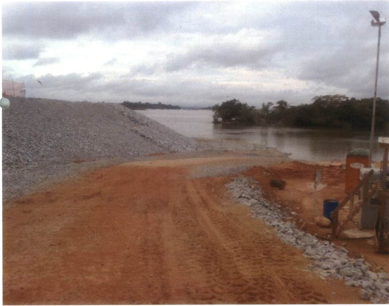
Rampa para pequenas embarcações, solução provisória
