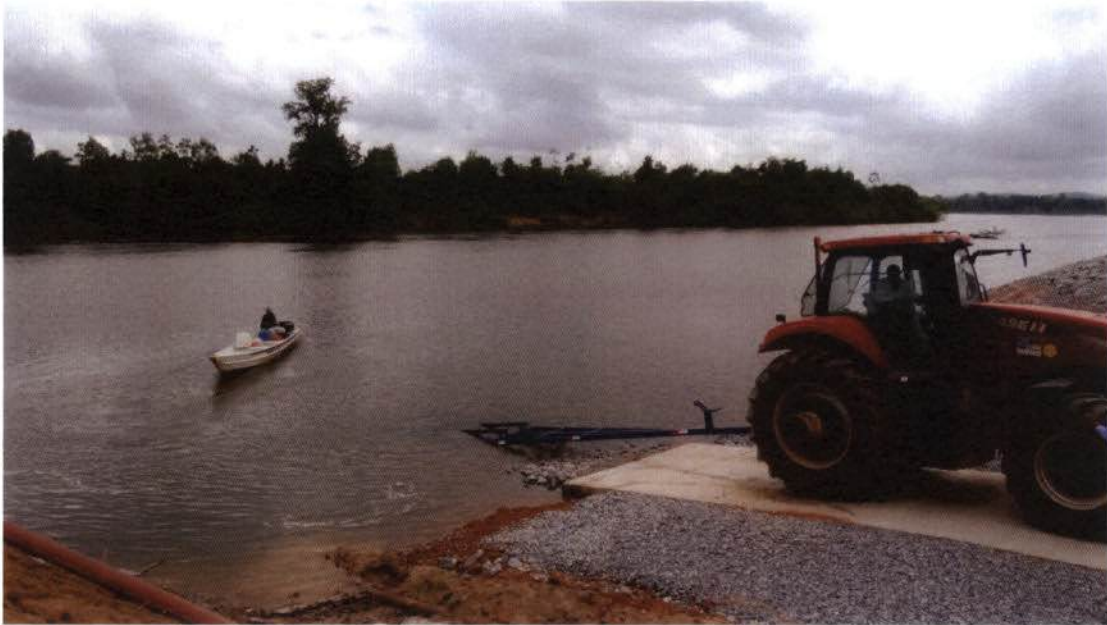
Aproximação de voadeira à rampa de montante
