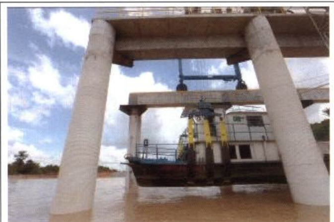
Foto 4 Início do processo de suspensão da embarcação
