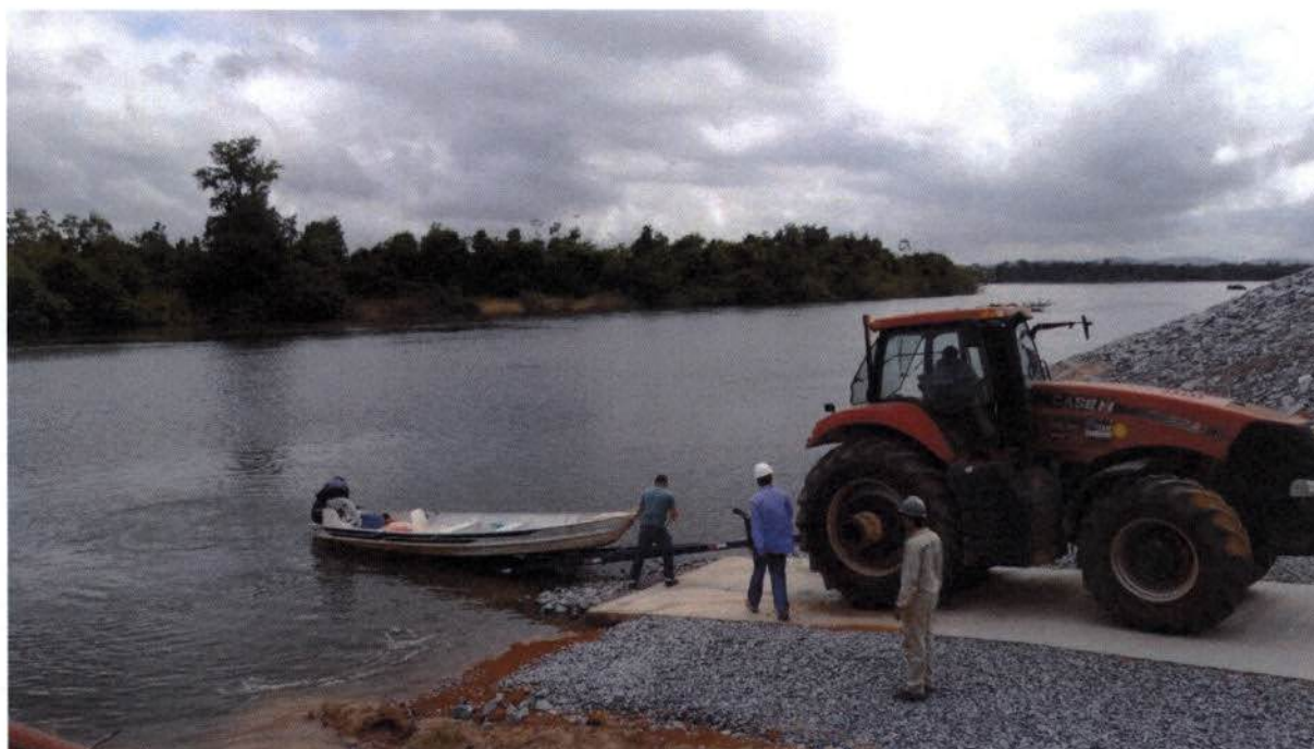
Voadeira sendo acoplada à carreta de transporte – rampa de montante
