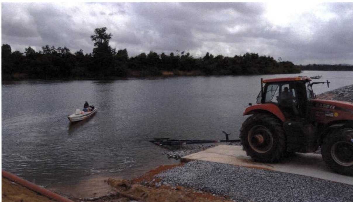
Aproximação de voadeira à rampa de montante
