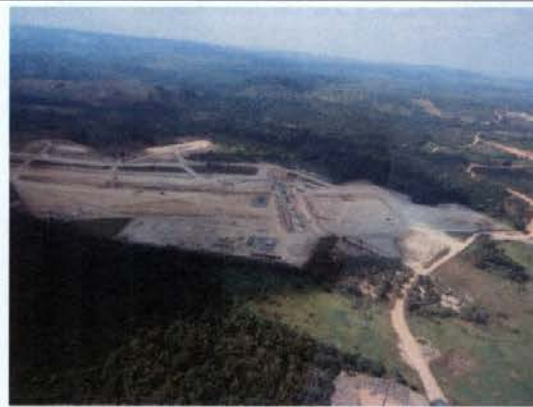
Fig 5 – Canteiro de Obras Sítio Bela Vista.
