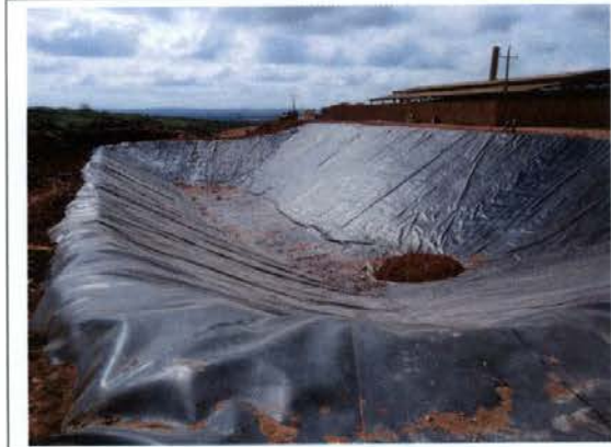
Fig 9 – Célula na remediação do lixão de Altamira.
