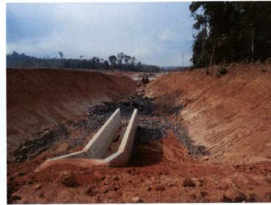
Fig 12 – Obras no canal de derivação.
