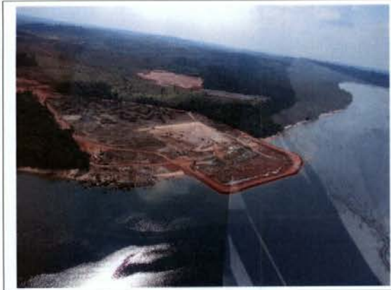
Fig 7 – Obras do Porto da Norte Energia.
