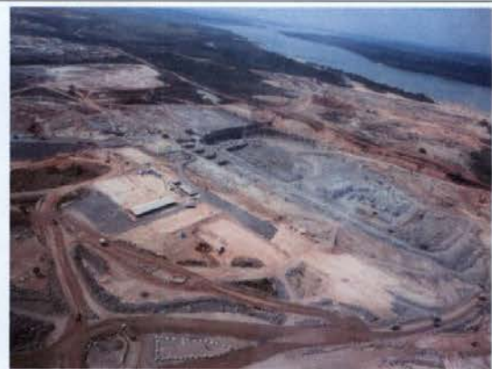
Fig 6 – Canteiro de obras Sítio Belo Monte.
