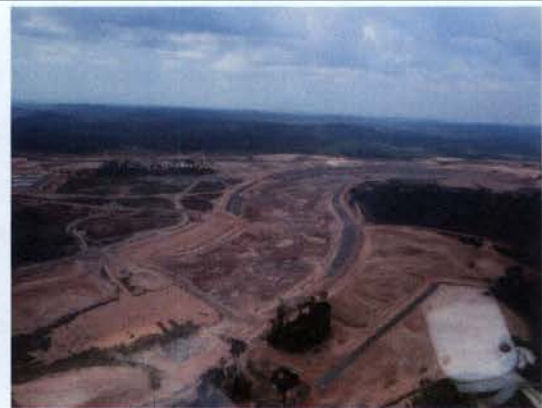
Fig 4 – Canteiro de obras do Sítio do Canal.
