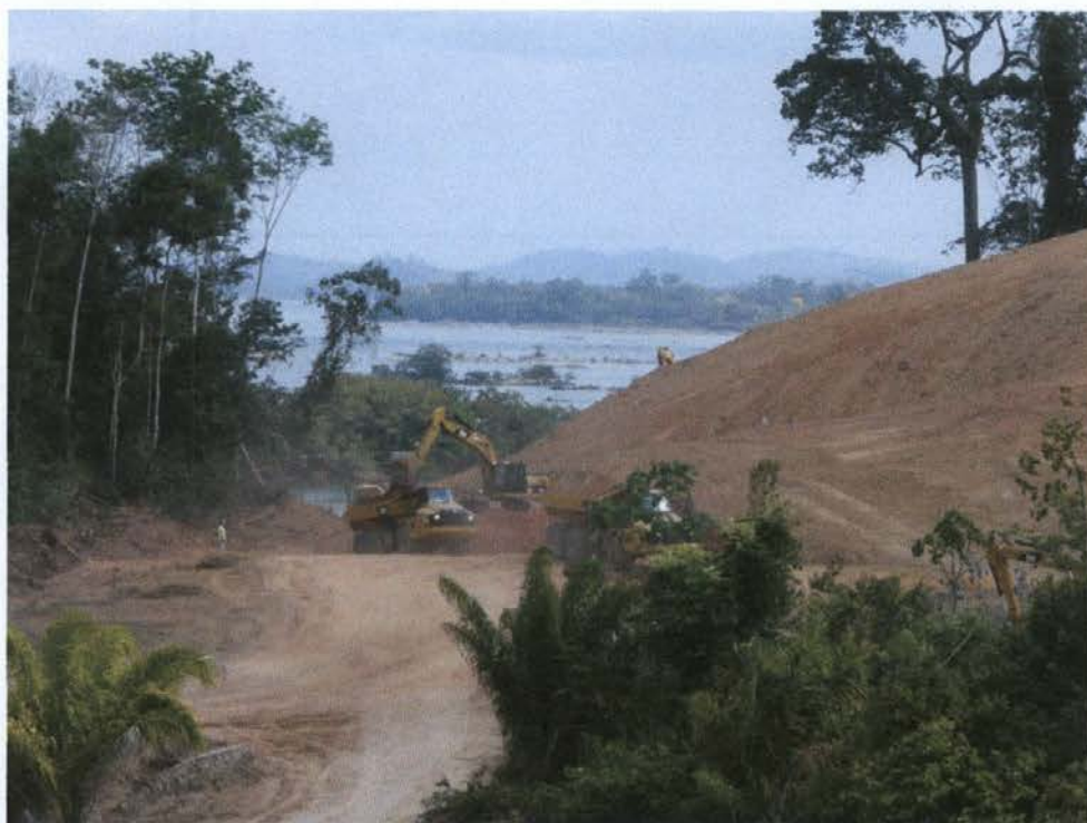
Vista das obras em execução, com o rio a jusante.
