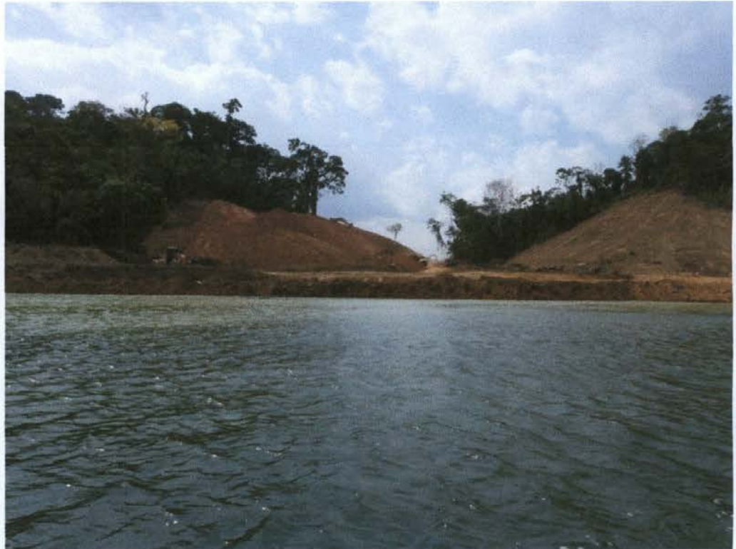
Vista das obras em execução a partir de jusante
