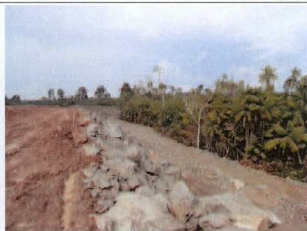
Foto 18 – Deposição de material não aproveitável no Bota-fora 18 do Canal de Derivação.
