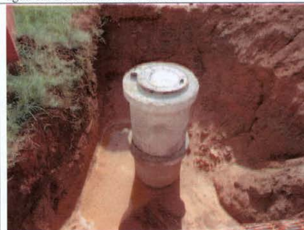
Foto 31 – Poço de visita recém instalado – sistema de esgotamento sanitário em Belo Monte do Pontal.
