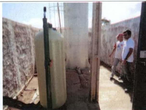
Foto 29 – Filtros instalados junto ao reservatório de água em Belo Monte do Pontal.
