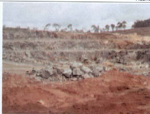
Foto 6 – Escavações obrigatórias em rocha na área de implantação da Casa de Força Principal e Tomada D'água.
