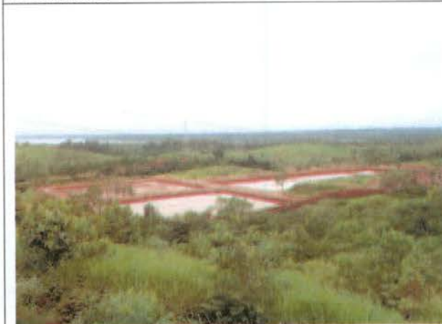
Foto 3 – ETE definitiva sendo implantada no sítio construtivo Belo Monte – lagoa facultativa seguida de duas de maturação.
