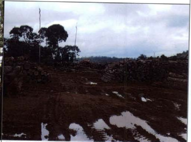
Foto 8. Pátio do canteiro de obra do Sítio do Canal e Diques.
