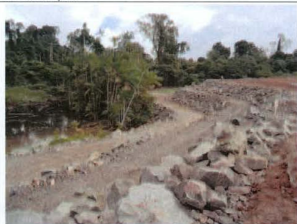
Foto 19 – Deposição de material não aproveitável no Bota-fora 18 do Canal de Derivação.
