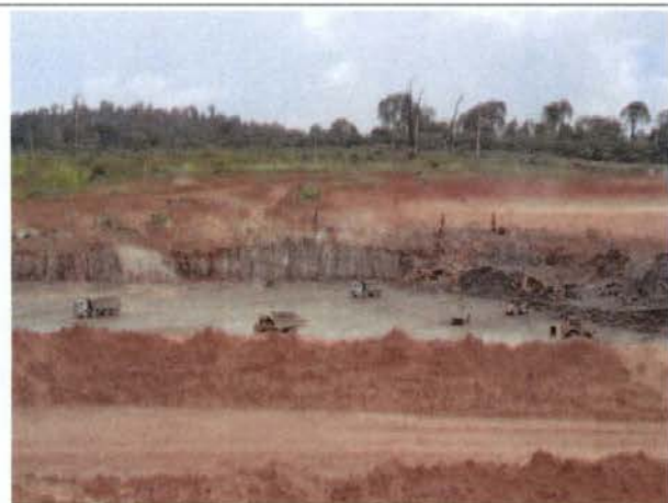
Foto 17 – Escavações obrigatórias em rocha no Canal de Derivação.
