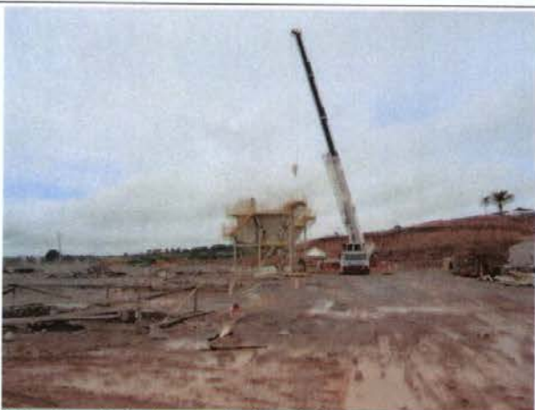
Foto 7 – Britador sendo instalado no sítio construtivo Belo Monte.
