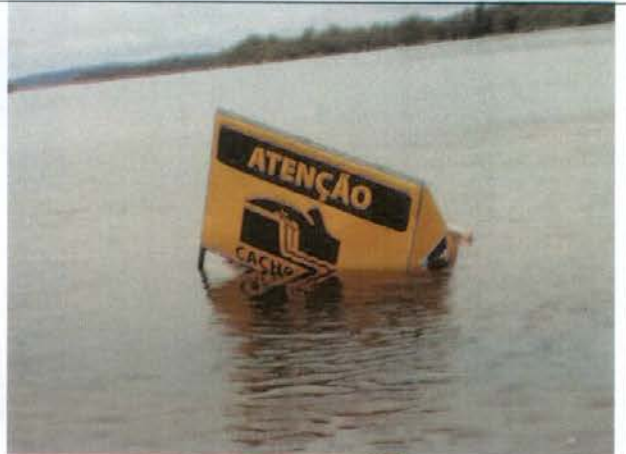
Foto 14 – Placa de alerta parcialmente submersa – necessidade de manutenção.
