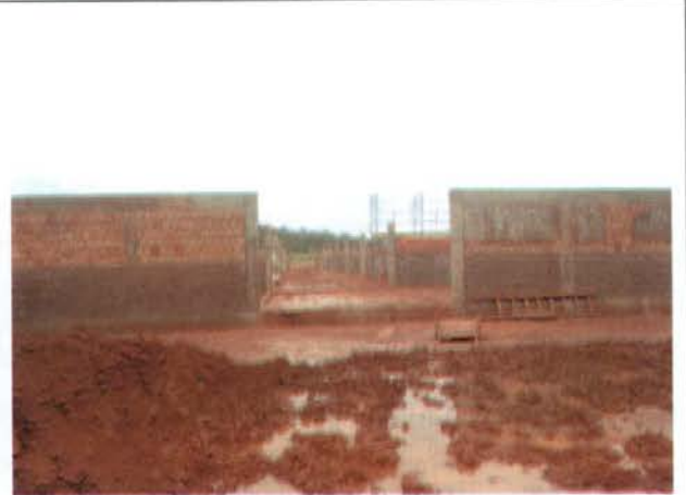
Foto 4 – Centro de triagem de resíduos em fase de implantação no sítio construtivo Belo Monte.
