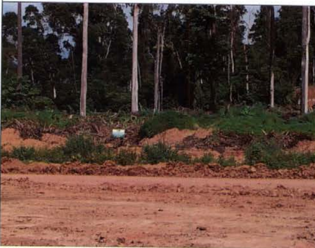
Foto 13. Depósito de galhada.
