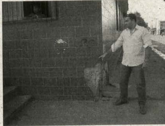
Fachada da Casa do Índio, na qual está sendo indicada a passagem da cota 100. No solo a cota é de 99,05m
