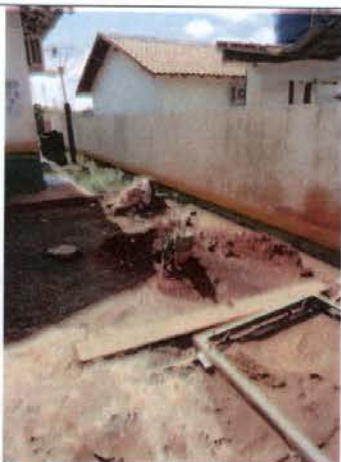
Foto 9 – Terceiro poço tubular recém perfurado pela Norte Energia para compor o sistema de abastecimento de água da localidade de Belo Monte.
