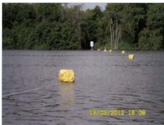
Figuras 13 e 14 - Instalação de barreira física, isolando área de acesso no trecho a montante da “cachoeira” e instalação de bóias na barreira física com sinalização noturna.
