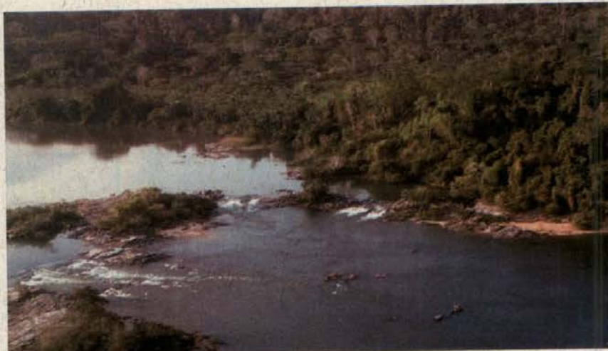
Local da Barragem da UHE Belo Monte, no rio Xingu
