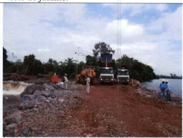
Foto 38 – Fechamento do acesso junto à ilha Pimental – fase de conclusão.
