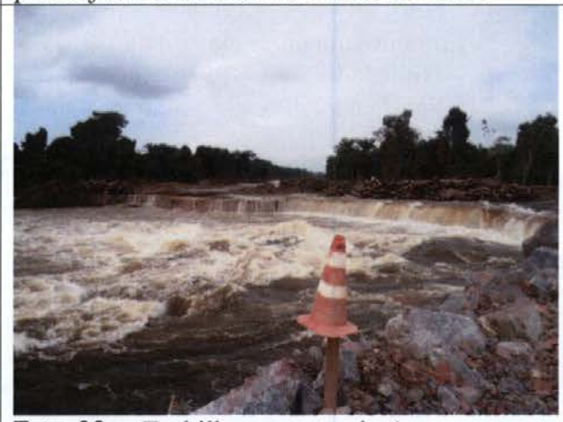
Foto 39 – Turbilhonamento da água no ponto de fechamento do acesso causando erosão na ilha Pimental e carreamento de sedimentos pela água.
