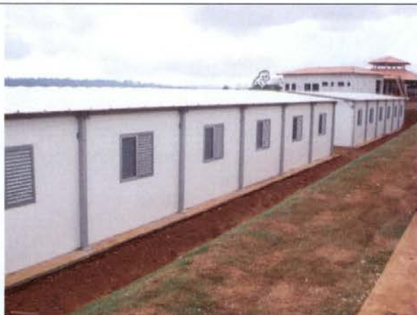
Foto 5 – Salas de aulas provisórias – Jd. França.
