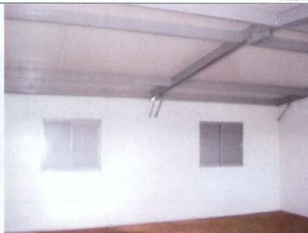
Foto 6 – Salas de aulas provisórias – Jd. França.
