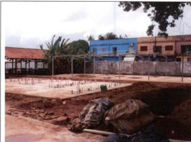
Foto 11 – Salas provisórias – EMEF Godim Lins
