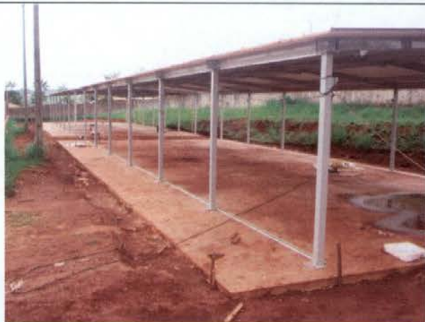
Foto 9 – Salas provisórias – EMEF Arthur Teixeira.
