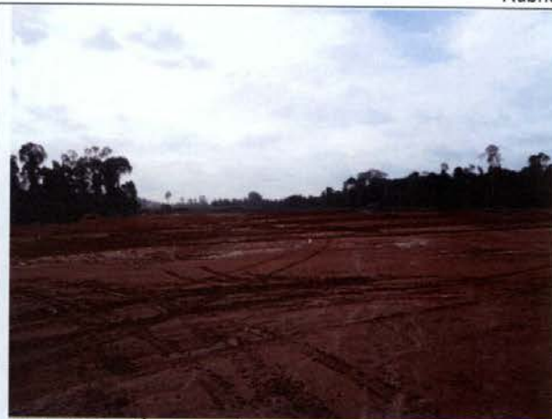
Foto 66 - Área onde será construída a estação de tratamento de esgoto do acampamento Canal de Derivação.
