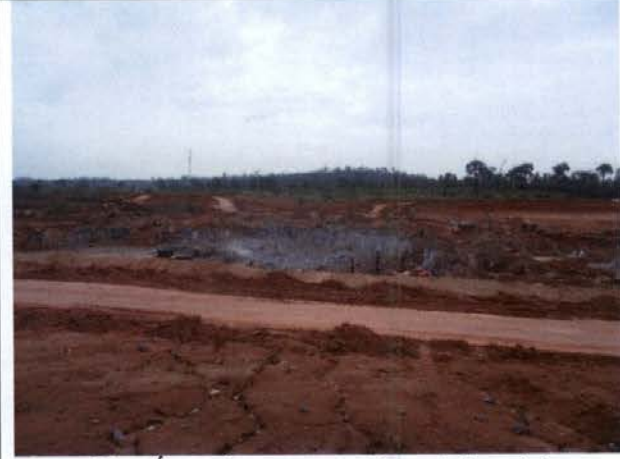
Foto 64 – Área das escavações obrigatórias em rocha no Canal de Derivação.
