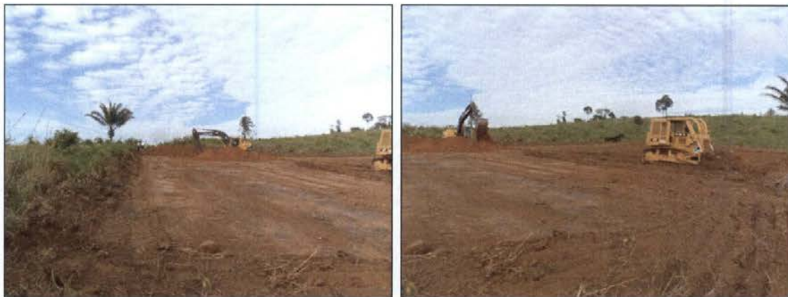
Figura 08 e 09 – Área de Instalação dos alojamentos Coordenada UTM: Zona 22M 9654666,058 / 411456,751
