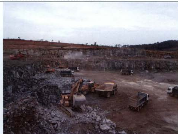
Foto 56 – Área de empréstimo de solo e rocha das escavações obrigatórias da tomada d'água e casa de força no sítio Belo Monte.
