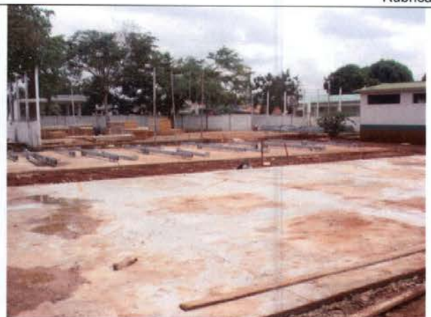
Foto 12 – Salas provisórias – EMEF Godim Lins
