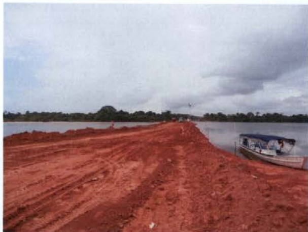
Foto 1 – Acesso as ilhas do Forno e Pimental sendo implementado.
