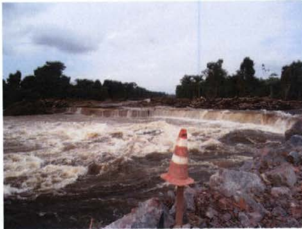
Foto 3 – Turbilhonamento da água no ponto de fechamento do acesso causando erosão na ilha Pimental e carreamento de sedimentos pela água.
