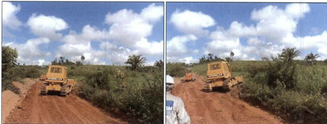
Figura 02 e 03 - Início da abertura do Acesso a área de Supressão Vegetal
