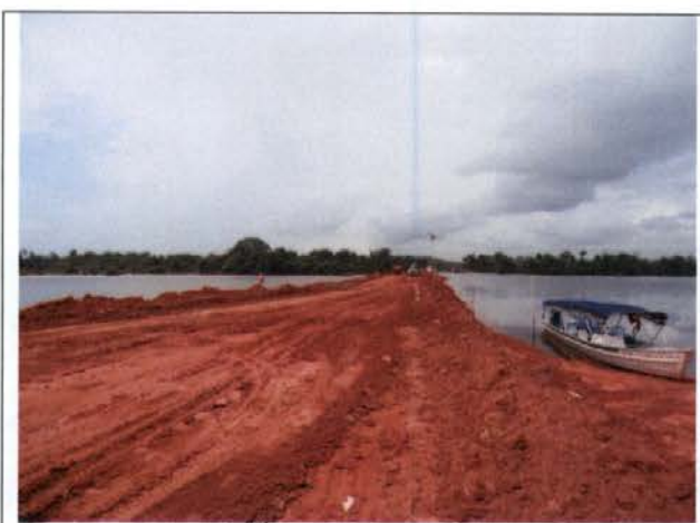
Foto 35 – Acesso as ilhas do Forno e Pimental sendo implementado.
