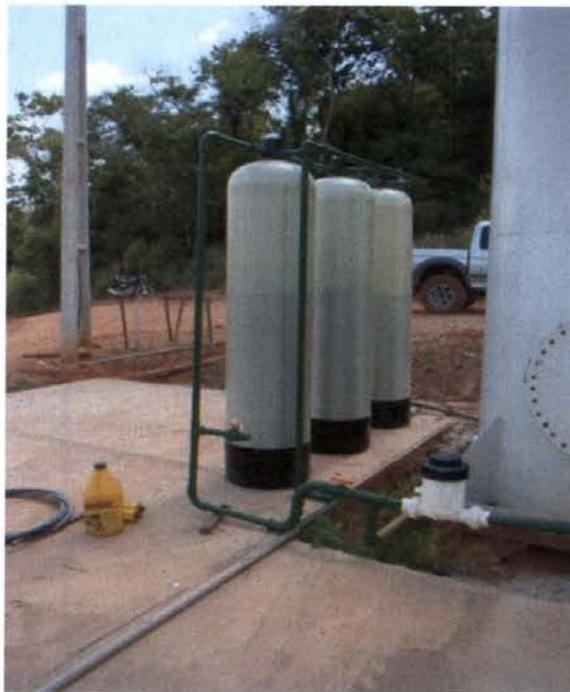
**Figura 1 - Sistema de tratamento da água proveniente dos poços tubulares profundos instalados nas comunidades de Belo Monte e Belo Monte do Pontal (Foto tirada em 09/12/12).**
