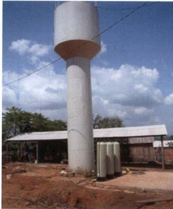
**Figura 2 - Vista geral do sistema de tratamento da água proveniente dos poços tubulares profundos (Foto tirada em 09/12/12).**
