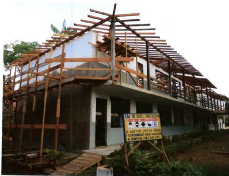
Reforma Pavilhão do Alojamento 16º Batalhão Polícia Militar – situação em 18.10.2011
