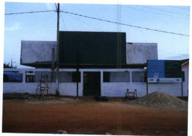
UBS Bela Vista - Situação em 29.08.2011
