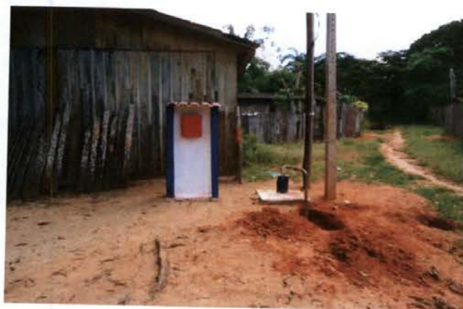
Rede Energia p/Poço – Situação 30.06.2011
