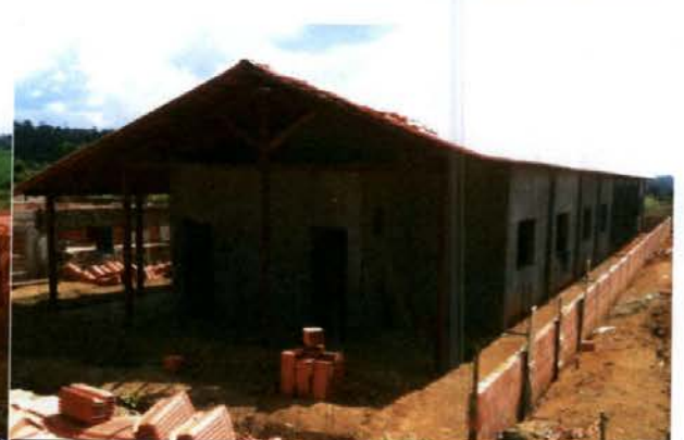
Escola Bom Jardim I - Situação em 29.08.2011
