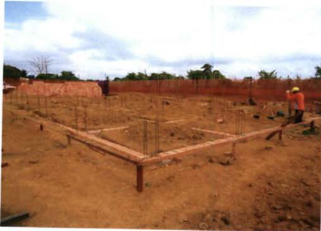
UBS – Bairro Liberdade - Situação 29.08.2011
