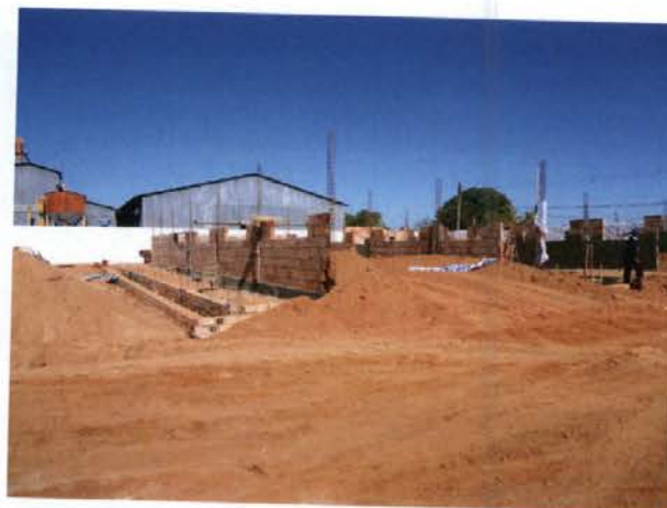
Situação em 25.07.2011- 4º Bloco
