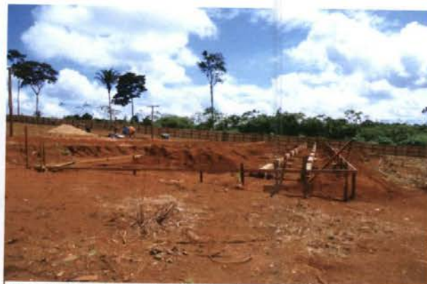
Escola Municipal de Ensino Fundamental (4 salas) – Jardim França – Situação em 23.05.2011
