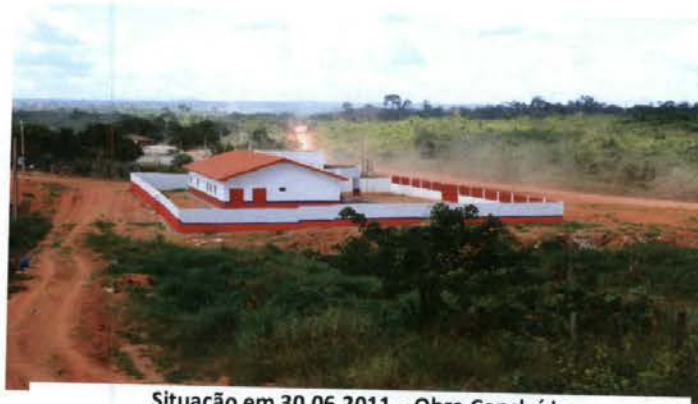
Situação em 30.06.2011 – Obra Concluída
