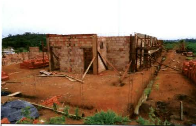
Escola Bom Jardim I - Situação em 30.06.2011
