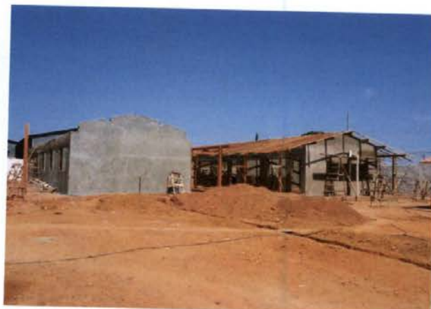
Situação em 29.08.2011- 4º Bloco com 05 de 20 salas de aula previsto para 31.12.2011
