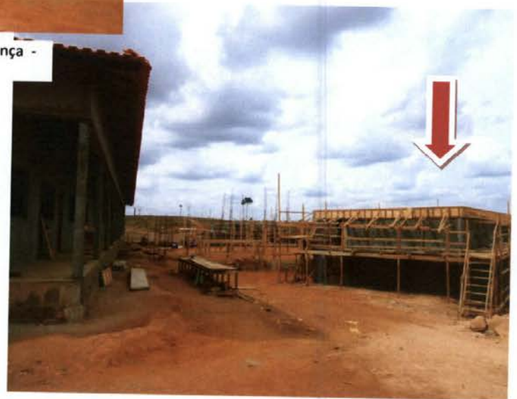
Escola Municipal de Ensino Fundamental (4 salas) – Jardim França - situação em 18.10.2011
