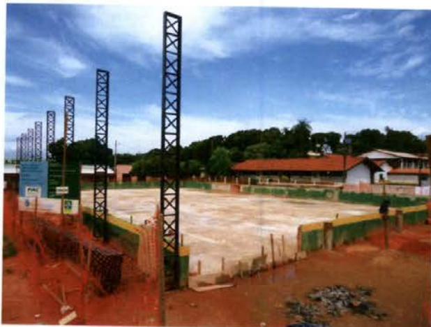
Cobertura Quadra poliesportiva Escola Evangelho – Situação em 30.06.2011
