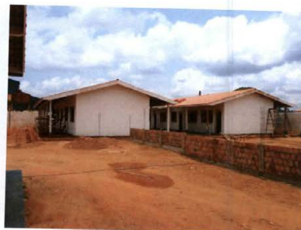
Situação em 27.09.2011- 4º Bloco com 05 de 20 salas de aula – previsto para 31.12.2011
