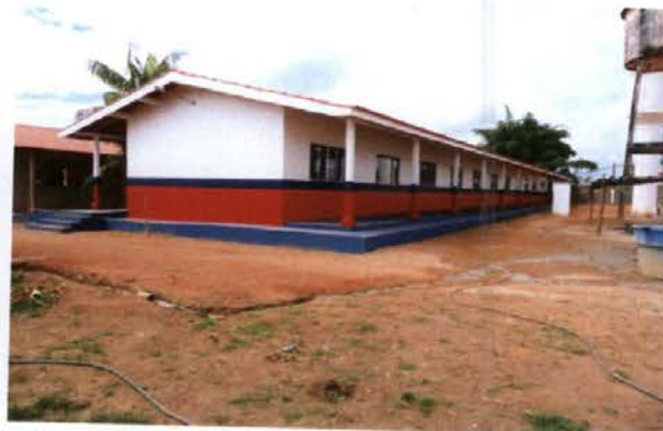
Situação em 20.06.2011 – 2º Bloco – CONCLUÍDO
