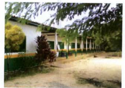
Escola e Creche Dulcinéia - Situação em 15.03.2011
