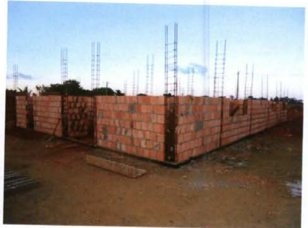
UBS – Bairro Liberdade - Situação 27.09.2011
