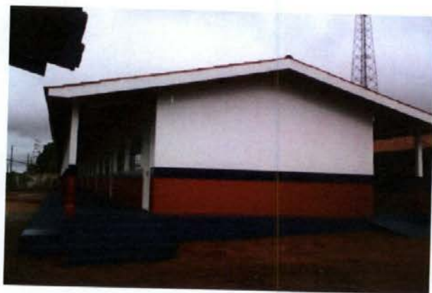
Situação em 11.03.2011 – 1º Bloco – CONCLUÍDO
