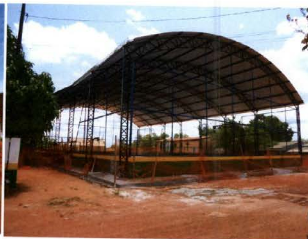
Cobertura Quadra poliesportiva Escola Evangelho – Situação em 29.08.2011
