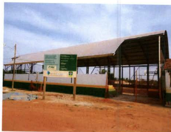
Cobertura Quadra Escola Evangelho – Situação em 18.10.2011
