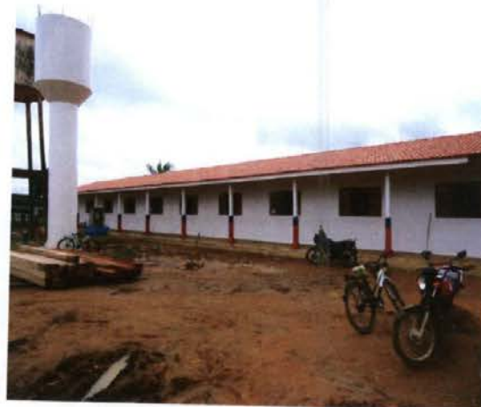
Poço Belo Monte do Pontal – Situação 23. 05.2011
