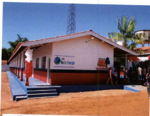
Situação em 25.07.2011- 3º Bloco- CONCLUÍDO
