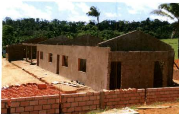
Escola e Creche Dulcinéia - Situação em 29.09.2011
