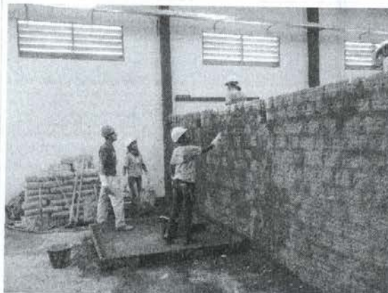
Aula prática de pedreiro – aplicação de chapisco.
