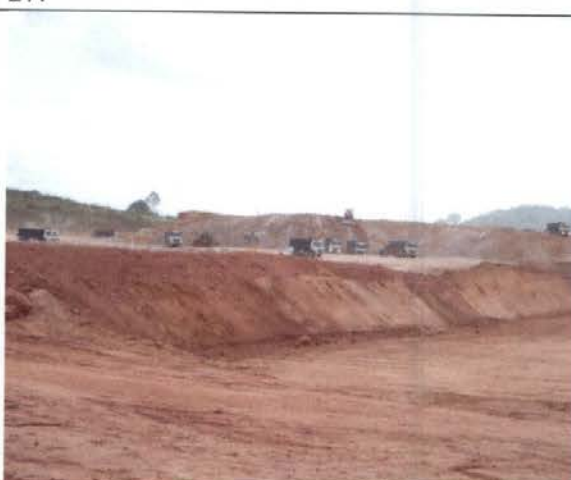
Foto 20. Obras iniciais no canteiro industrial do Sítio Belo Monte.
