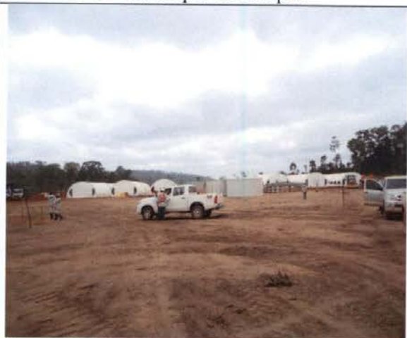
Foto 19. Obras de instalação do acampamento pioneiro no Sítio Pimental.
