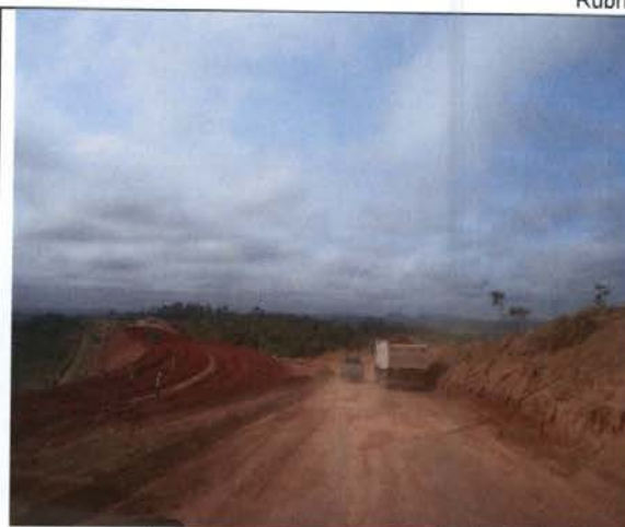
Foto 18. Obras de melhoria do Travessão km 27.
