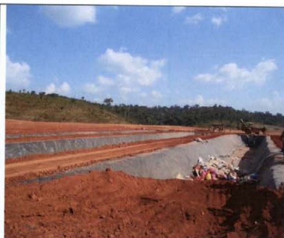
Foto 23. Implantação do aterro sanitário no Sítio Belo Monte.
