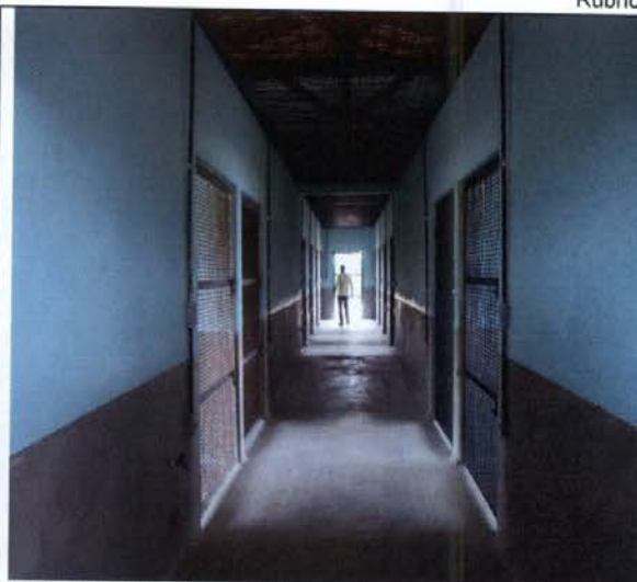
Foto 12. Recintos da base de resgate de fauna.
