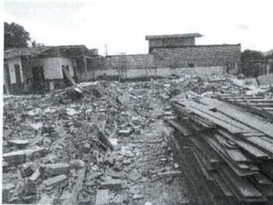
Demolição da antiga UBS, em Altamira.
