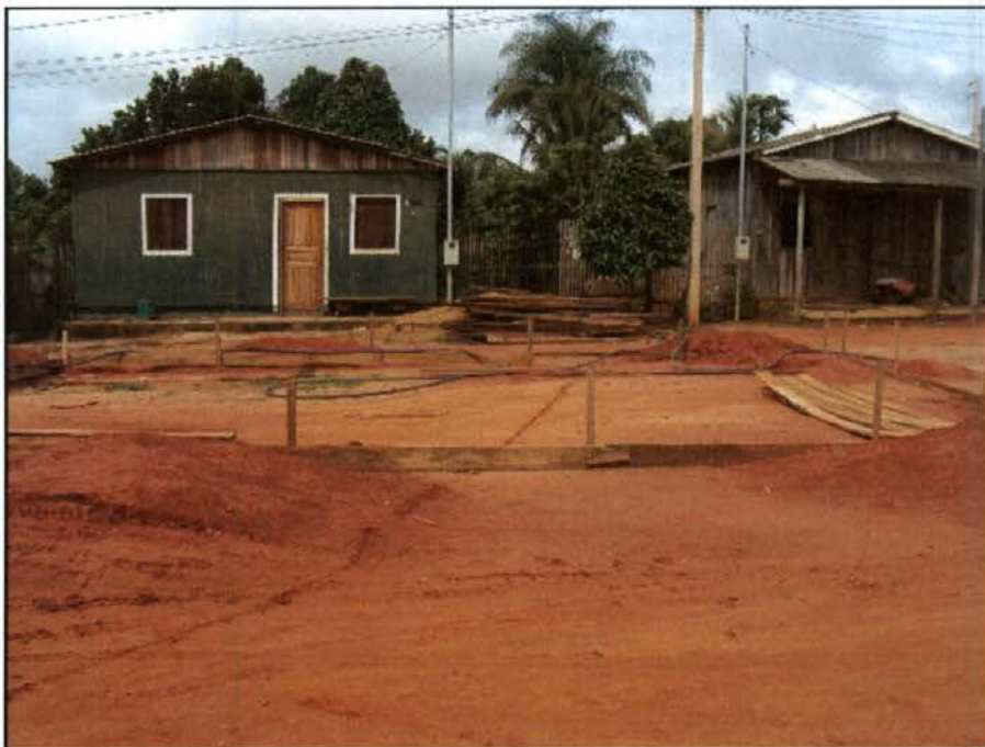
Figura 14 – Vista da delimitação da área de ampliação da escola municipal e proximidade com áreas residenciais.
