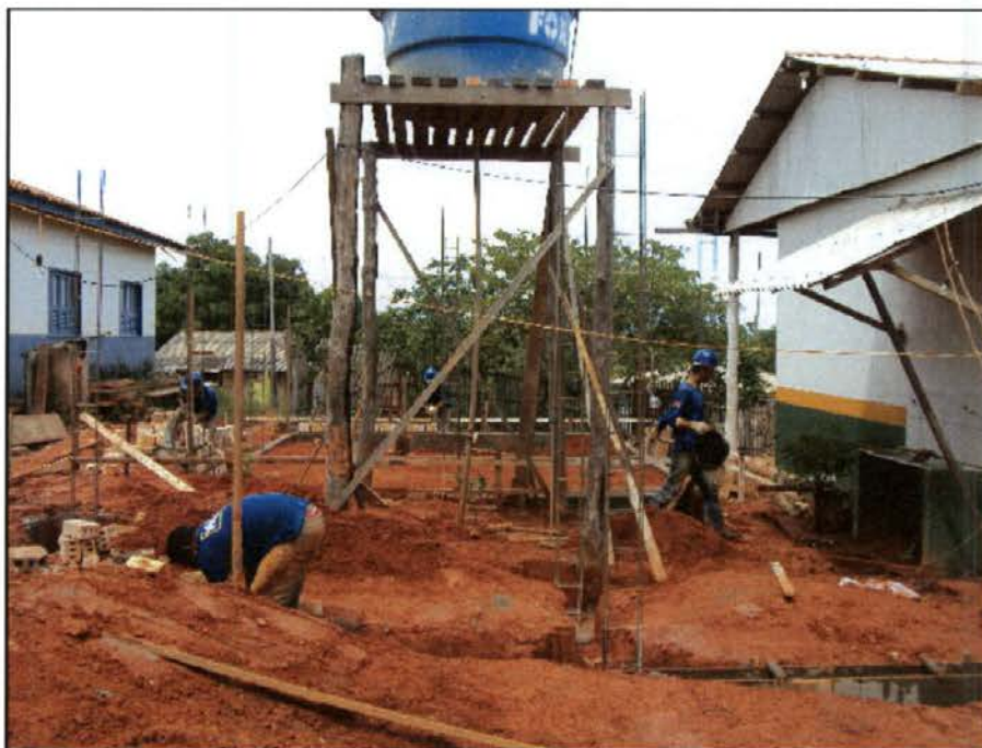
Figura 12 – Vista geral da construção.
