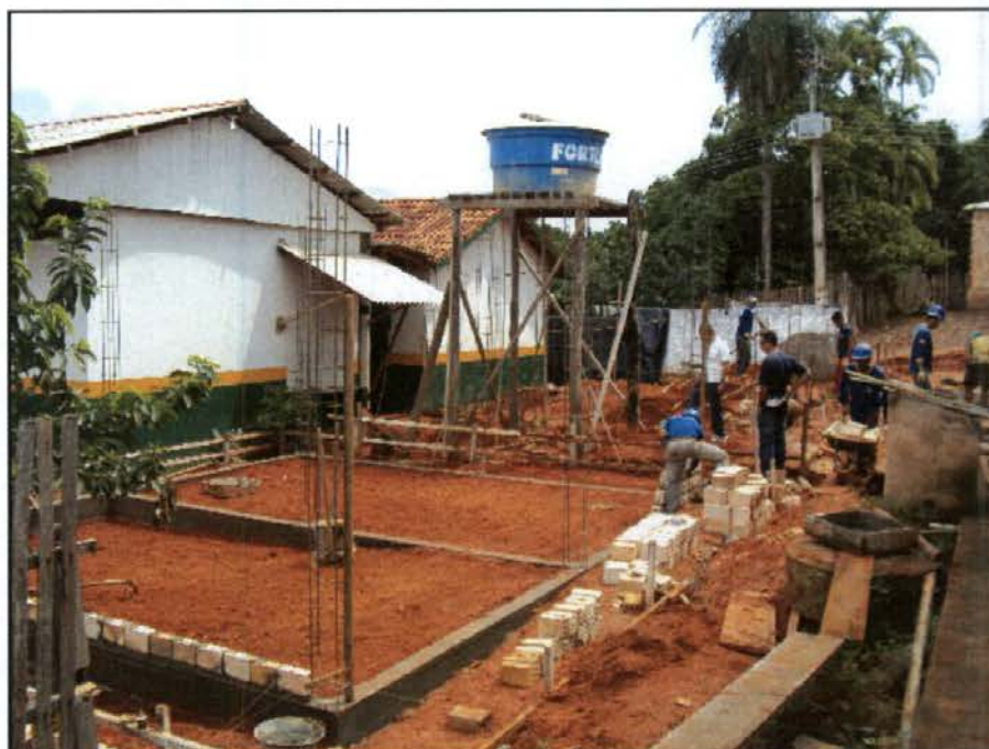
Figura 11 – Parte do alicerce da construção pronto.
