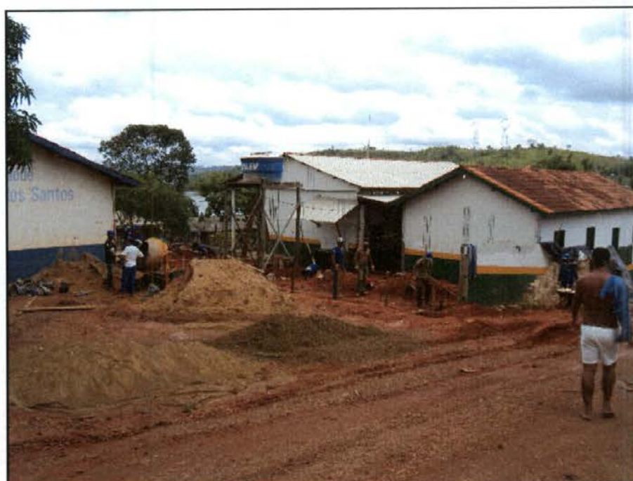
Figura 9 – Vista geral da escola e das obras de ampliação em execução.
