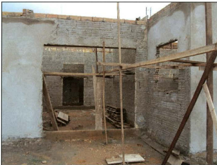
Figura 8 – Vista da construção na parte interna do posto de saúde.
