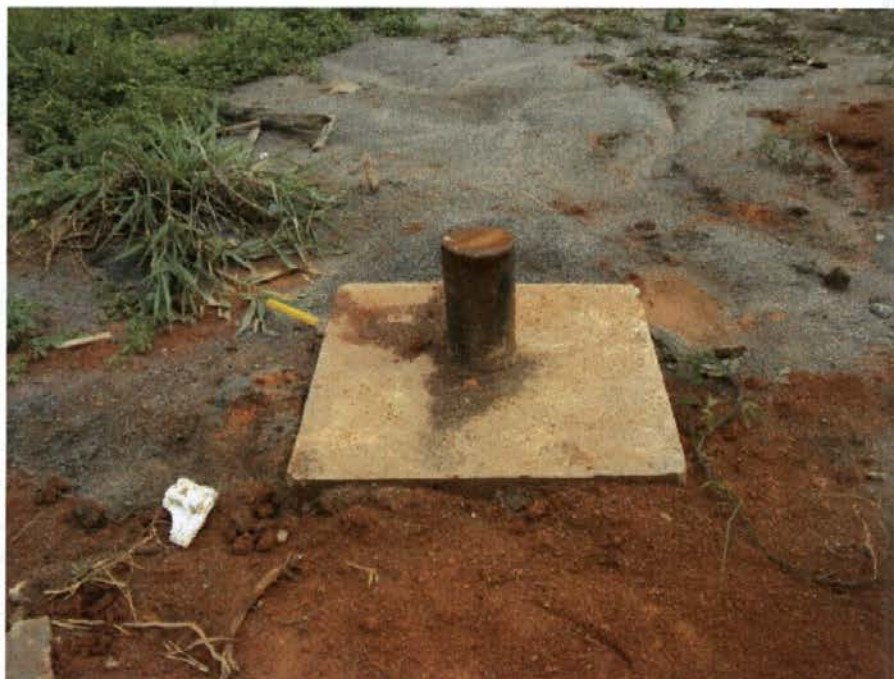
Figura 18 – Poço tubular profundo cimentado e concluído.
