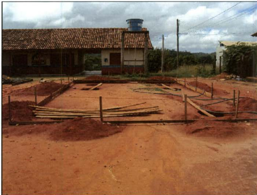
Figura 13 – Início das obras de ampliação da escola municipal, vista ao fundo da foto.
