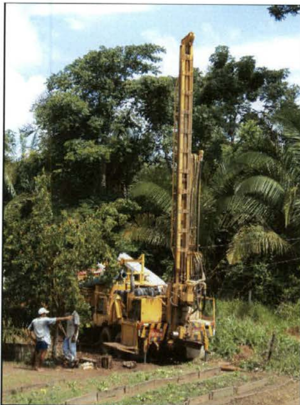
Figura 20 – Preparação da sonda perfuradora no local destinado à construção do Poço 2.
