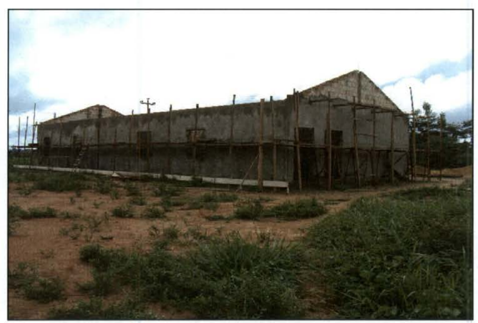
Figura 6 – Vista Lateral da construção.
