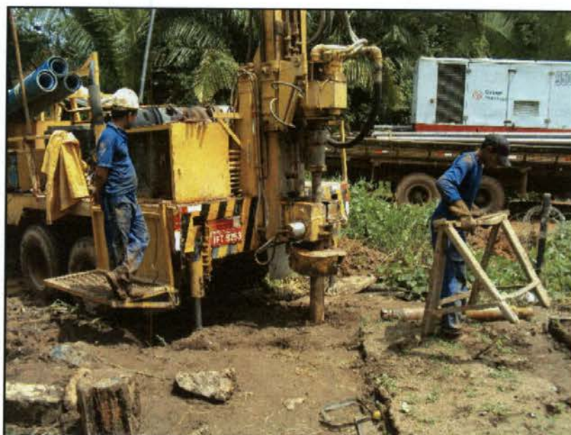
Figura 21 – Execução da perfuração de construção do Poço 2.
