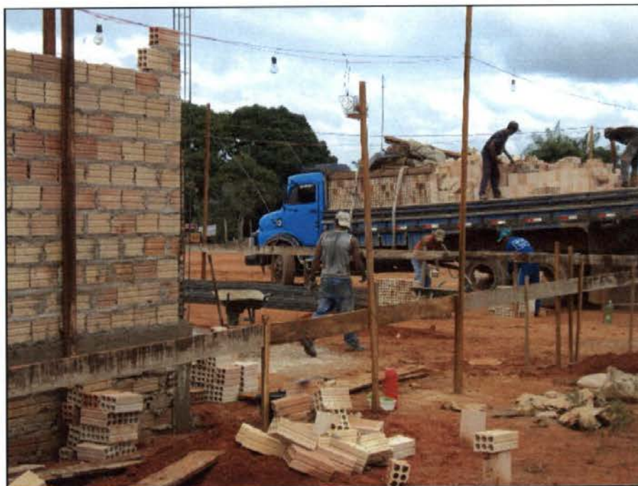
Figura 2 – Descarregamento do material de construção.
