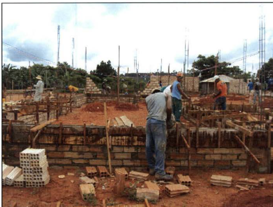
Figura 4 – Trabalhadores atuantes na construção do posto de saúde.
