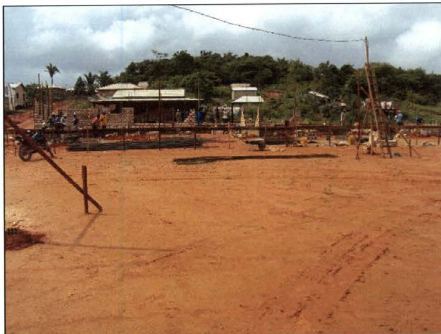
Figura 1 - Vista Geral da área destinada à construção do Posto de Saúde da localidade de Belo Monte.
