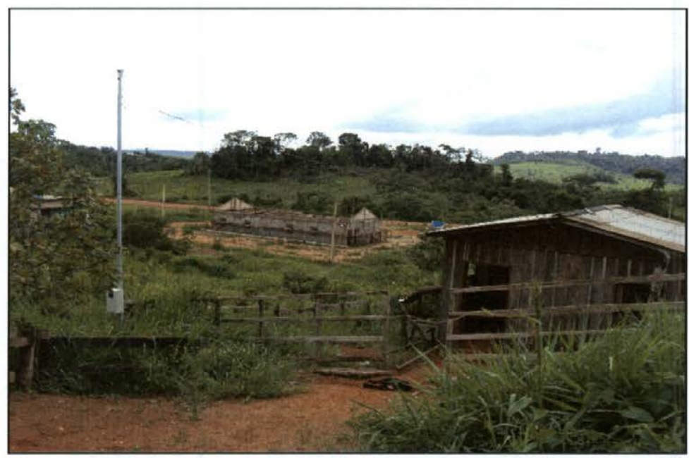
Figura 5 – Vista geral do local de construção do posto de saúde em Belo Monte do Pontal.
