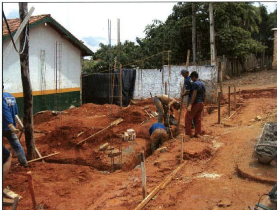
Figura 10 – Vista dos trabalhadores realizando a construção do alicerce da construção.
