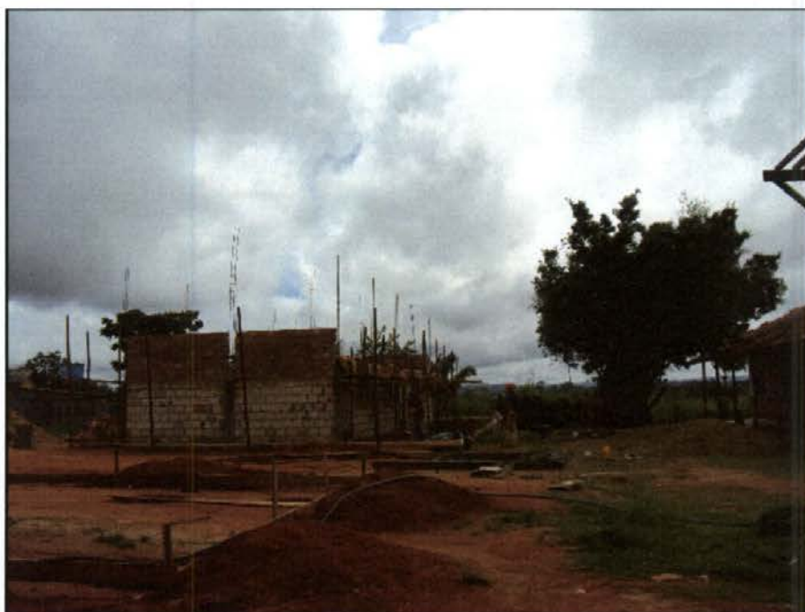
Figura 16 – Vista geral das obras de ampliação da escola municipal, já nas etapas finais de construção. A escola encontra-se na parte esquerda da foto.
