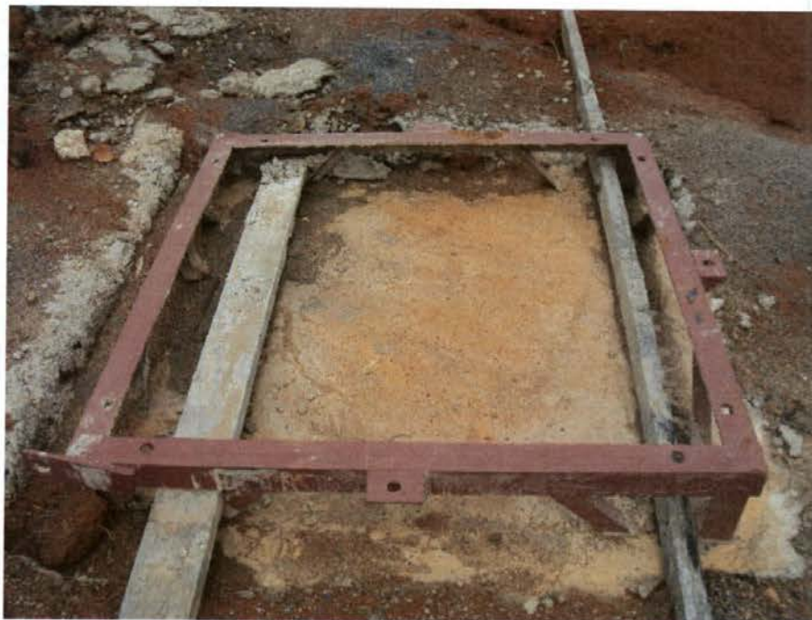
Figura 17 – Projeção da área no entorno do poço para cimentação.
