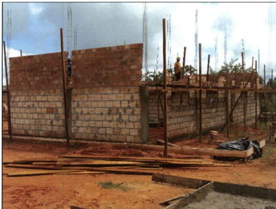
Figura 15 – Vista lateral das obras de ampliação da escola municipal.
