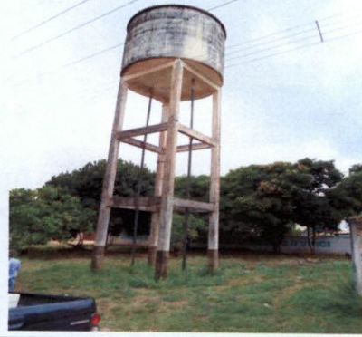
Foto 8 – Caixa d'água que será utilizada como reservatório na Agrovila Leonardo da Vinci.
