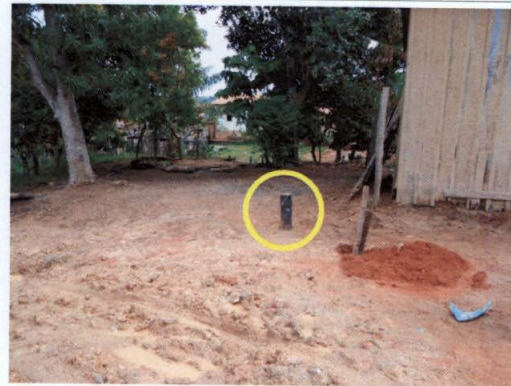
Foto 12 – No detalhe, poço perfurado em Belo Monte do Pontal (12 m³/h).
