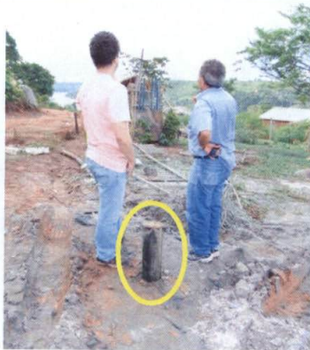
Foto 13 – No detalhe, poço perfurado em Belo Monte (3 m³/h).
