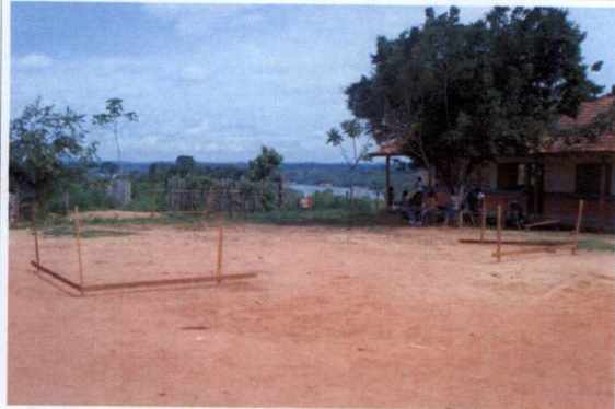
Foto 10 – Gabarito de esquadramento das obras da sala de aula
