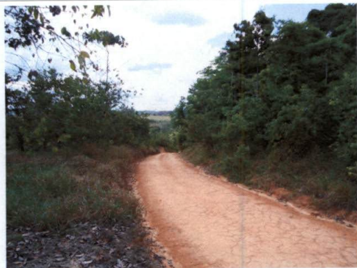
Foto 15 – Trecho da estrada a ser melhorada – Travessão km 27.
