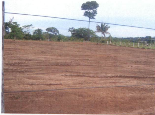
Foto 25 – Local destinado à instalação da base de resgate de fauna, em terreno adjacente ao acampamento da Eletronorte, em ramal do Travesão km 27.
