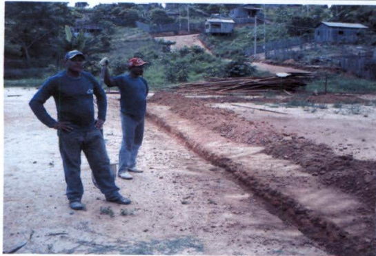
Foto 9 – Funcionários de empreiteira preparando o terreno da futura Unidade Básica de Saúde, em Belo Monte do Pontal.
