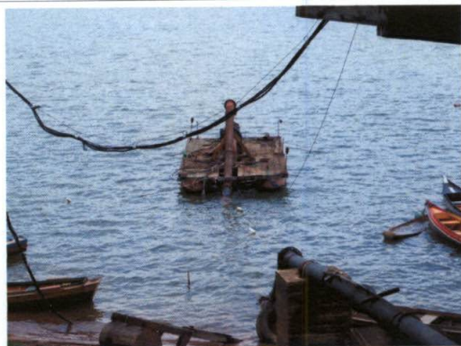
Foto 3 – Plataforma flutuante de captação de água para abastecimento do município de Altamira.
