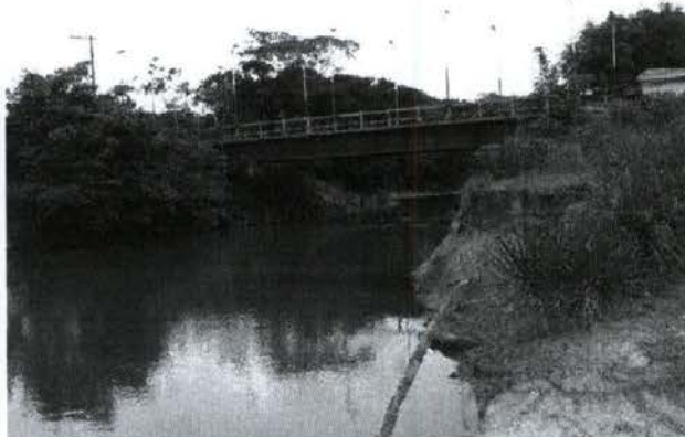
Figura 24. Ponte sobre o Igarapé Ambé, a ser afetada pelo empreendimento – município de Altamira.
