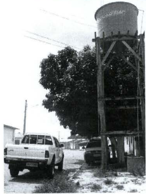
Figura 22. Sistema de captação de água em Vitória do Xingu do tipo poço e caixa d'água.
