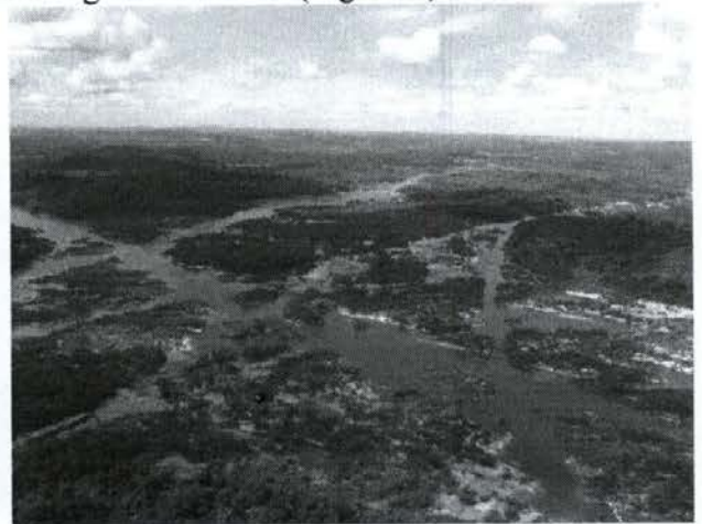
Figura 9. Canais anastomosados no trecho a ser submetido a vazão reduzida.
