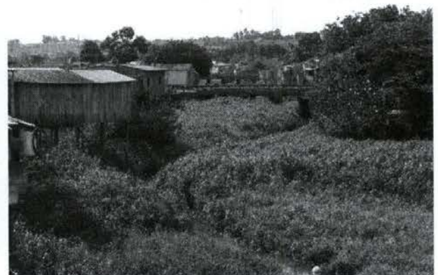
Figura 27. Estrangulamento do escoamento superficial no Igarapé Altamira – município de Altamira.
