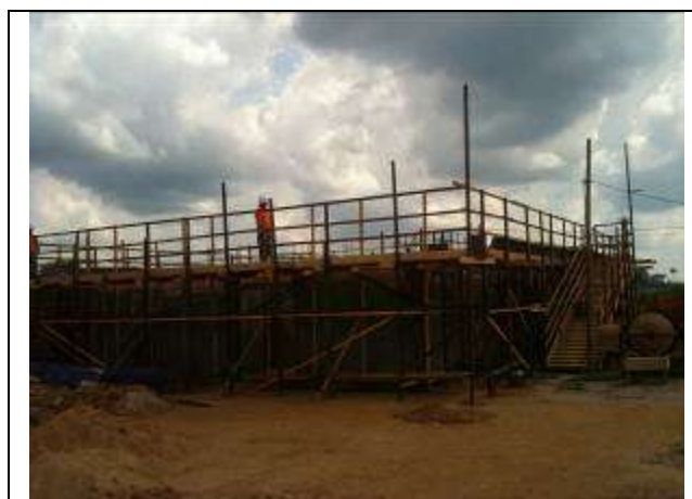
Foto 20 Execução das obras da UBS no Bairro Liberdade, na sede do município de Altamira
