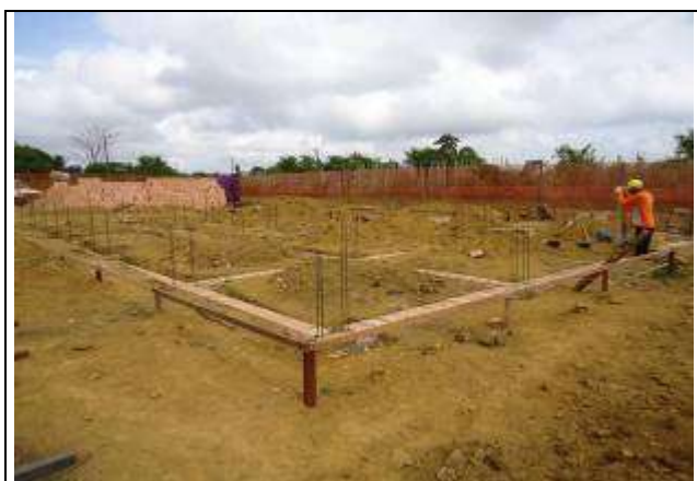
Foto 19 Início das obras na UBS no Bairro Liberdade, na sede do município de Altamira
