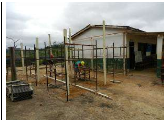
Foto 13 Início das obras na EMEF Sol Nascente, na zona rural do município de Altamira
