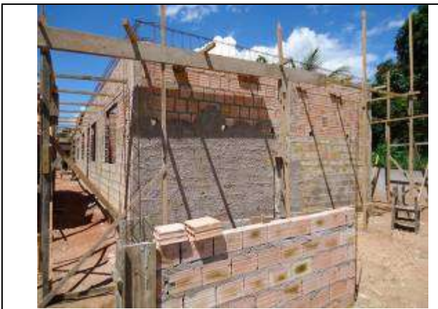
Foto 29 Execução das obras na Escola N.Sª Aparecida III, na zona rural do município de Vitória do Xingu
