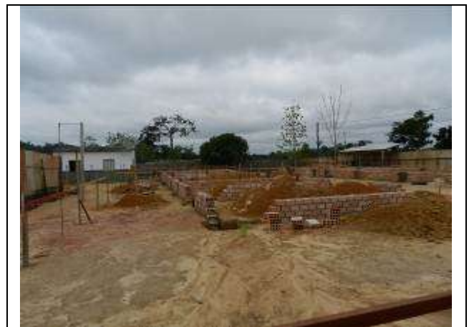
Foto 14 Execução das obras na EMEF Sol Nascente, na zona rural do município de Altamira
