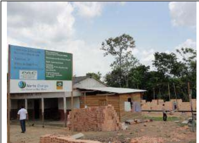
Foto 27 Obras na EMEF Vila Rica, na zona rural do município de Vitória do Xingu
