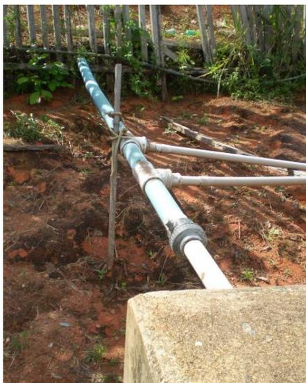
**Figura 3.5 – Chegada da Adutora no reservatório de 22m<sup>3</sup>**
