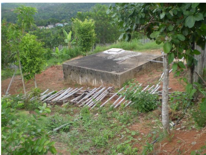
**Figura 3.4 – Reservatório de 22 m<sup>3</sup>.**
