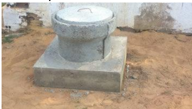
Figura 11.3.1 - 2 – Exemplo de proteção externa dos poços instalados, composta por manilha e tampa de concreto.
