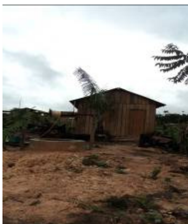
Foto 21 – Captação de água por poço tipo cisterna
