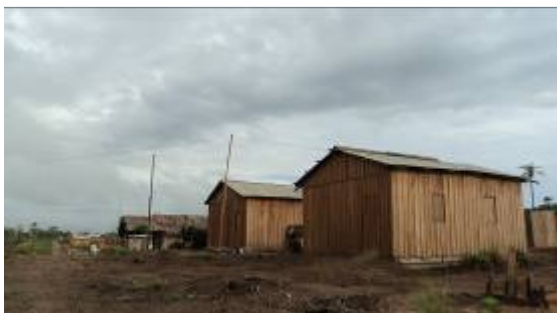
Foto 6 – Casa de madeira e telha de amianto
