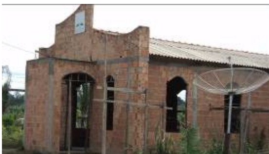
Foto 16 – Igreja Adventista em construção
