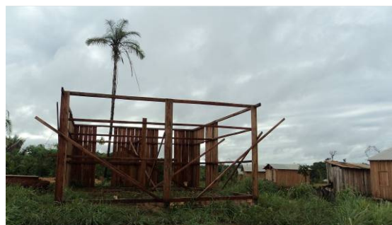
Foto 4 – Casa em construção
