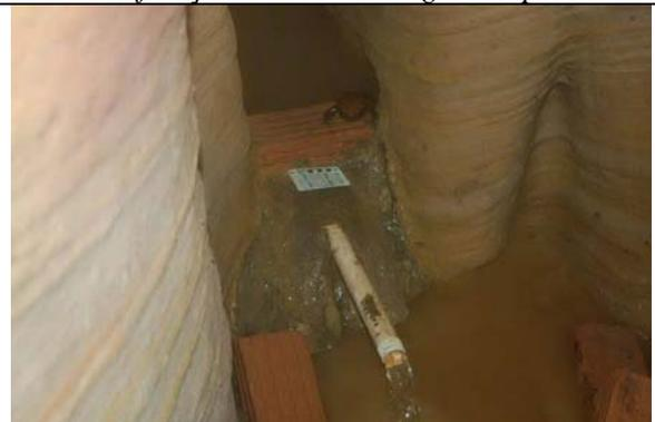
*Foto 1.10 – Detalhe de estrutura construída para represar a água no final da caverna.*
