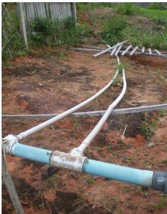
**Foto 11.20 – Instalação da adutora e de derivações.**
