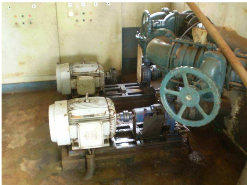
**Foto 6.15 – Sistema de bombeamento da estação elevatória**
