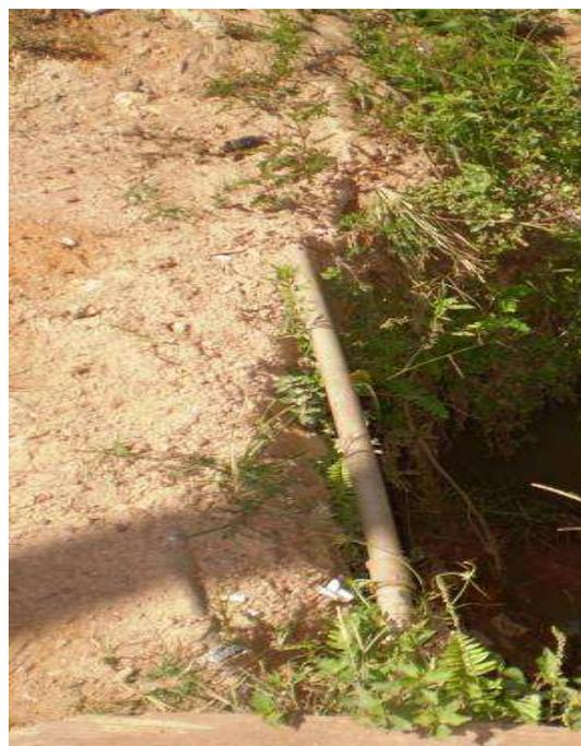
**Foto 9.16 – Detalhe da Rede de abastecimento de água aparente**
