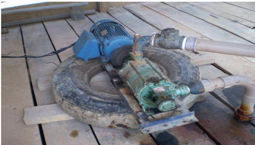
**Foto 11.14 – Sistema de bombeamento do poço raso.**
