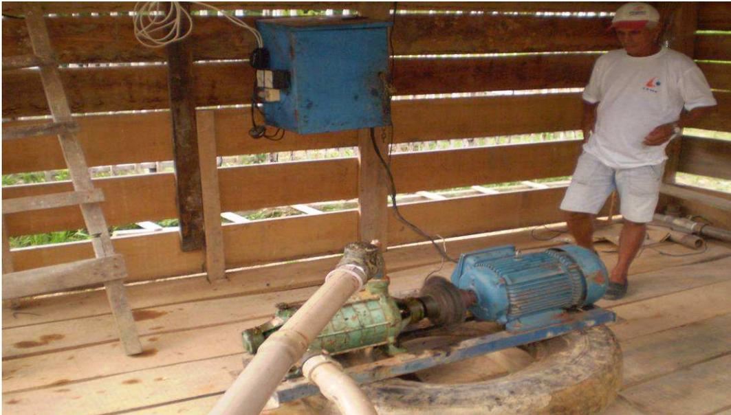
**Foto 11.18 – Sistema de bombeamento do poço.**
