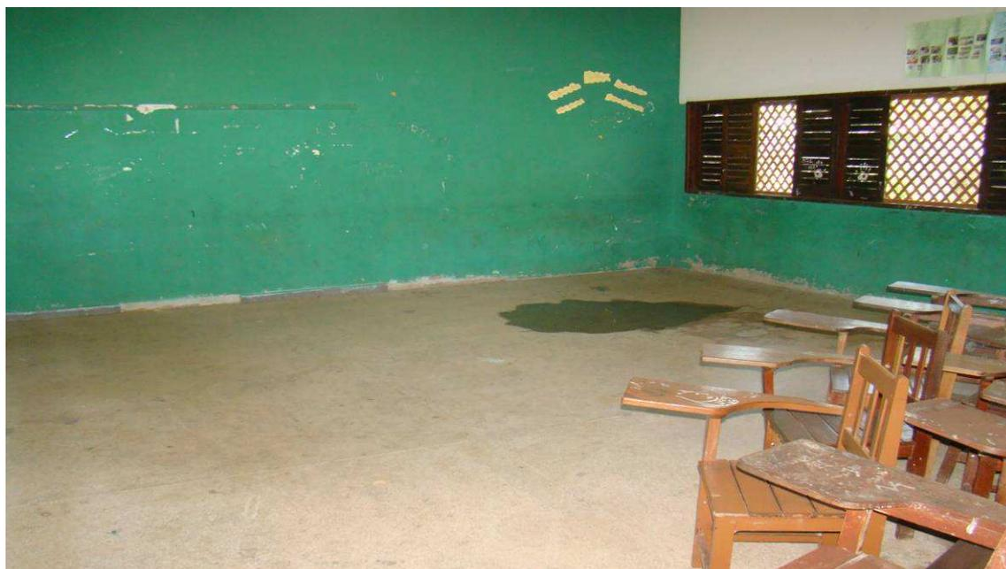
**Foto 4.4 – foto interna da EMEF Dairce Pedrosa Torres. Infiltrações no telhado, caixilhos, pisos e parede em condições precárias e mobiliário depredado.**
