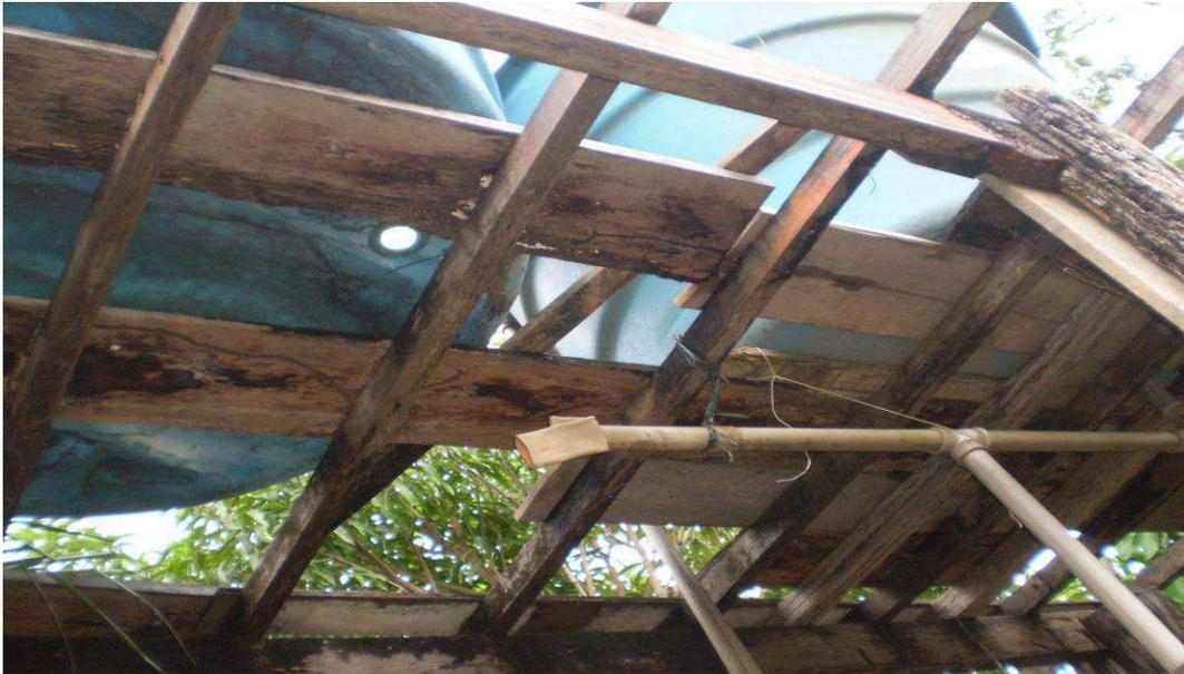
**Foto 11.22 – Detalhe dos reservatórios de 3 m³.**
