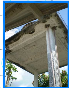
RESERVATÓRIO ELEVADO 1m 3
