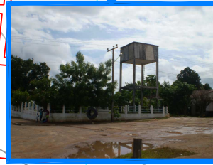
RESERVATÓRIO ELEVADO 36m 3 E POÇO RASO
