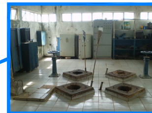
DETALHE DA CAPTAÇÃO ANTIGA INOPERANTE
