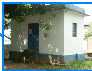
VISTA DA CASA DE FORÇA
