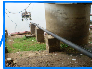
VISTA DA CAPTAÇÃO FLUTUANTE
