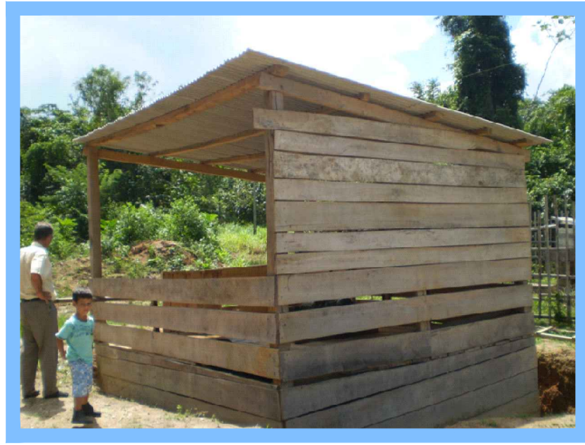
POÇO RASO PROFUNDIDADE 5,0m
