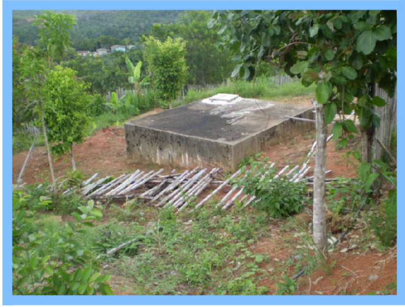
RESERVATÓRIO 1 - APOIADO 22m 3
