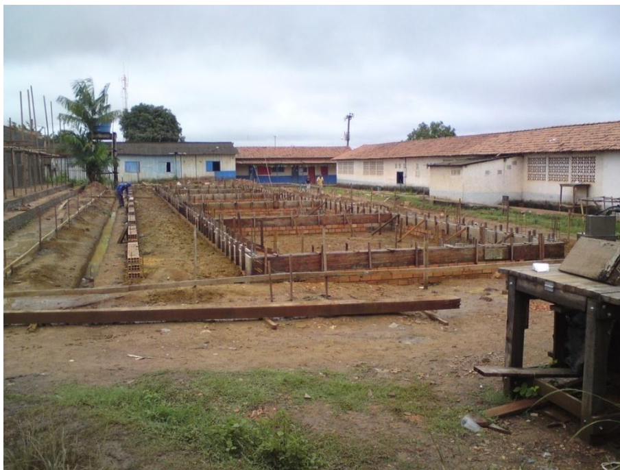
Foto 4 - Sede 3º Bloco com 05 salas de aulas de 20 - Data acordada com Prefeitura para término 30-12-2011
