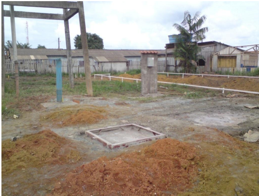
Foto 1 - Sede Ë Poço semi-artesiano para atender as 20 salas de aulas Ë Data acordada com Prefeitura para término Ë 30-06-2011
