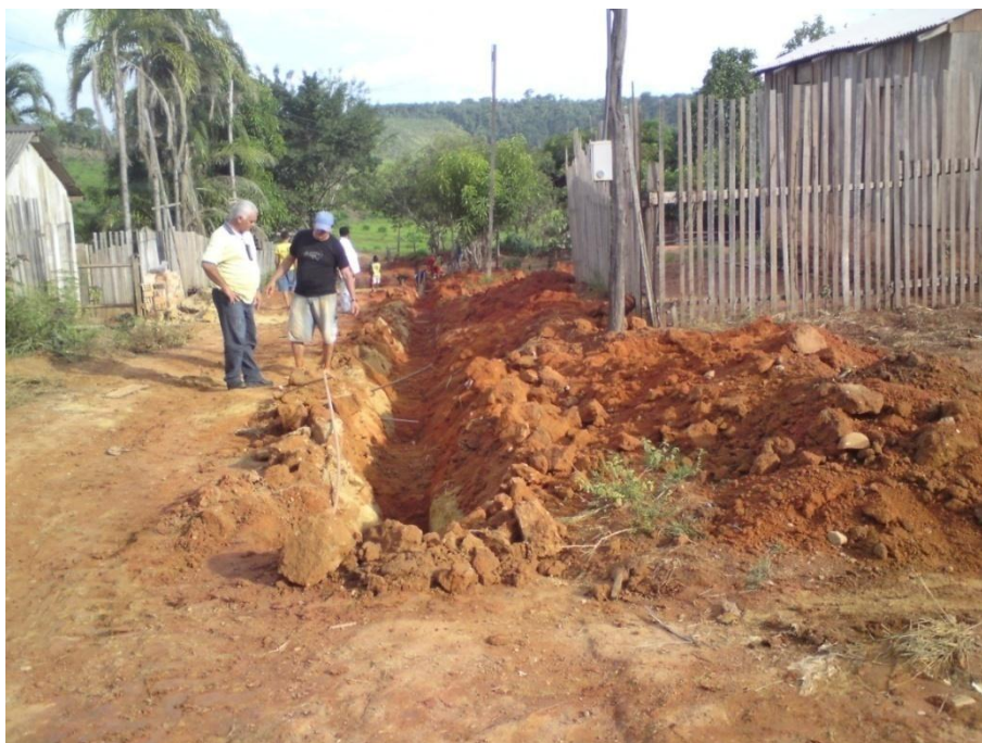
Foto 19 - Belo Monte É Implantação da rede de água É Data acordada com Prefeitura para término 30-06-2011
