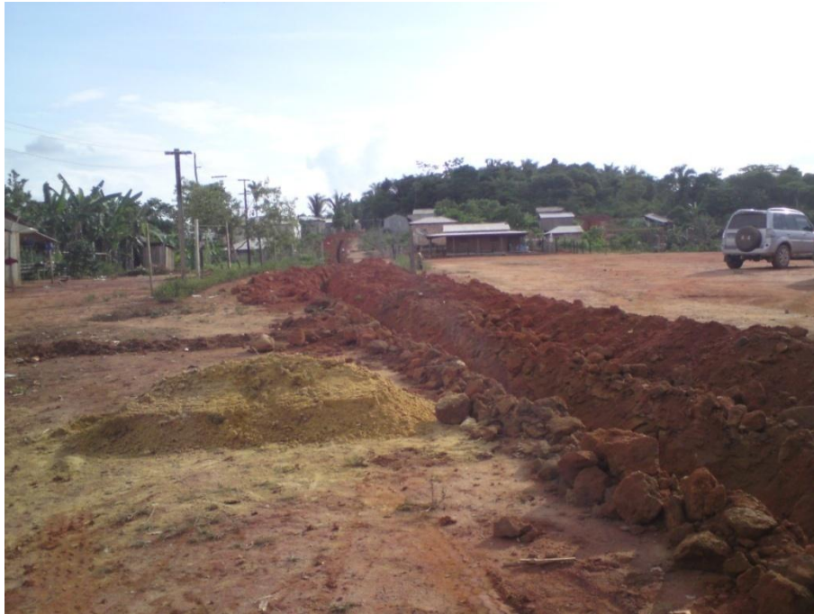
Foto 18 - Belo Monte É Implantação da rede de água É Data acordada com Prefeitura para término 30-06-2011
