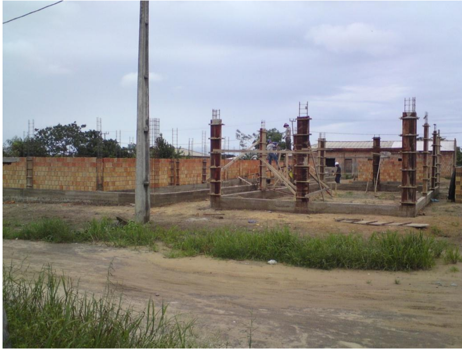
Foto 10 - Sede ã Escola com 04 salas de aulas ã Data acordada com Prefeitura para tãrmino 31-07-2011
