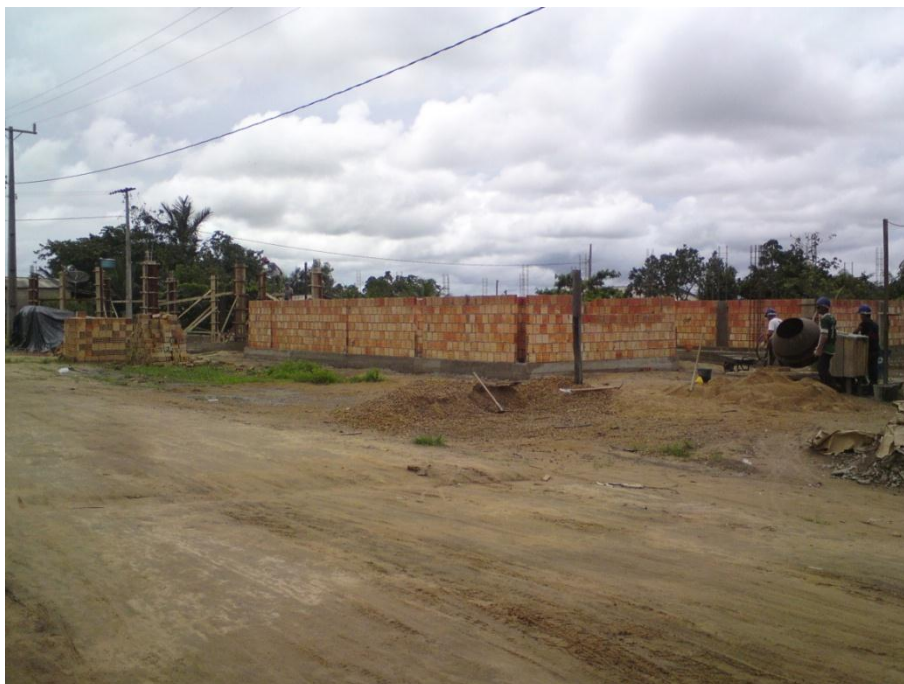
Foto 11 - Sede ã Escola com 04 salas de aulas ã Data acordada com Prefeitura para tãrmino 31-07-2011
