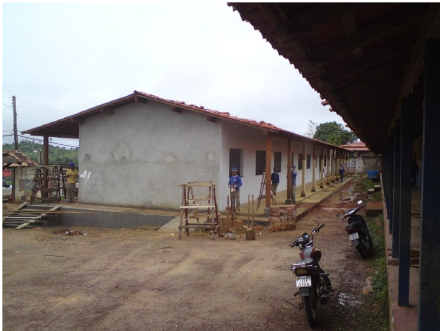
Foto 2 - Sede Ë 1º Bloco com 05 salas de aulas de 20 - Data acordada com Prefeitura para término Ë 30-06-2011- Em fase de conclusão/entrega para início das aulas
