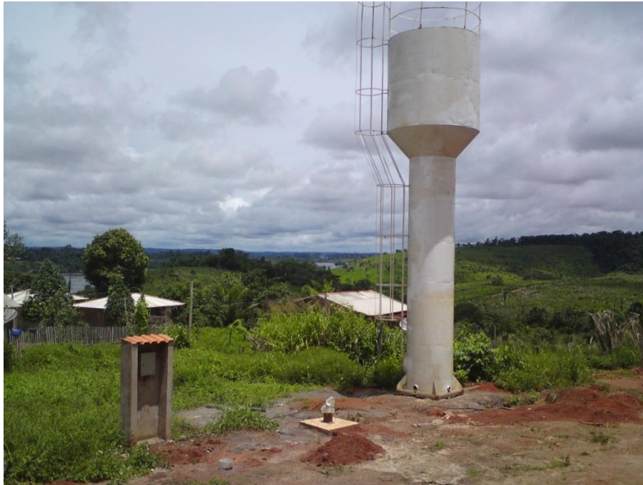
Foto 16 - Belo Monte É 1º Poço semi-artesiano É Construção - Data acordada com Prefeitura para término 30-06-2011
