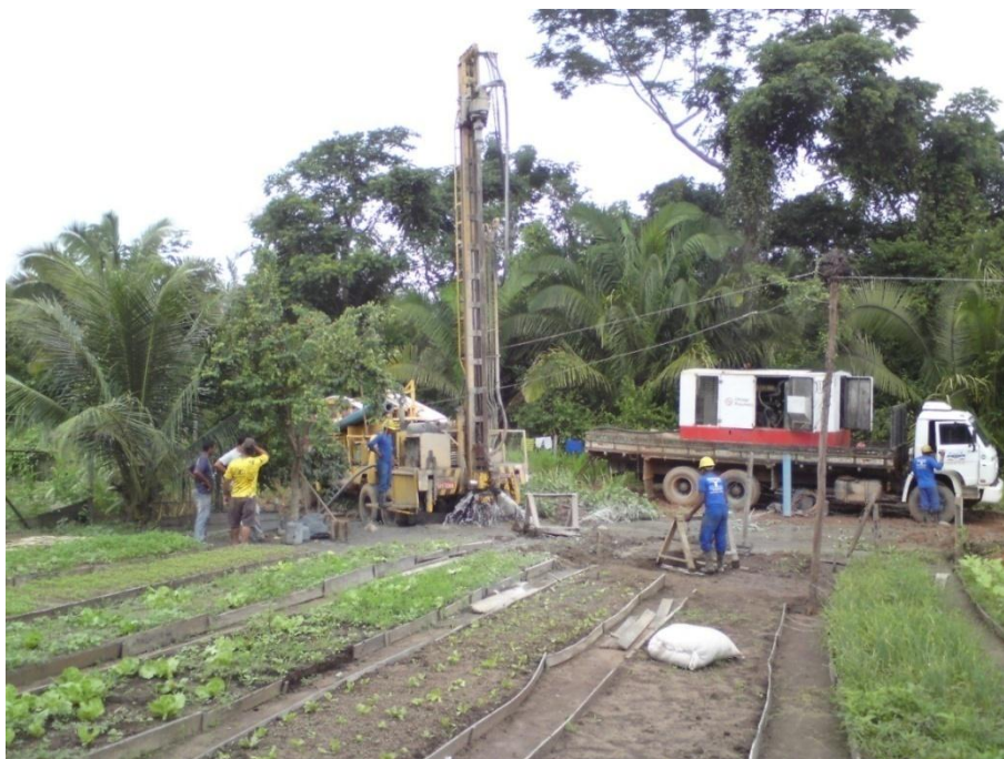
Foto 17 - Belo Monte É 2º Poço semi-artesiano É Construção - Data acordada com Prefeitura para término 30-06-2011
