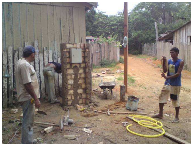
Belo Monte do Pontal – Poço Semi-artesiano (já com o ponto e quadro de energia para ligar bomba d'água)
