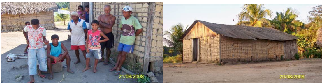
(C) Casas de adobe com madeira e telhado zinco.
