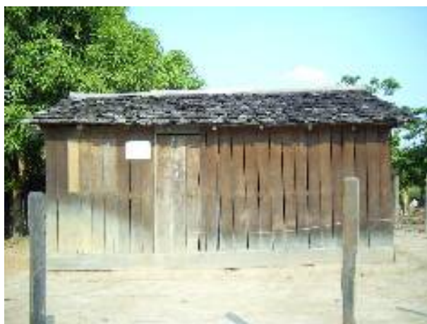
Foto 2.1 – Comunidade de Santo Antônio – Padrão Construtivo
