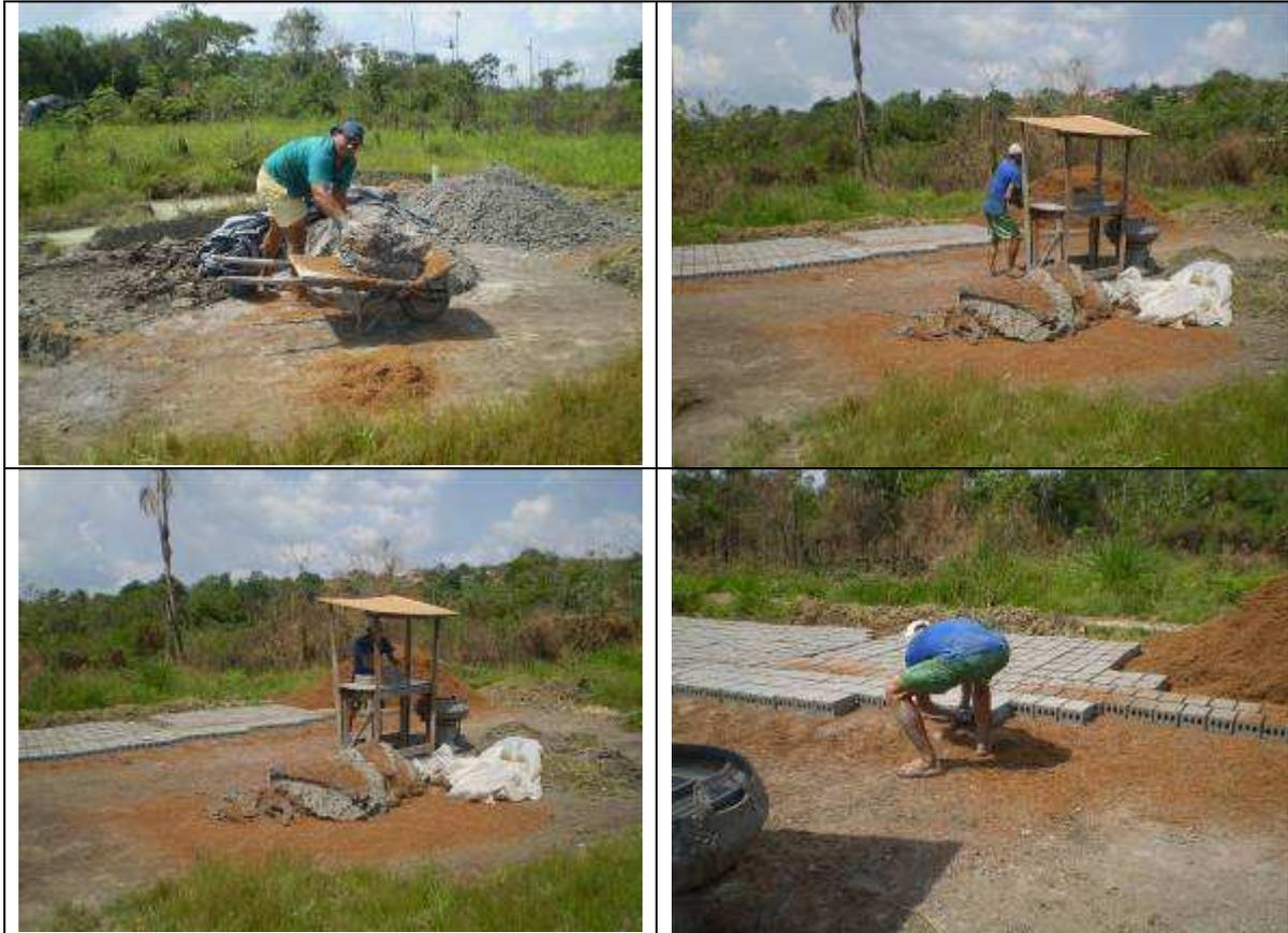
**Fotoimagem 2.** Seqüência do processo de moldagem manual dos tijolos.
