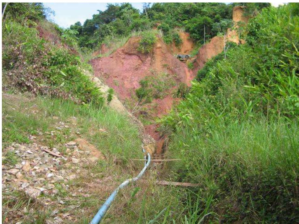
**FIGURA 7.7.4-55** – Garimpo de ouro Gauchão – Vista do barranco de colúvio/elúvio e instalação de tubulação para desmonte hidráulico.
