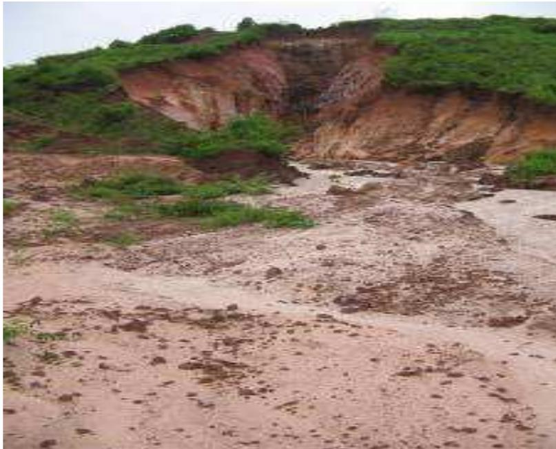
**FIGURA 7.7.4-23** – Erosão de grandes dimensões instalada em arenitos da Formação Maecuru, nas proximidades do Km 46,0. O material erodido forma um grande leque de deposição que está ocupando o leito da rodovia Transamazônica.
