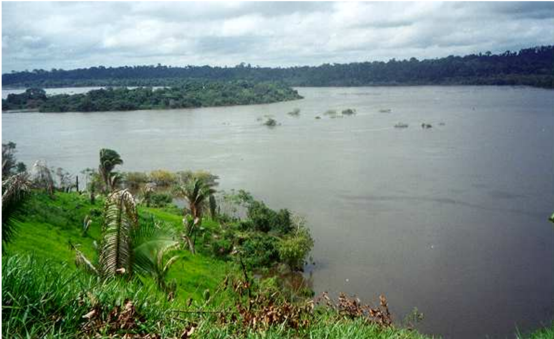
FIGURA 4.2.4-13 – Visão panorâmica do local onde está projetada a implantação do Vertedouro Complementar
