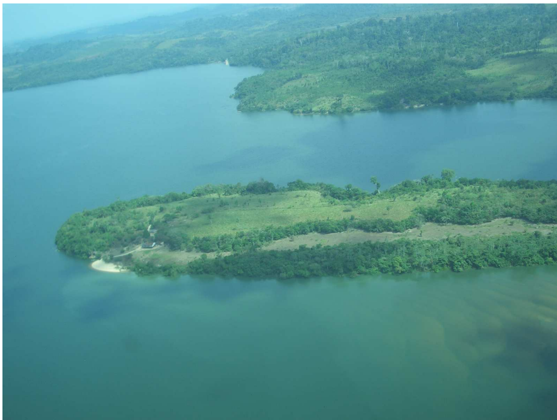
FIGURA 4.2.4-11 – Vista aérea de parte do Trecho de Restituição de Vazões nas proximidades do terminal portuário da Petrobrás.
