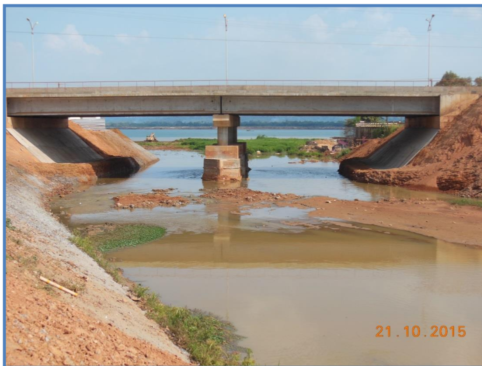
Figura 03 – Ponte Cel. José Porfírio (Vista da Foz do Igarapé Altamira)
