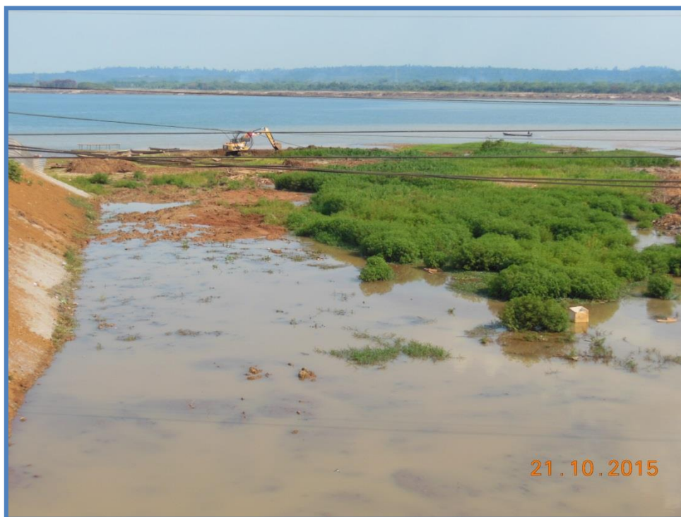
Figura 05 – Retirada do Material da foz da Calha do Igarapé Altamira
