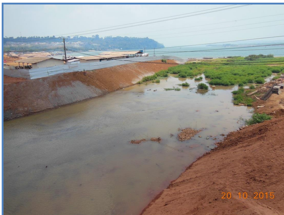
Figura 05 – Retirada do Material da foz da Calha do Igarapé Altamira
