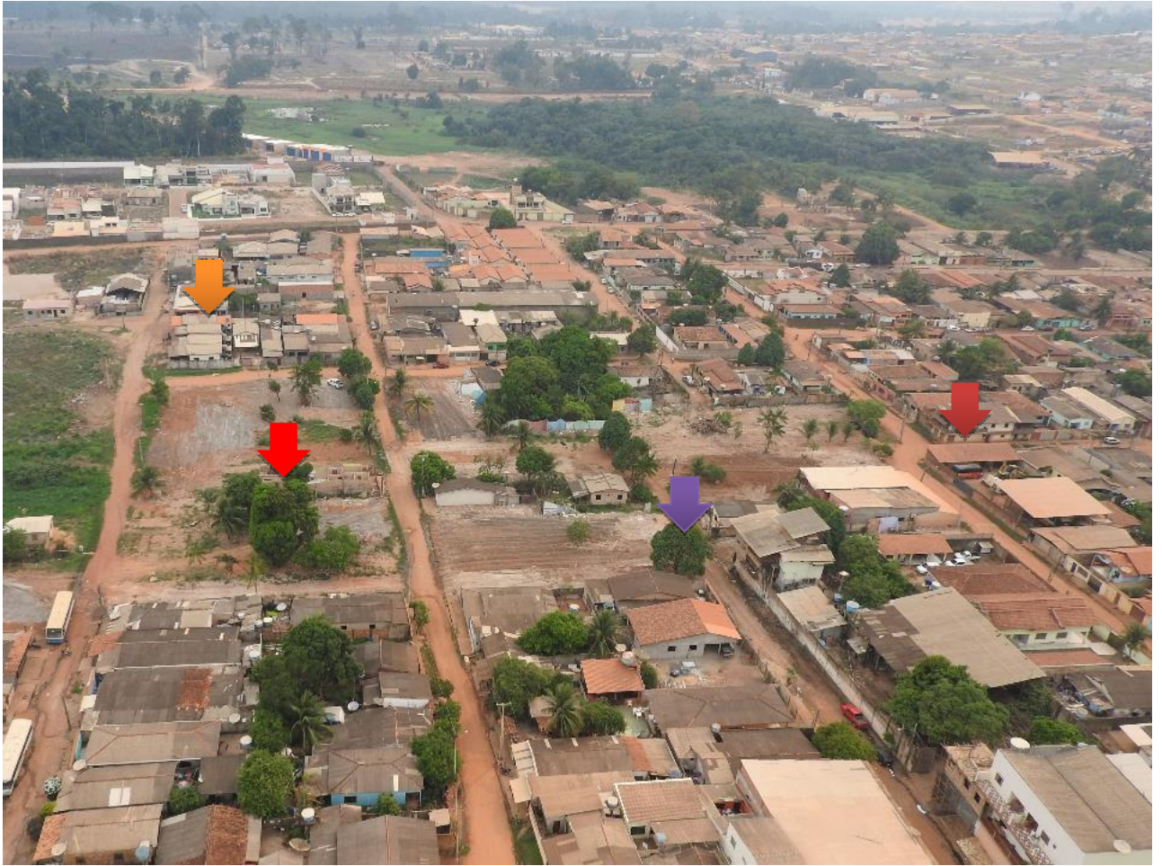
Figura 2-4 – Igarapé Panelas - out/2015
