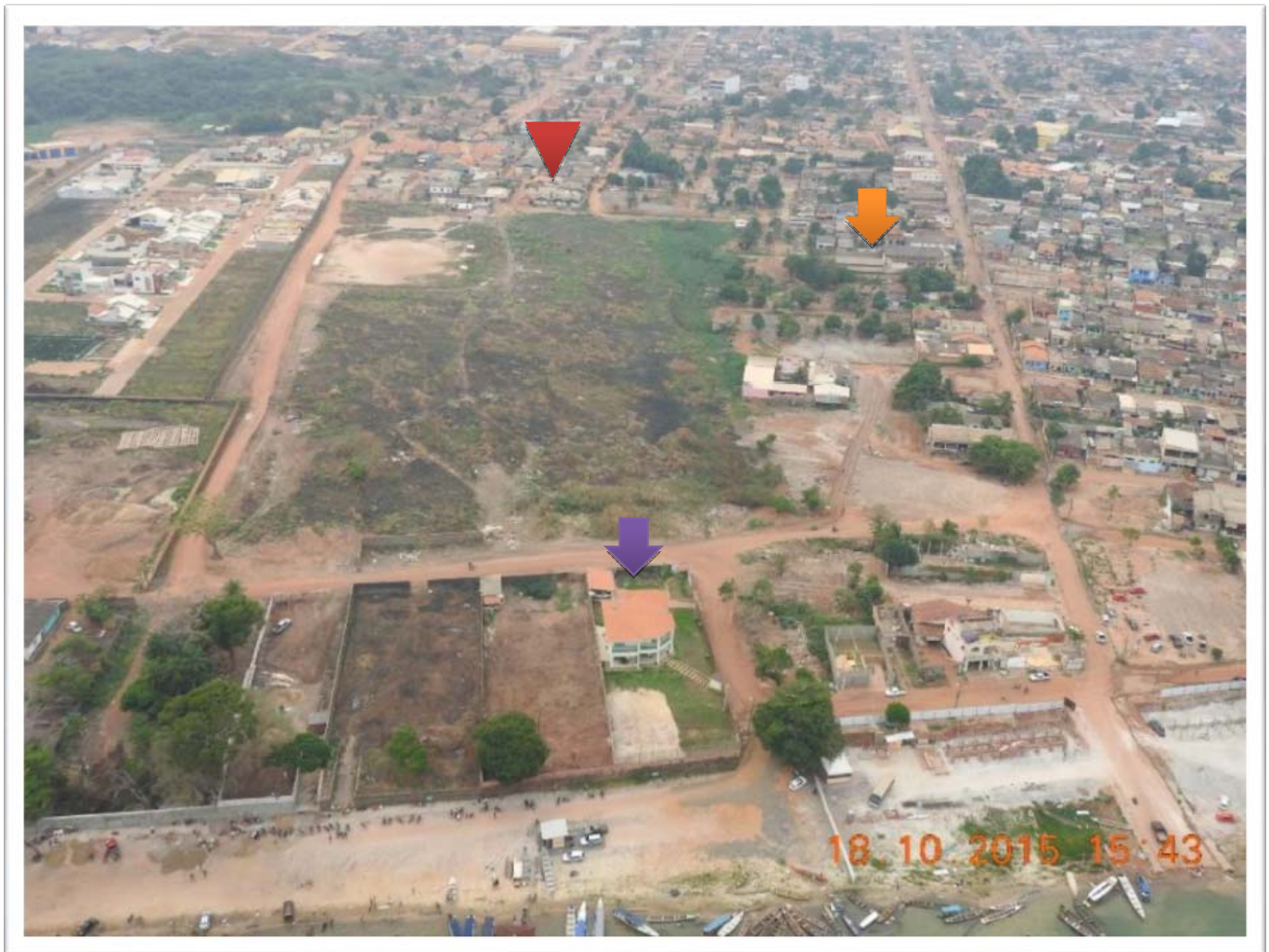
Figura 2-2 – Igarapé Panelas out/2015
