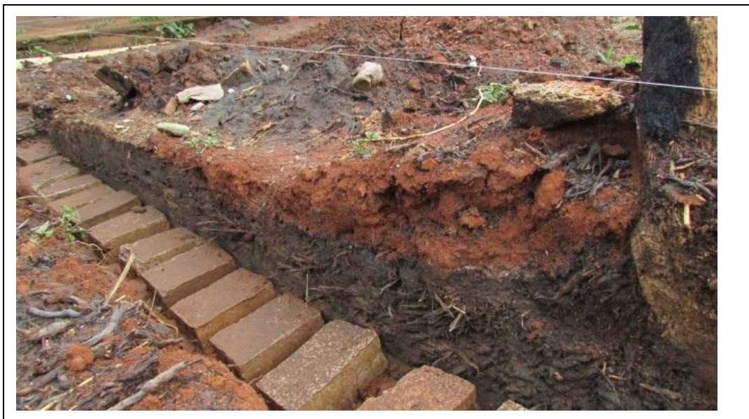
Figura 03 – Perfil típico da pedologia local. Presença de camada superficial de aterro argiloso.
