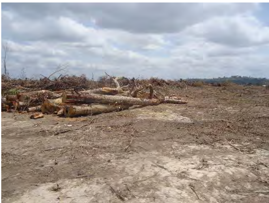
Figura 12 - Procedimento de segregação de material lenhoso a partir de leiras - RX Ilha Paratizinho.
