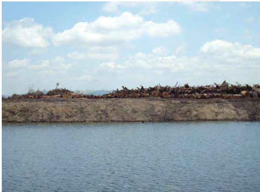
Figura 5: Material lenhoso preparado para transporte (embarque) - RX Ilha Meio 2
