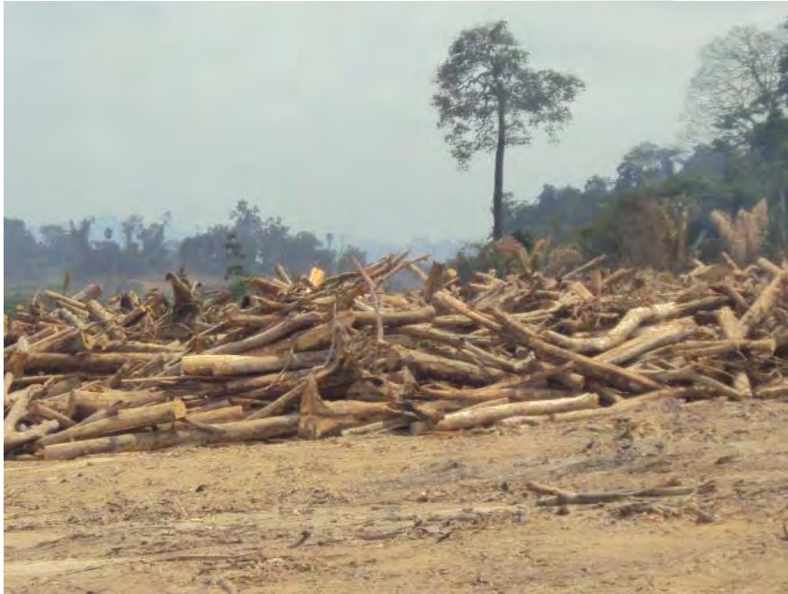
Figura 7: Formação de pátio de estocagem de resíduo grosso - RX margem direita.
