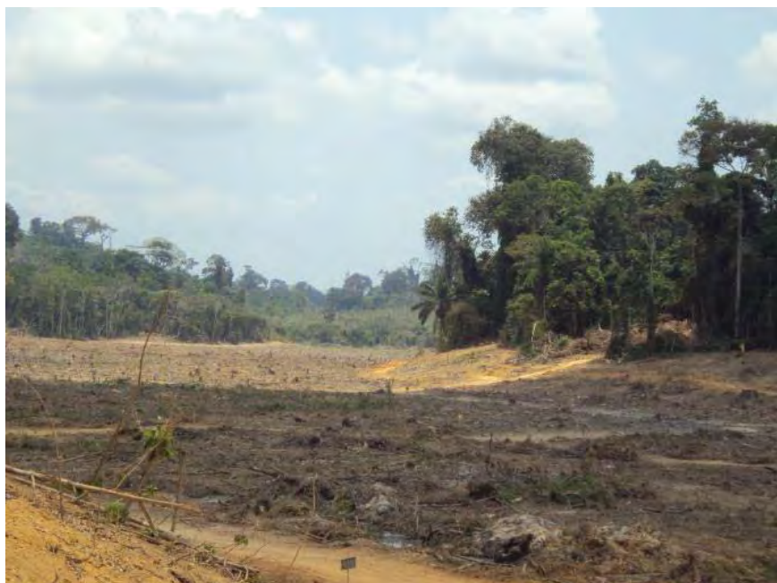
Figura 10: Área de várzea com limpeza finalizada - RX margem direita.
