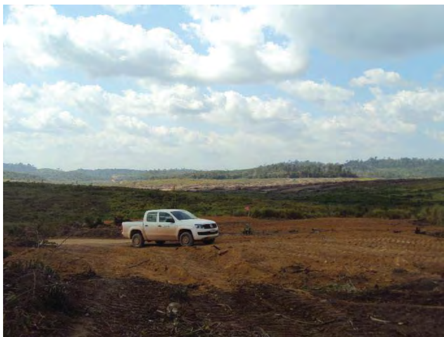
Figura 20: Área de supressão finalizada com resíduos finos transportados - RI Lote D
