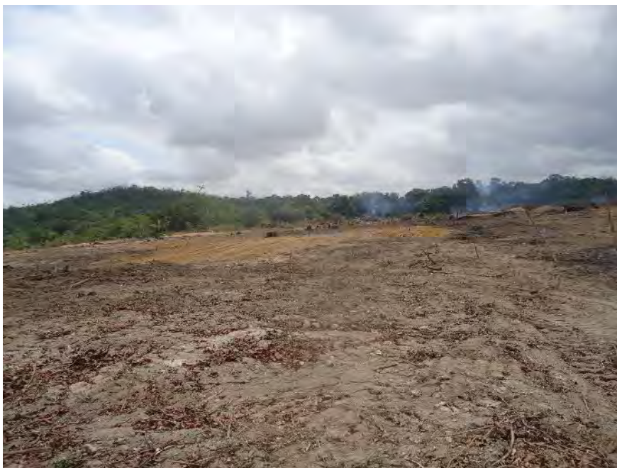
Figura 14: Vista final de área de queima/enterrio cinzas - RX Ilha do Jô.
