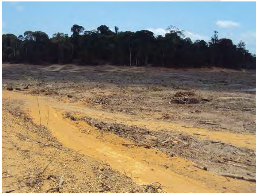
Figura 9: Área finalizada e com resíduos finos transportados - RX margem direita.
