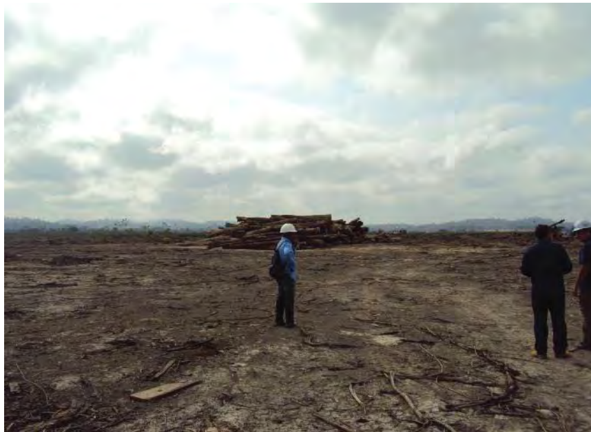
Figura 1: Área com limpeza finalizada em ilha, aguardando transporte final de material lenhoso – RX montante.
