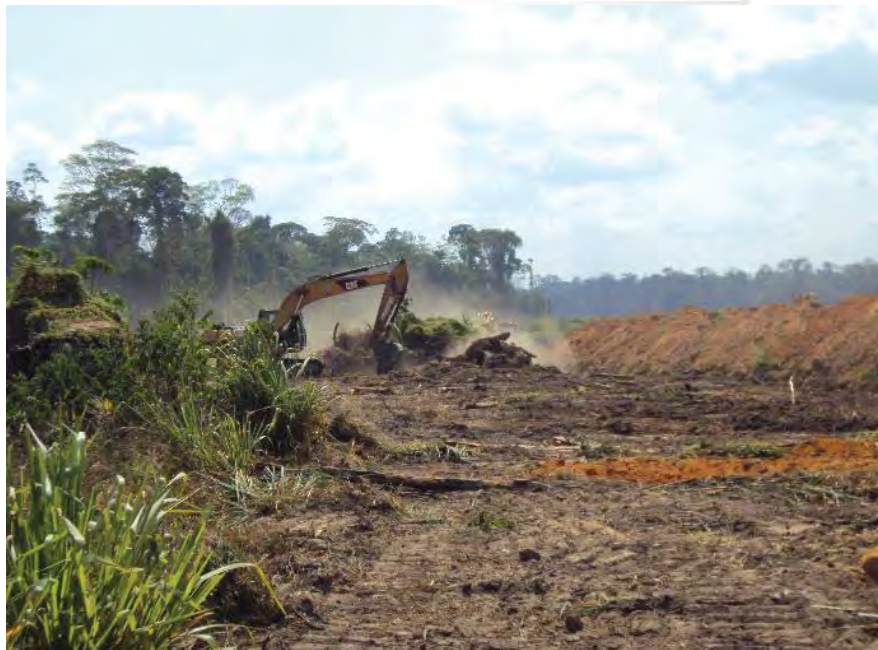
Figura 19: Detalhe de enterrio de resíduo fino cru - RI Lote G
