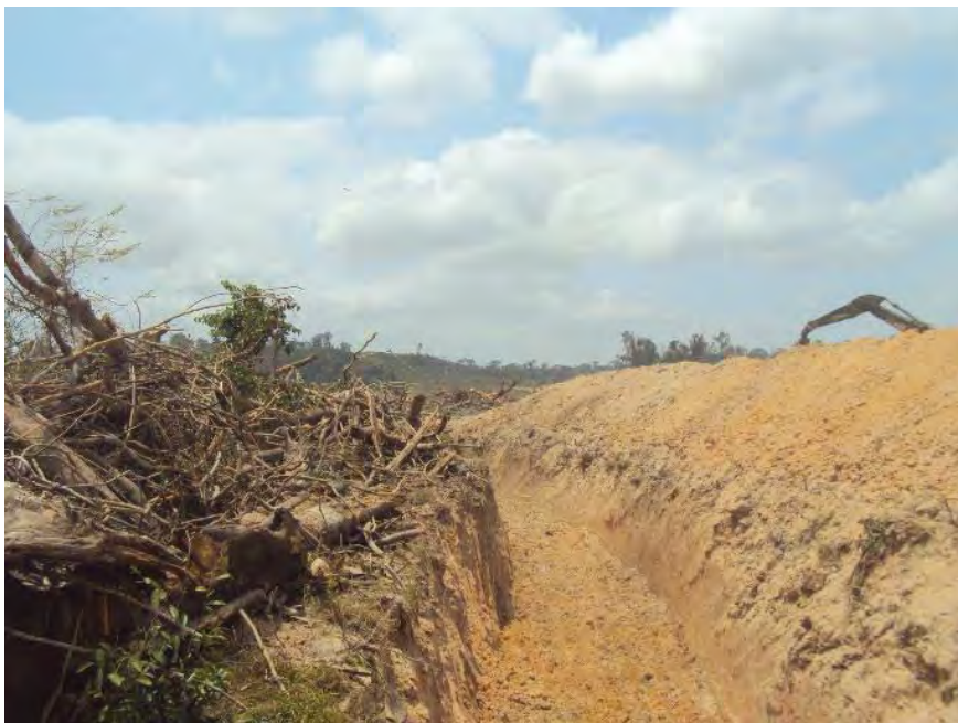
Figura 8: Abertura de vala para enterrio de resíduo fino cru - RX margem direita
