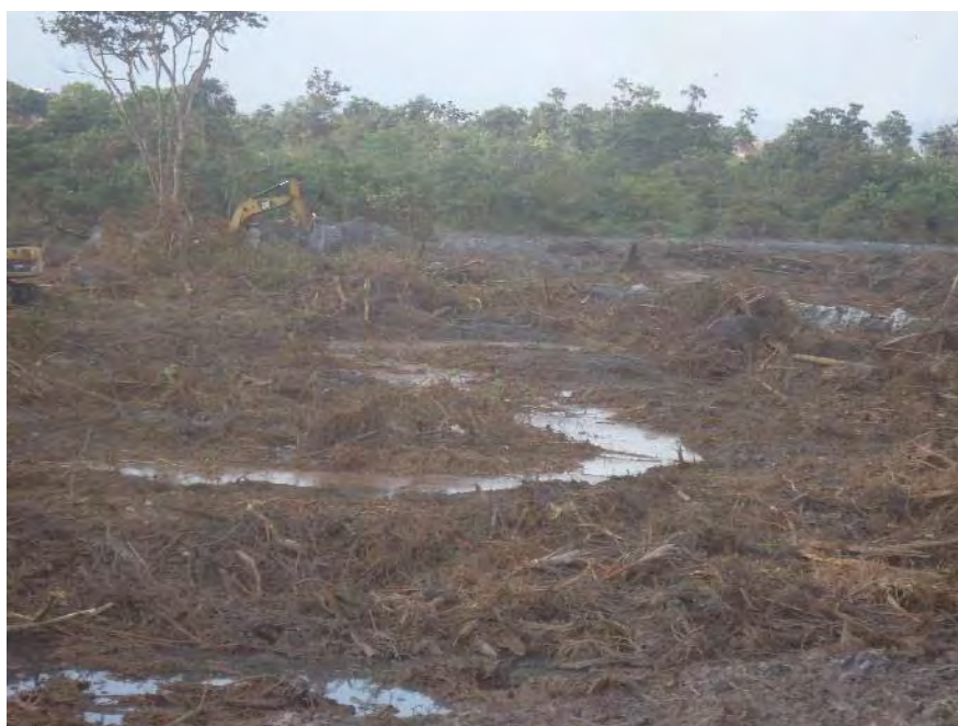
Figura 16: Realização de limpeza de resíduos finos em área de “baixão” - RX
