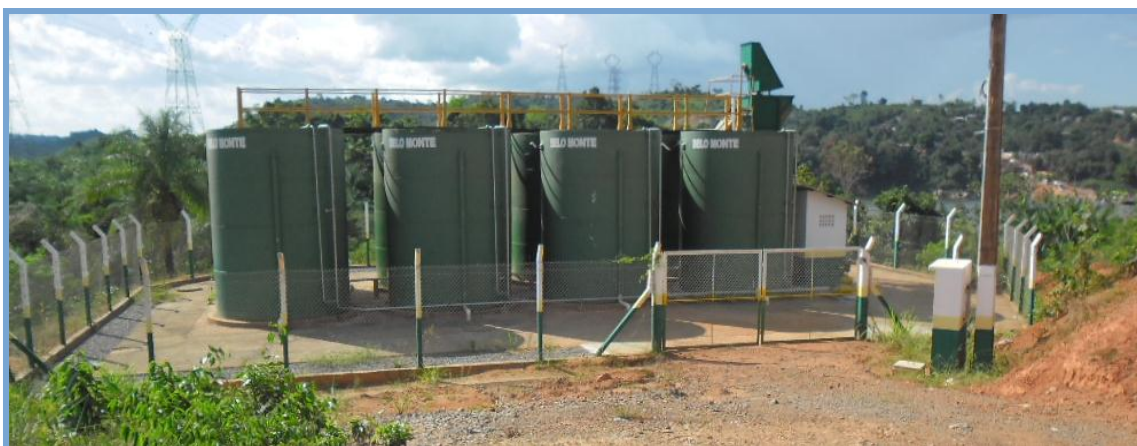
Figura 3-15 – Vista da Estação de Tratamento de Esgoto integrante do sistema de esgotamento sanitário da Vila de Belo Monte
