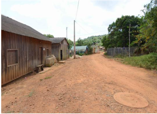
Figura 2-9 – Estrutura componente do sistema de abastecimento de água na localidade Vila da Ressaca
