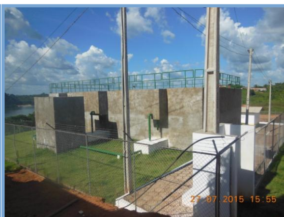
Figura 3-2 – Caixa de saída e dosadora química integrante do sistema de abastecimento de água de Belo Monte
