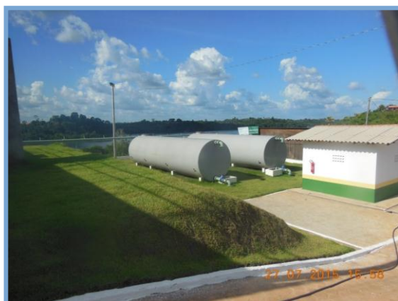
Figura 3-1 – Reservatórios apoiados integrantes do sistema de abastecimento de água de Belo Monte
