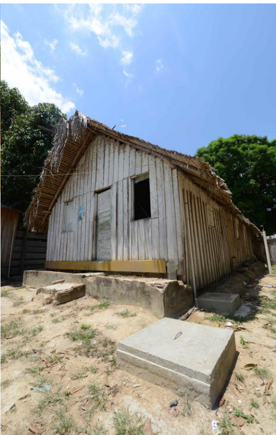
Figura 2-4 – Estruturas componentes do sistema de esgotamento sanitário implantado na localidade da Ilha da Fazenda
