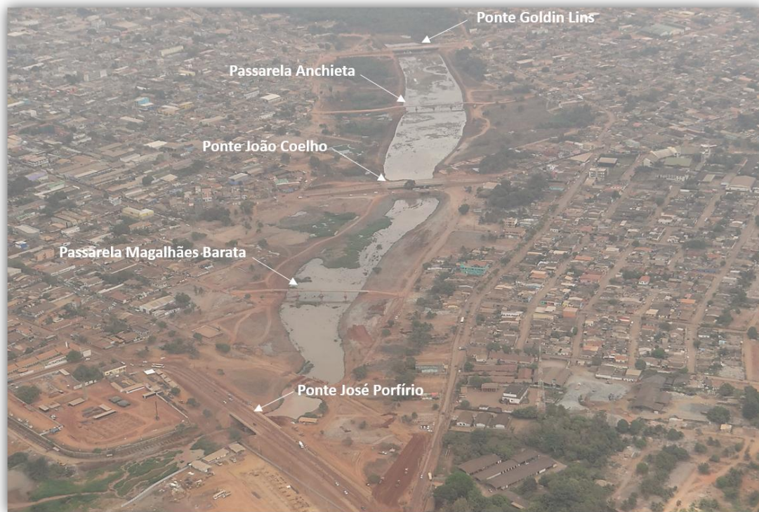
Figura 4-1 Vista geral da calha do igarapé Altamira, com o reafeiçoamento de suas margens
