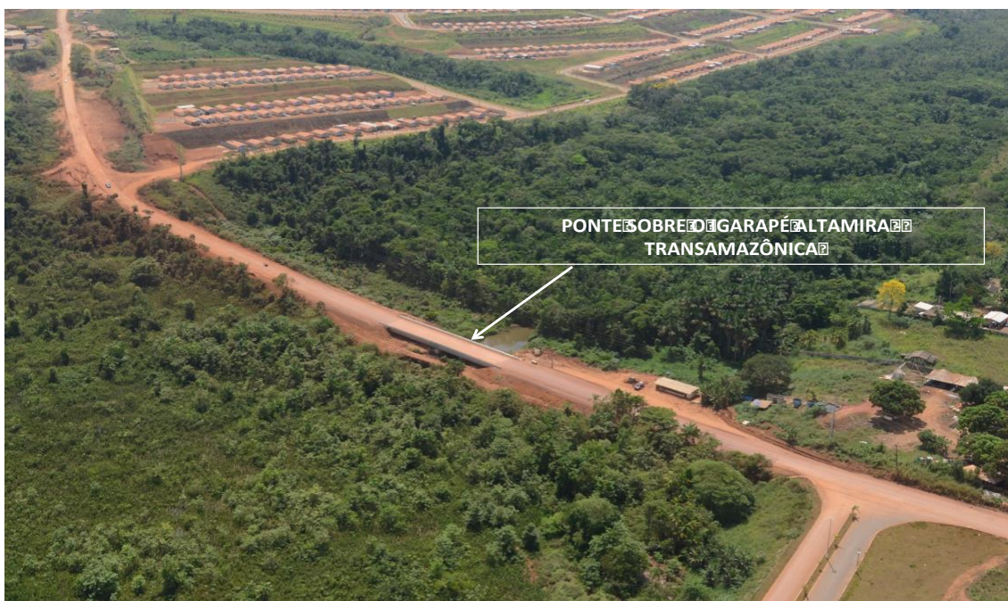
Figura 3-1 Vista da ponte da Rodovia Transamazônica sobre o igarapé Altamira, já concluída
