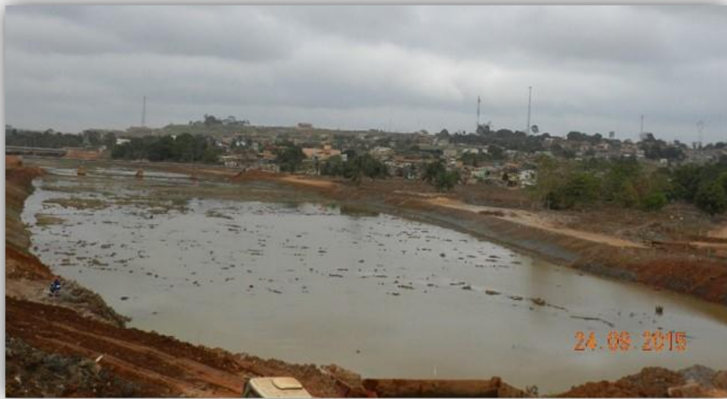
Figura 4-3 Vista do trecho da calha do igarapé Altamira, com o reafeiçoamento de suas margens entre a ponte João Coelho e a Passarela Magalhães Barata
