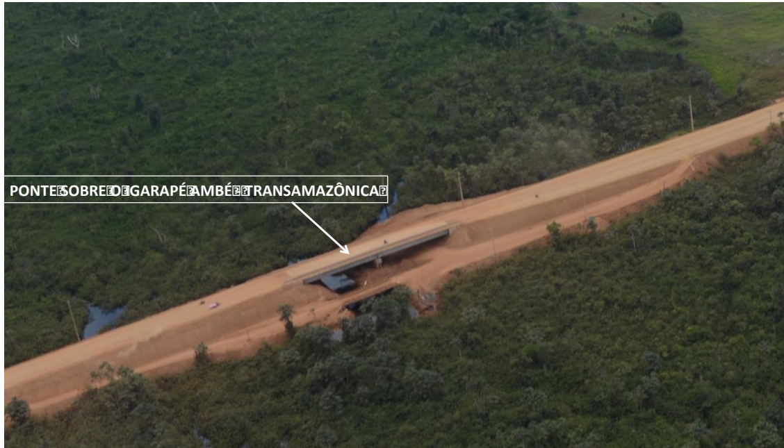
Figura 3-16 Vista da Ponte da Rodovia Transamazônia – Ambé I, sobre o igarapé Ambé, já concluída
