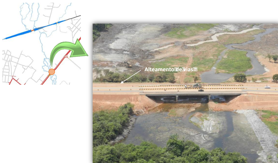
Figura 3-22 Mapa de localização da ponte sobre a Rodovia Ernesto Acioly, já concluída, com o alteamento das vias ao encontro da ponte, também já concluído
