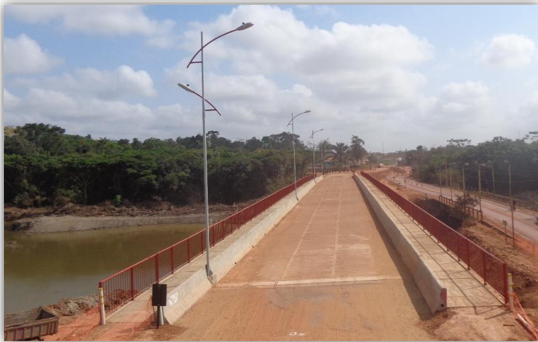
Figura 3-27 Vista da Ponte da Avenida Tancredo Neves, sobre o igarapé Panelas, já concluída
