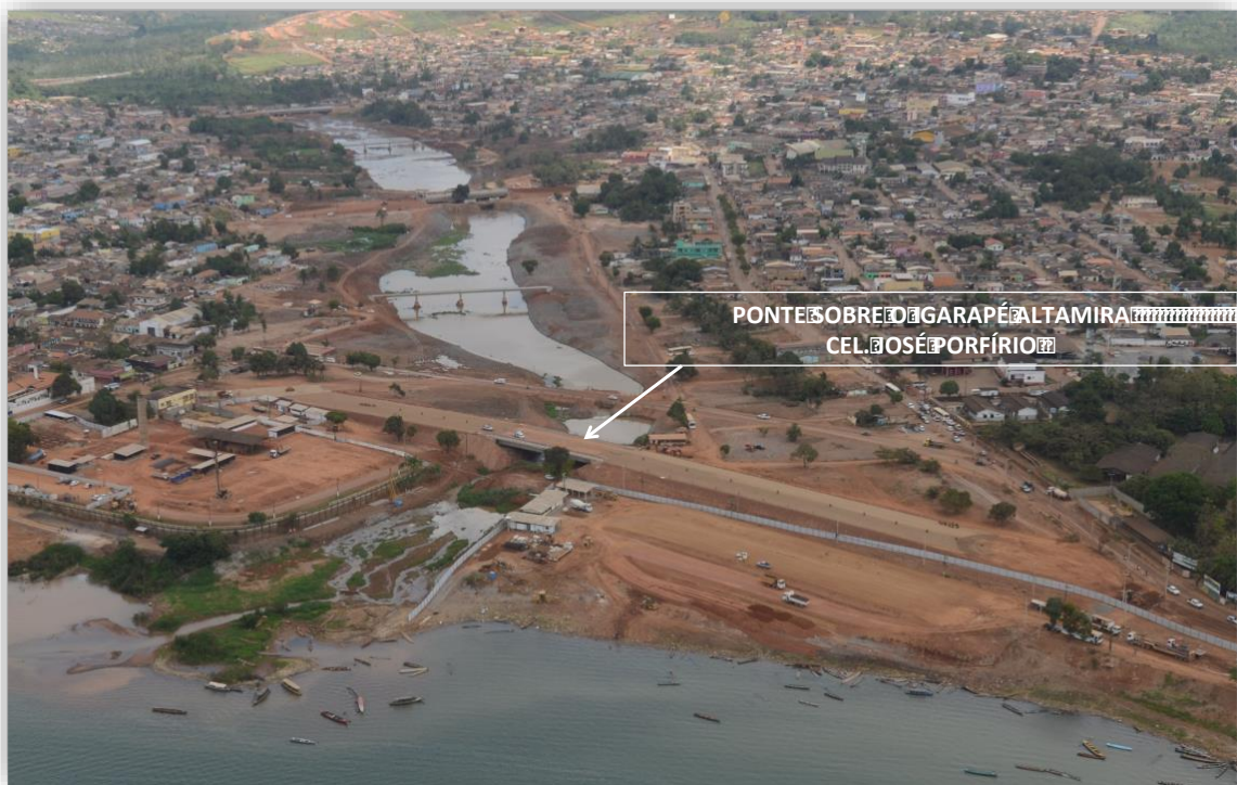
Figura 3-9 Vista da ponte Coronel José Porfírio, sobre o igarapé Altamira, já concluída
