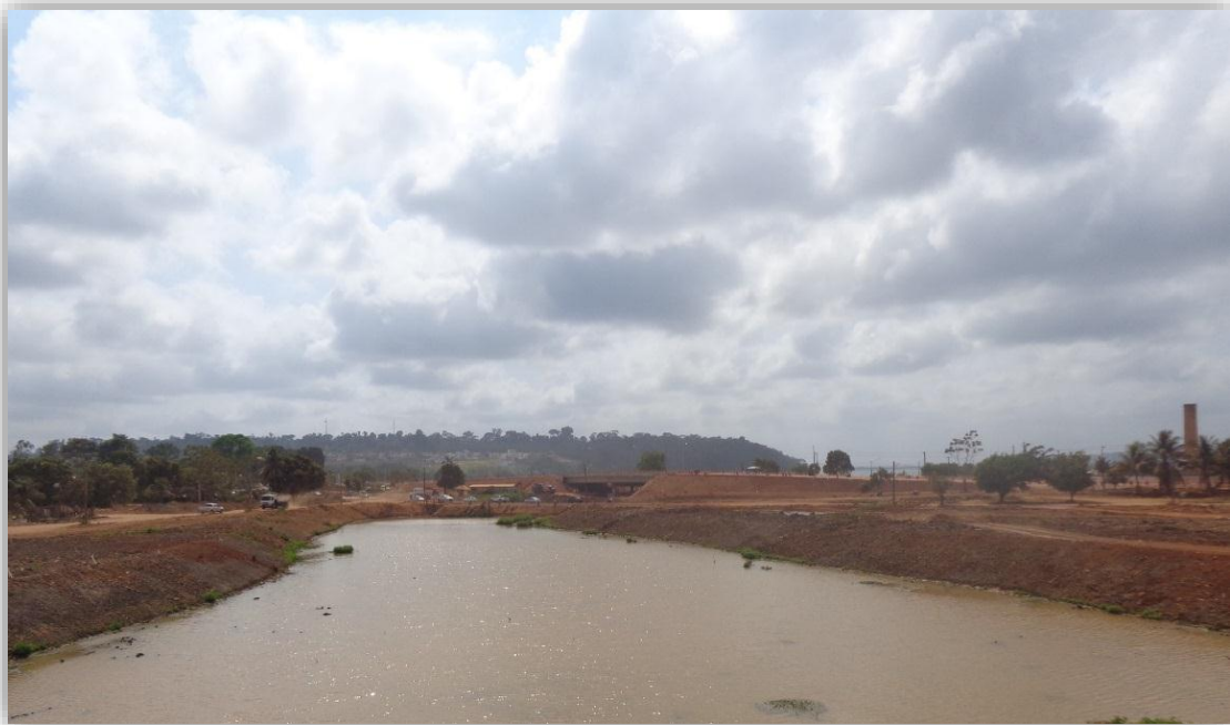
Figura 4-4 Vista do trecho da calha do igarapé Altamira, com o reafeiçoamento de suas margens entre a ponte Coronel José Porfírio e a Passarela Magalhães Barata
