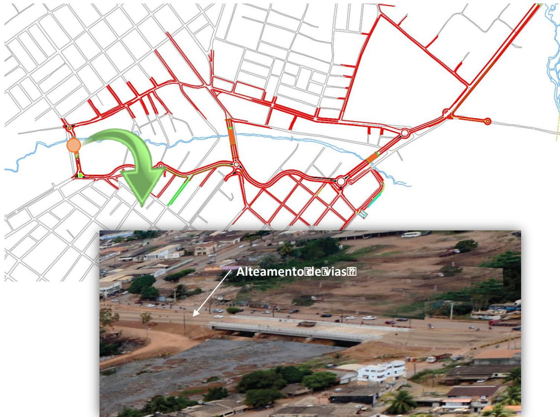
Figura 3-4 Mapa de localização da ponte Gondim Lins, já concluída, com o alteamento das vias ao encontro da ponte, também já concluído
