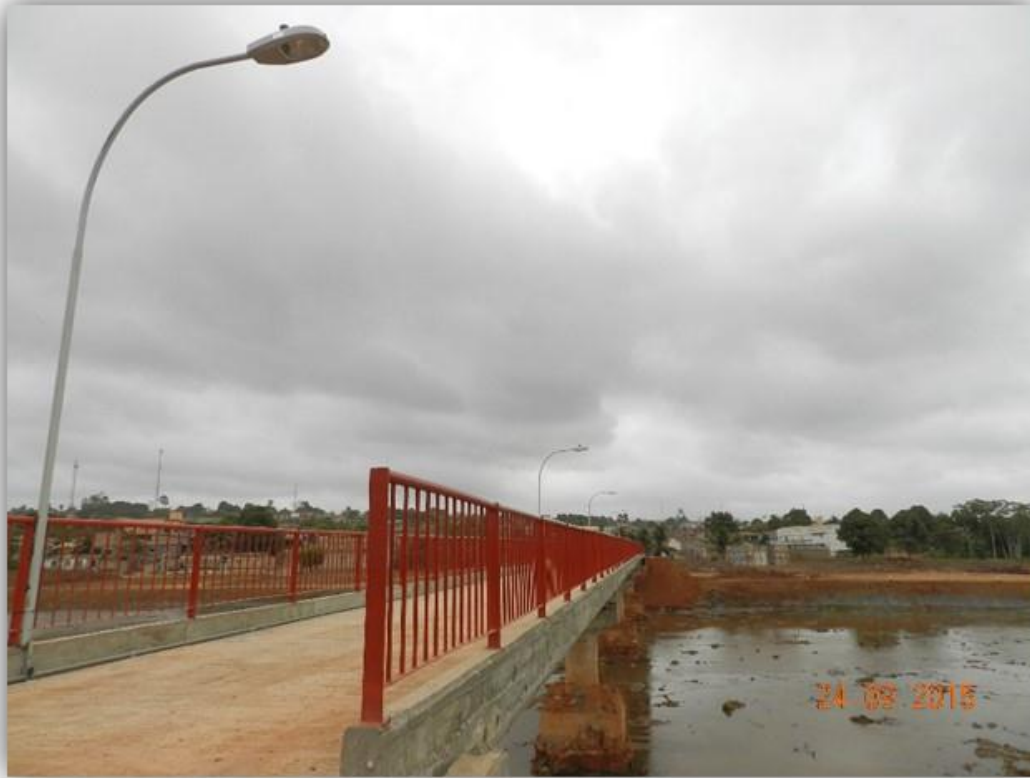
Figura 3-14 Vista e características principais da Traversia Anchieta, sobre o igarapé Altamira, já concluída
