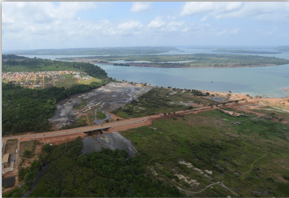
Figura 4-8 Vista geral da calha do igarapé Ambé, com a requalificação de suas margens
