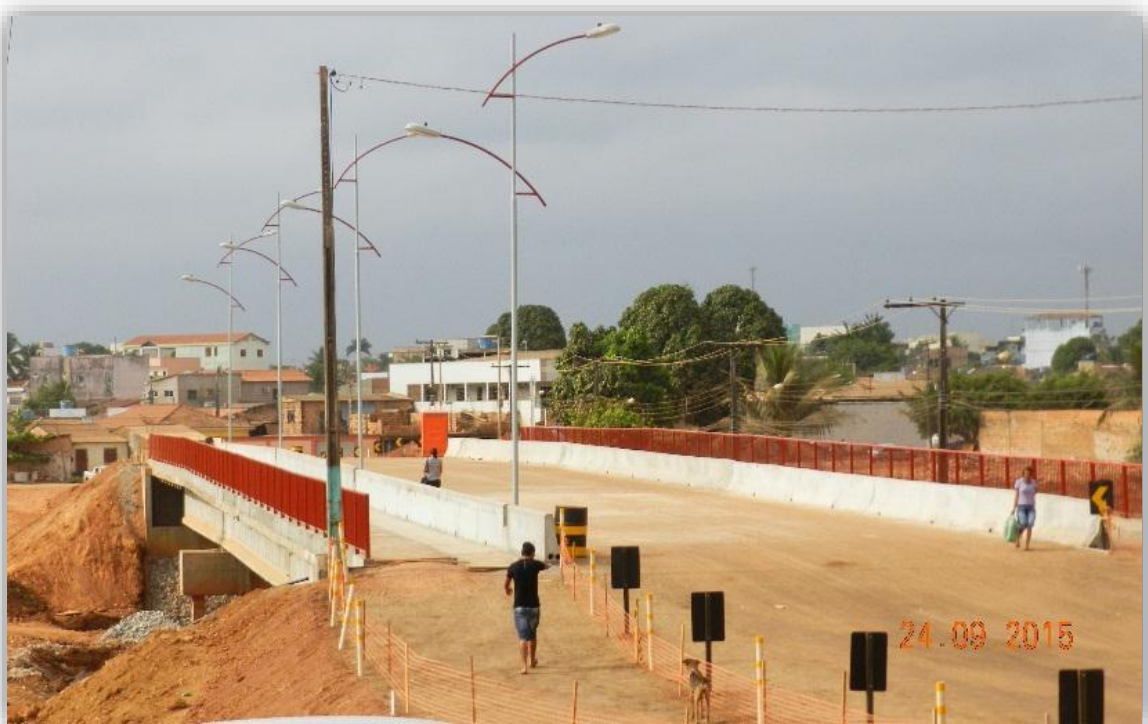
Figura 3-6 Vista e características principais da ponte da rua Gondim Lins, sobre o igarapé Altamira, já concluída
