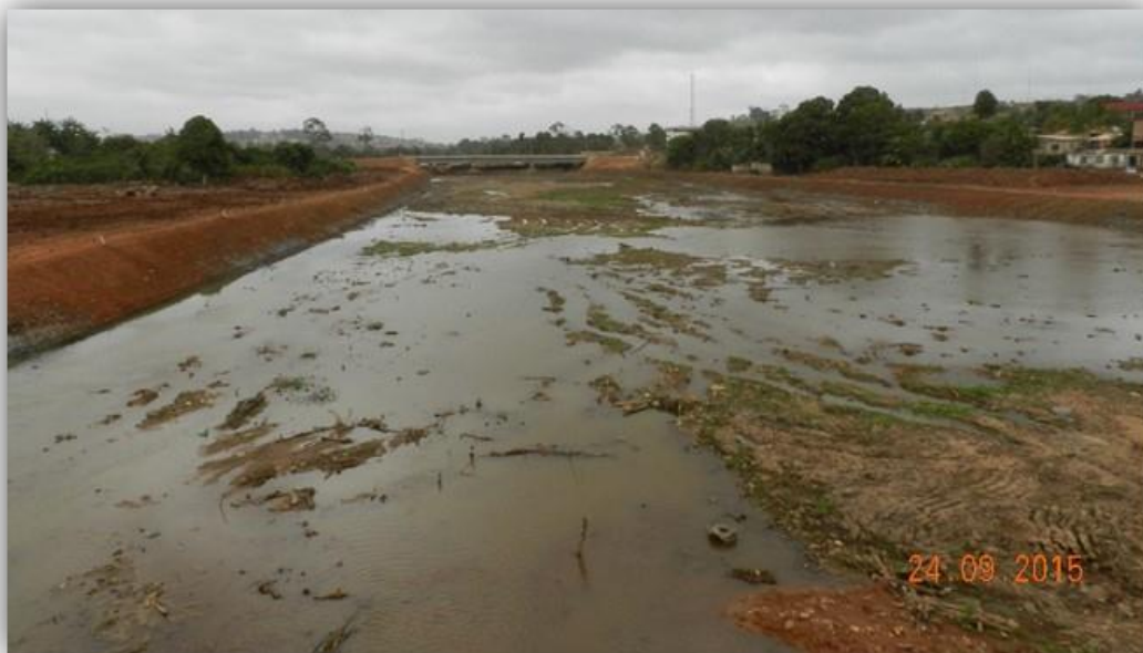
Figura 4-7 Vista do trecho da calha do igarapé Altamira, com o reafeiçoamento de suas margens entre a ponte João Coelho e a Passarela Anchieta
