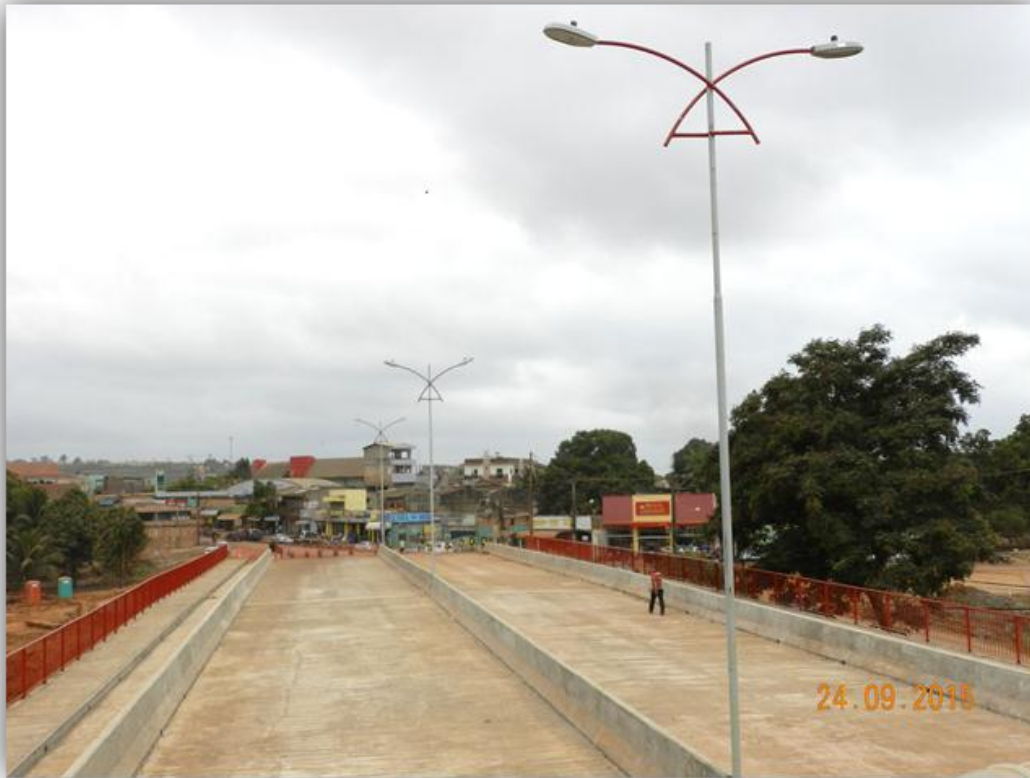
Figura 3-12 Vista da ponte da rua João Coelho, sobre o igarapé Altamira, já concluída
