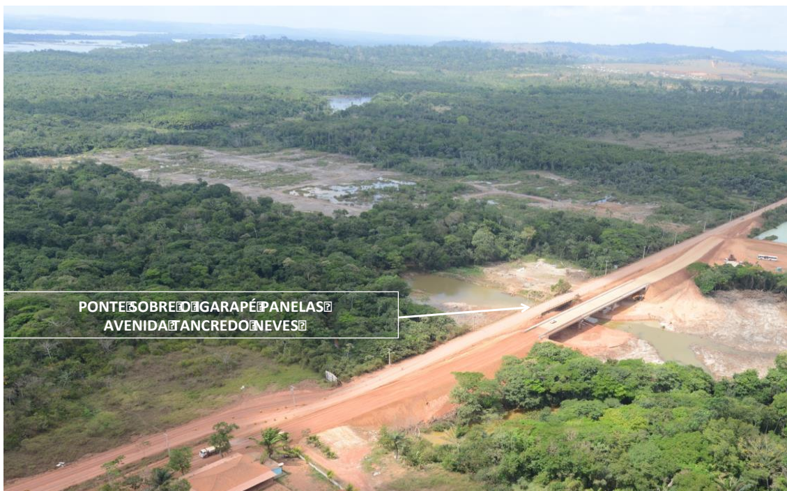
Figura 3-26 Vista da Ponte da Avenida Tancredo Neves, sobre o igarapé Panelas, já concluída
