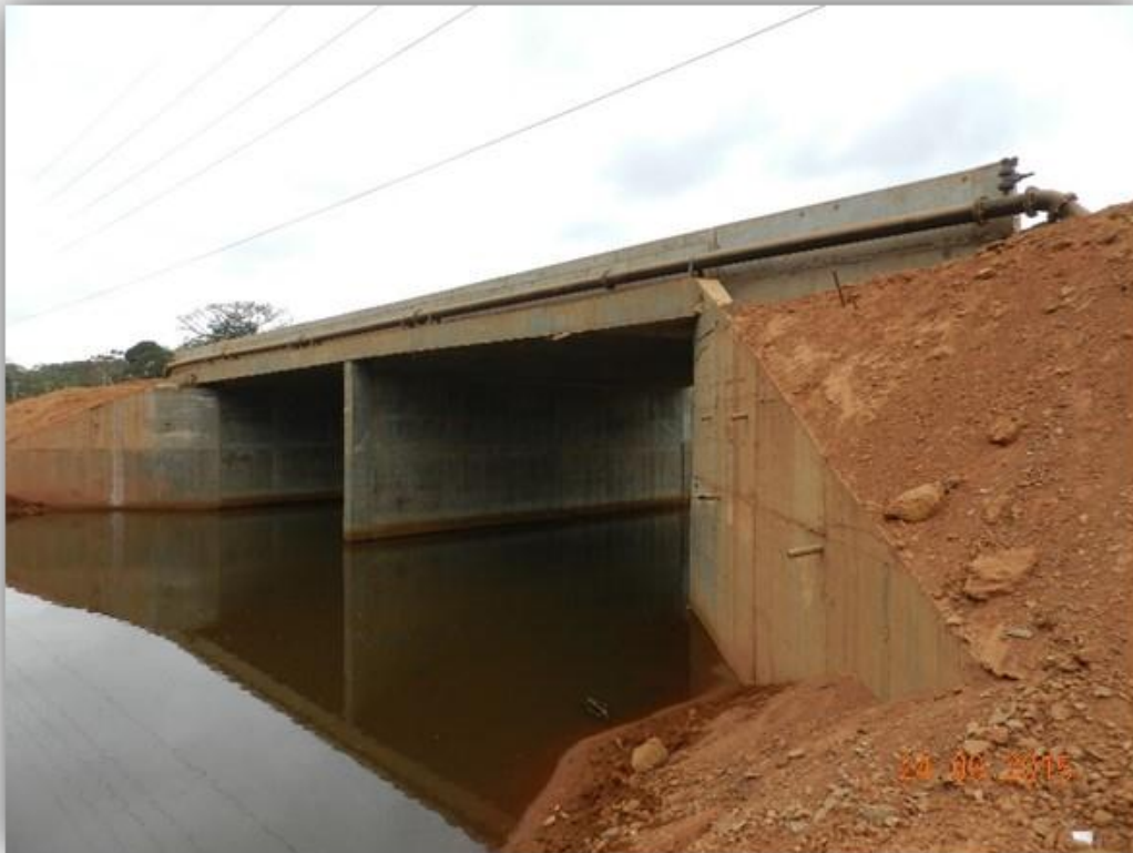
Figura 3-20 Vista do alteamento da via ao encontro da galeria da Rodovia Transamazônica – Ambé II, no igarapé Ambé, já concluído
