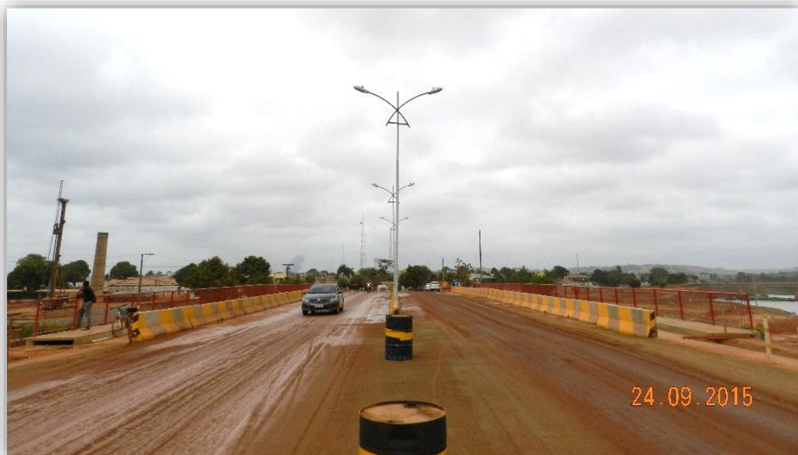
Figura 3-10 Vista da ponte Coronel José Porfírio sobre o igarapé Altamira, já concluída, e suas características principais
