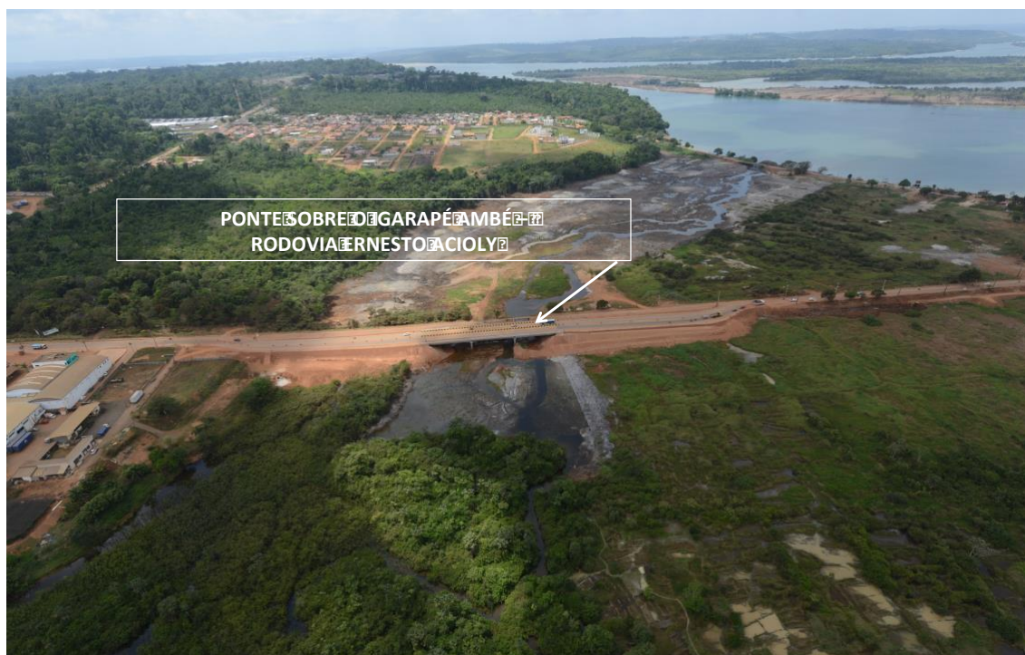
Figura 3-23 Vista da Ponte da Rodovia Ernesto Acioly, sobre o igarapé Ambé, já concluída
