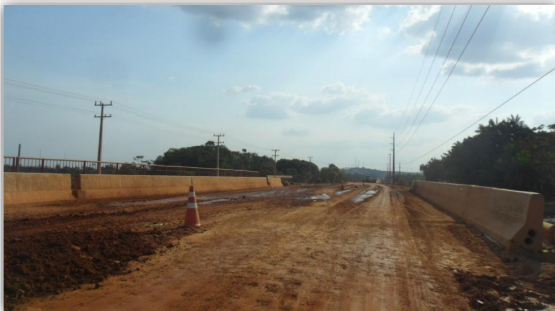
Figura 3-21 Vista do alteamento da via ao encontro da galeria da Rodovia Transamazônica – Ambé II, no igarapé Ambé, já concluído
