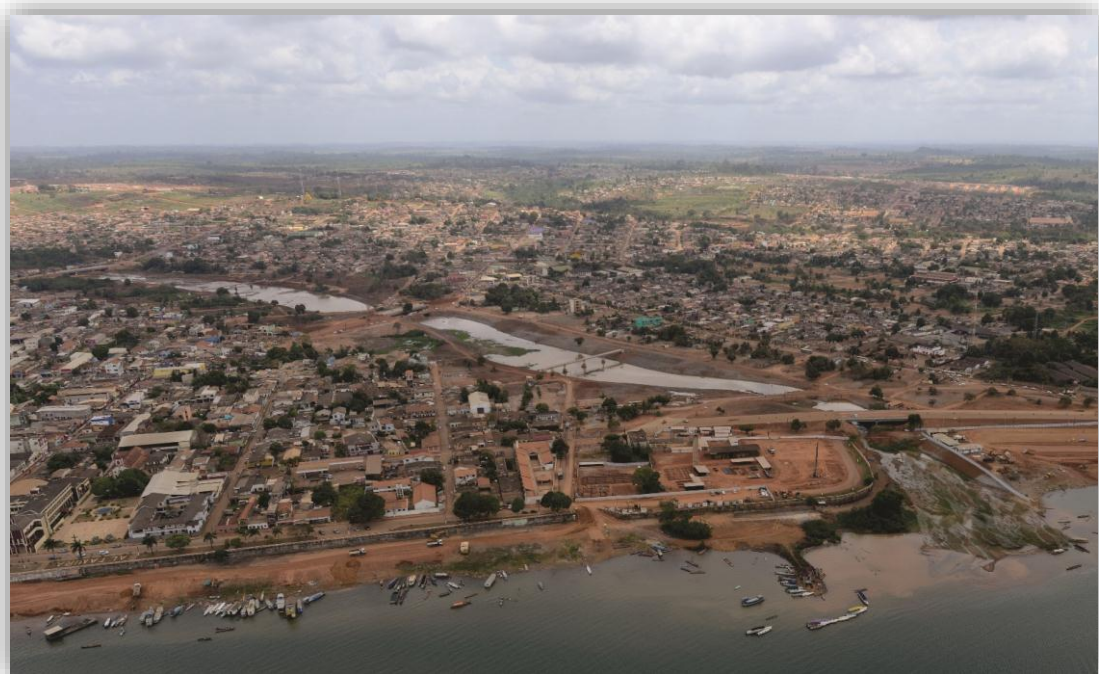
Figura 4-2 Vista do trecho da calha do igarapé Altamira, com o reafeiçoamento de suas margens entre as pontes José Porfírio e João Coelho
