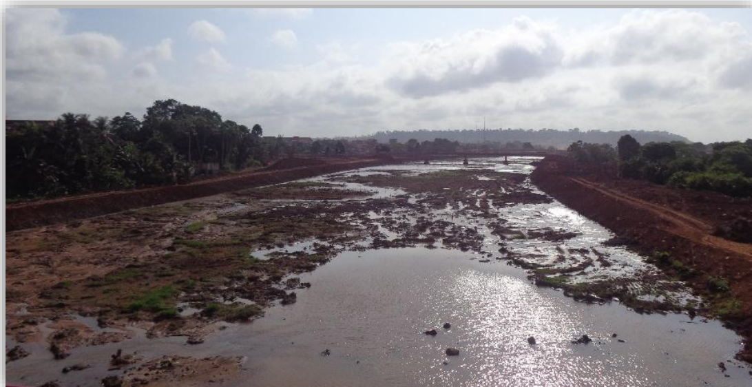
Figura 4-6 Vista do trecho da calha do igarapé Altamira, com o reafeiçoamento de suas margens entre a ponte Gondim Lins e a Passarela Anchieta
