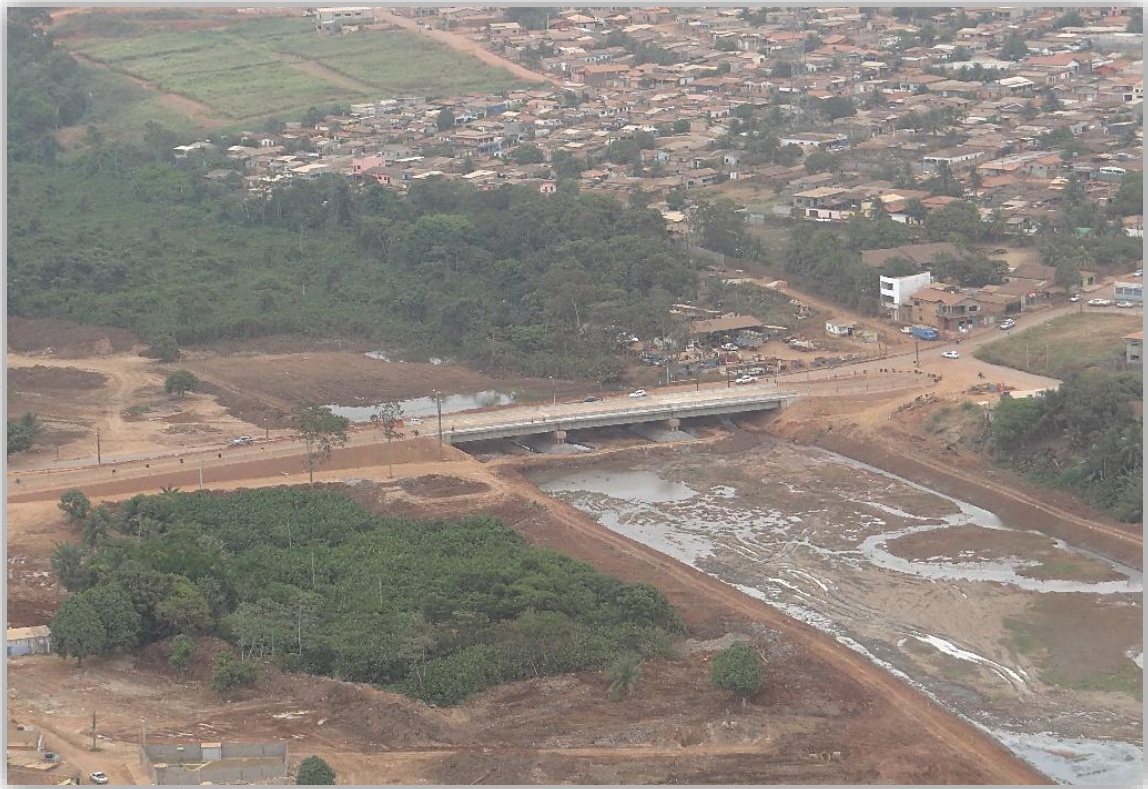
Figura 3-5 Vista da ponte Gondim Lins, sobre o igarapé Altamira, já concluída
