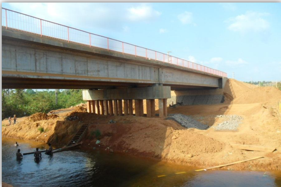
Figura 3-18 Vista do aterro de encontro à Ponte da Rodovia Transamazônica – Ambé I, sobre o igarapé Ambé, já concluído
