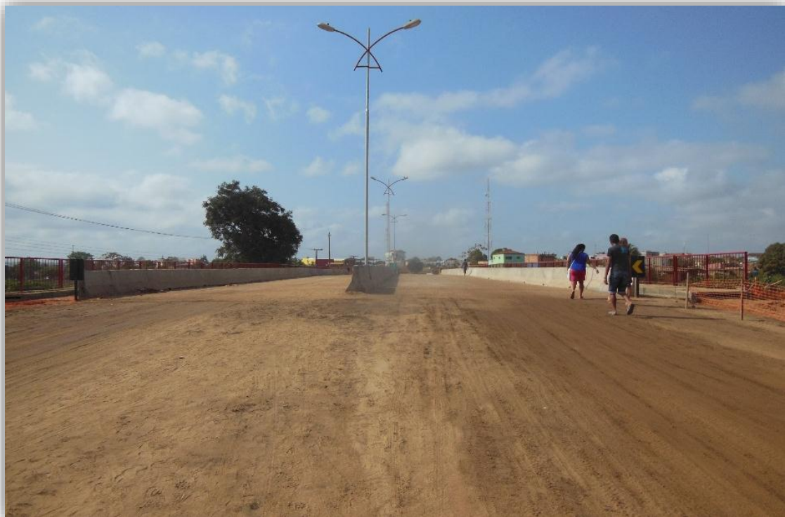
Figura 3-13 Vista e características principais da ponte da rua João Coelho, sobre o igarapé Altamira, já concluída, assim como o alteamento da via ao encontro da ponte
