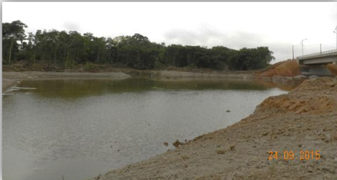
Figura 4-9 Vista da calha do igarapé Panelas, com o reafeiçoamento de suas margens
