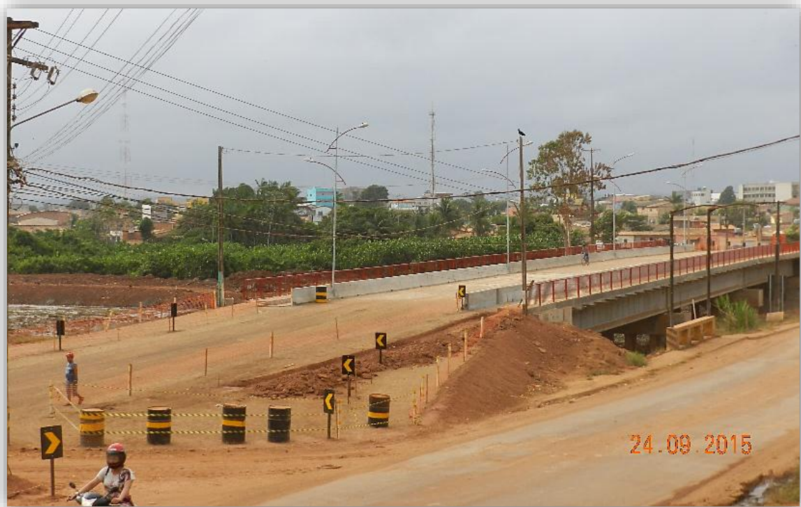
Figura 3-7 Vista do acesso à Ponte Gondim Lins, com alteamento da via executado
