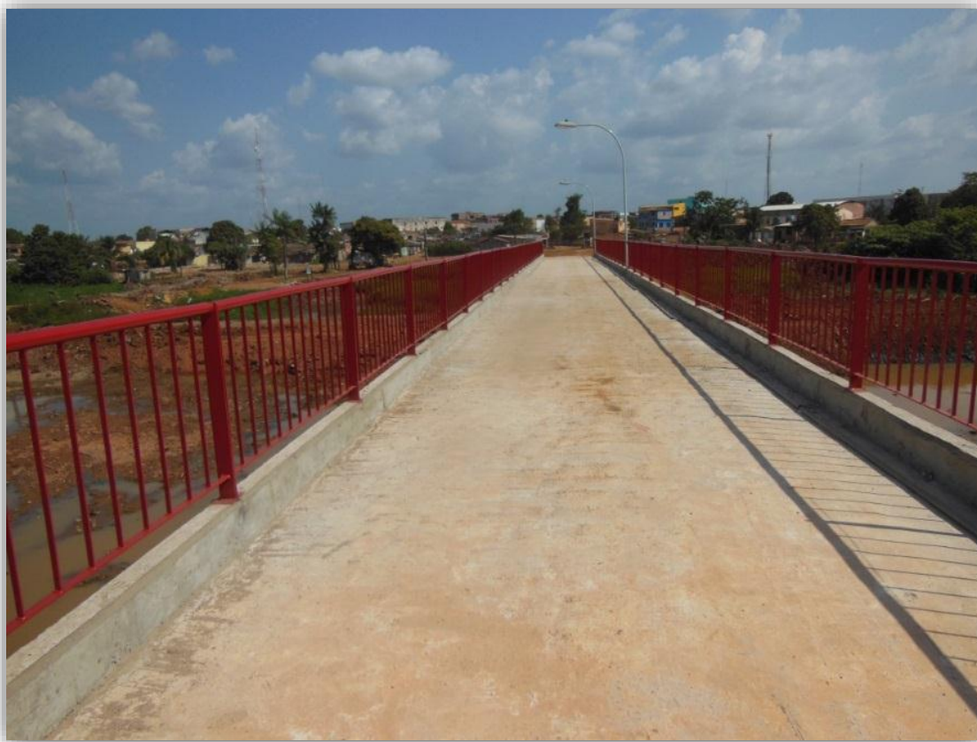
Figura 3-15 Vista da Travessia Magalhães Barata, sobre o igarapé Altamira, já concluída
