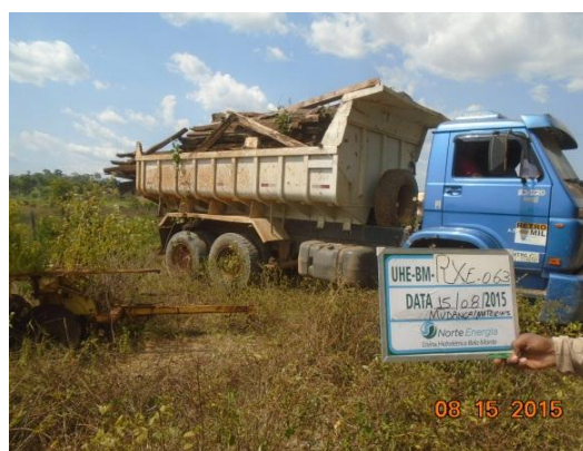
Figura 4-2 – Atividade de demolição de materiais realizada no lote RXE-063
