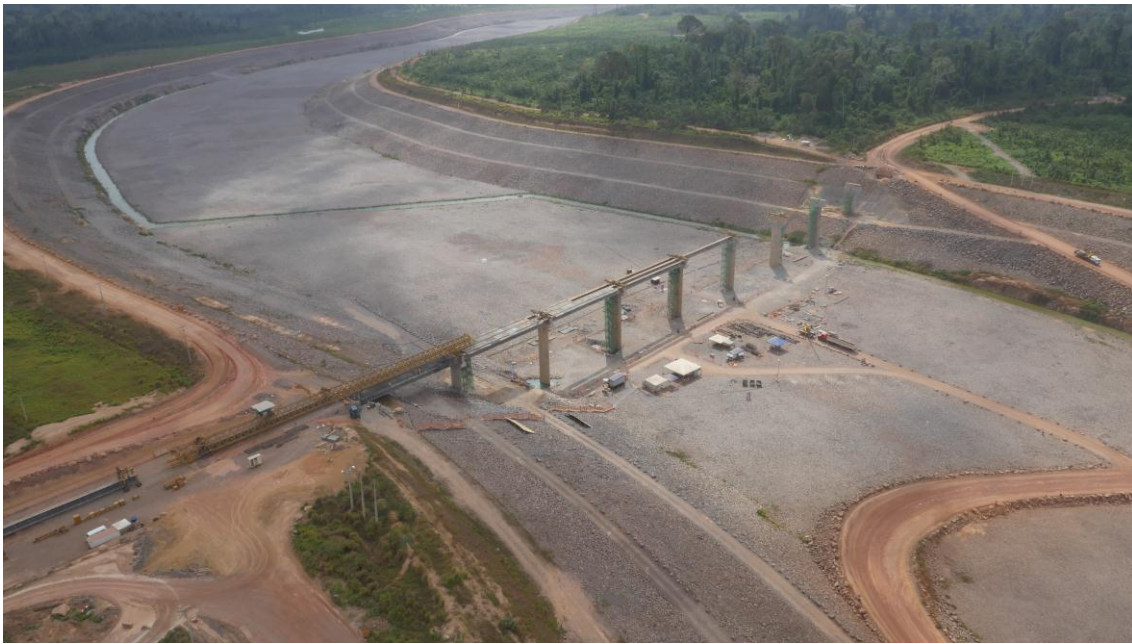
Figura 3-19 – Ponte sobre o Canal de Derivação
