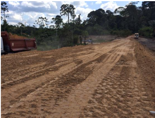
Figura 3-15 – Revestimento com piçarra
