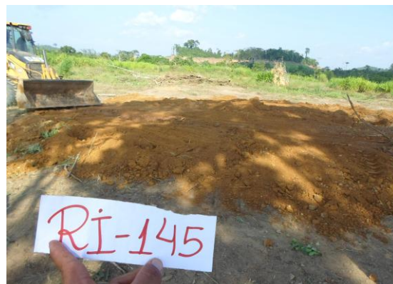
Figura 4-6 – Enterrio de material concluído – RI145
