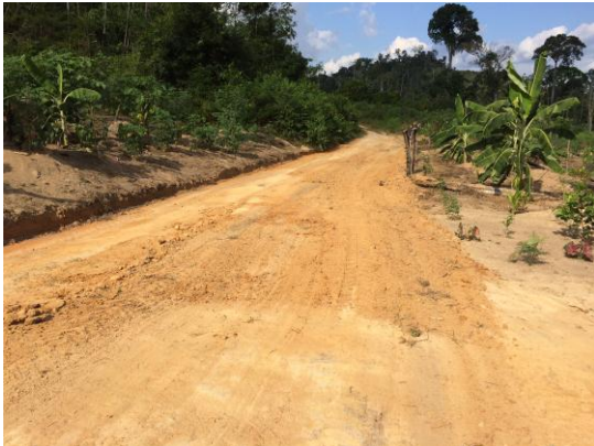
Figura 3-7 – Acesso Da. Raimunda
