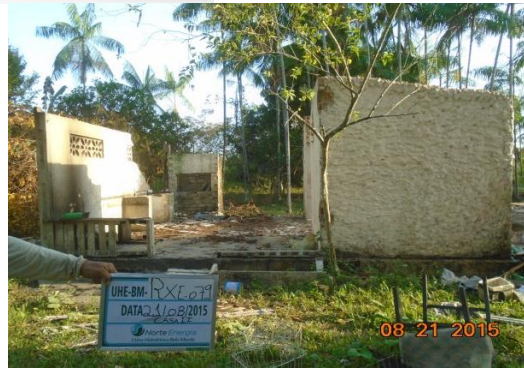
Figura 4-4 – Atividade de demolição de casa no lote RXE-79
