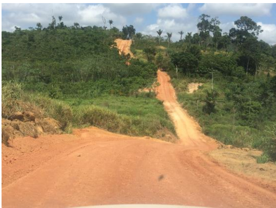
Figura 3-11 – Acesso João Batista
