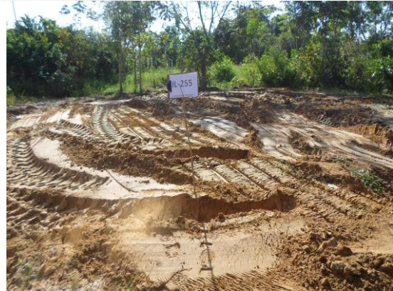
Figura 4-10 – Enterrio concluído IL-255
