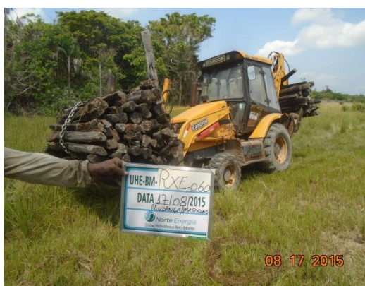
Figura 4-1 – Atividade de demolição de materiais realizada no lote RXE-060
