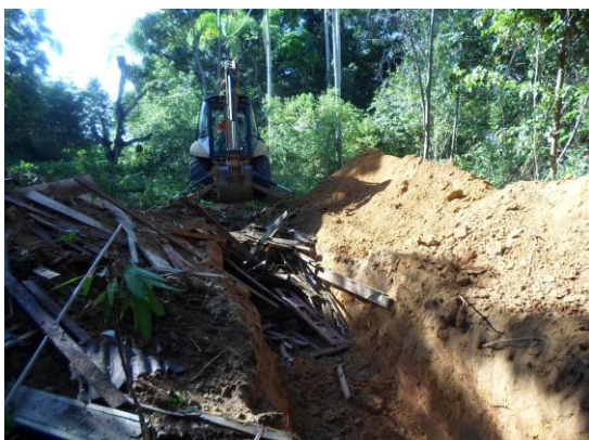
Figura 4-7 – Abertura de vala para enterrio de material RXE-037
