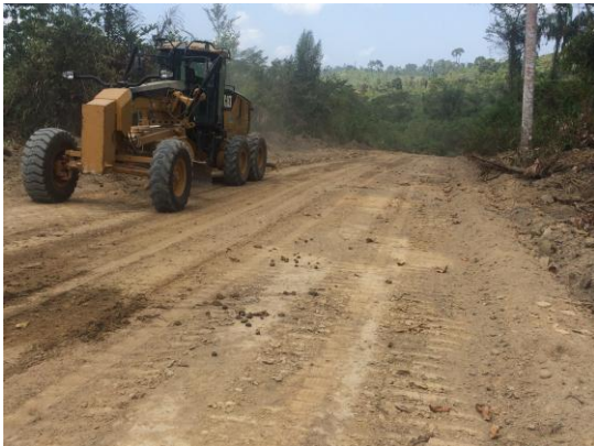
Figura 3-9 – Acesso João Batista
