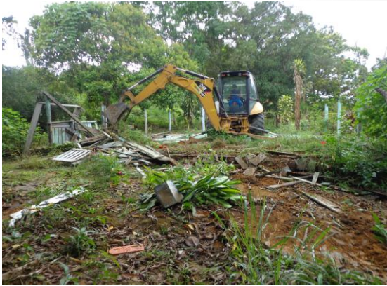
Figura 4-9 – Demolição de benfeitoria RXE-025
