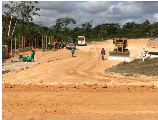
Figura 3-14 – Instalação de canteiro para acessos
