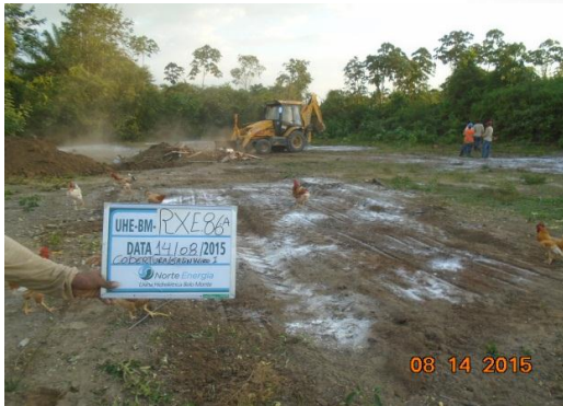
Figura 4-3 – DDD com cobertura de cal em área de galinheiro no lote RXE-86A
