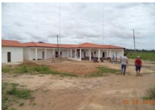
Figura 6 - 114 – Obra: Construção de Escola – Empresa Illuminare - PCNI/UHE Belo Monte (março/2016).
