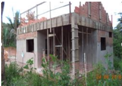
Figura 6 - 92 – Obra: Construção da UBS/alojamento – Empresa LGS - PCNI/UHE Belo Monte (junho/2016).
