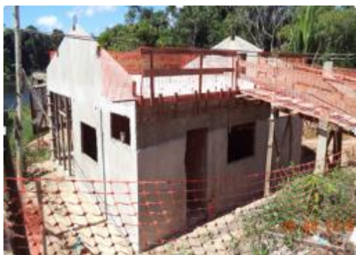
Figura 6 - 106 – Obra: Construção da UBS/alajamento – Empresa LGS - PCNI/UHE Belo Monte (junho/2016).
