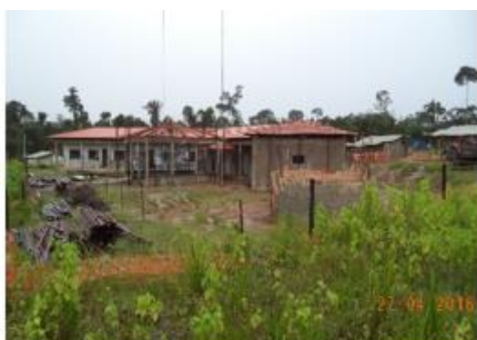
Figura 6 - 50 – Obra: Construção de Escola – Empresa Illuminare - PCNI/UHE Belo Monte (abril/2016).
