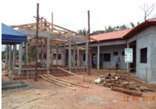
Figura 6 - 30 – Obra: Construção de Escola – Empresa RJL - PCNI/UHE Belo Monte (abril/2016).
