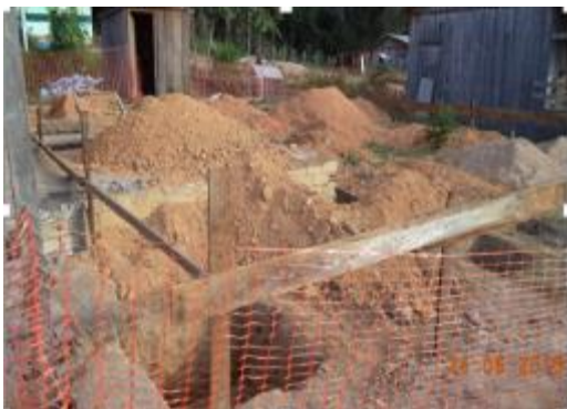
Figura 6 - 102 – Obra: Construção da UBS – Empresa Gomes & Sales - PCNI/UHE Belo Monte (junho/2016).
