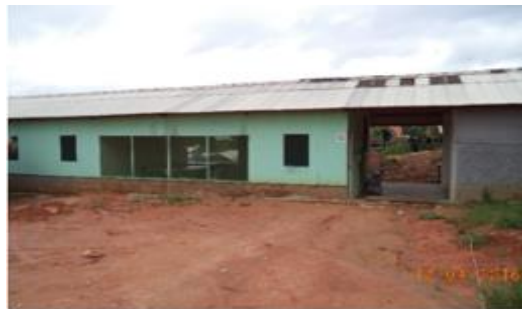
Figura 6 - 35 – Alojamento dos trabalhadores - Empresa RJL - PCNI/UHE Belo Monte (abril/2016).
