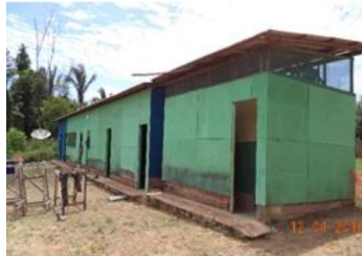
Figura 6 - 41 – Alojamentos de trabalhadores - Empresa Gomes & Sales - PCNI/UHE Belo Monte (abril/2016).
