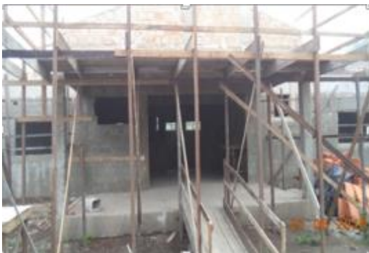
Figura 6 - 77 – Obra: Construção da UBS – Empresa Gomes & Sales - PCNI/UHE Belo Monte (junho/2016).
