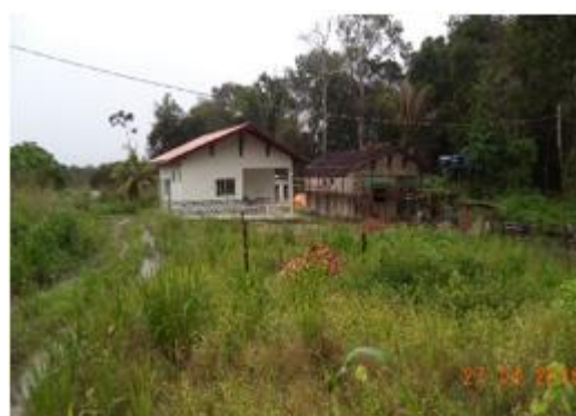
Figura 6 - 51 – Obra: Construção de UBS e alojamento – Empresa Gomes & Sales - PCNI/UHE Belo Monte (abril/2016).
