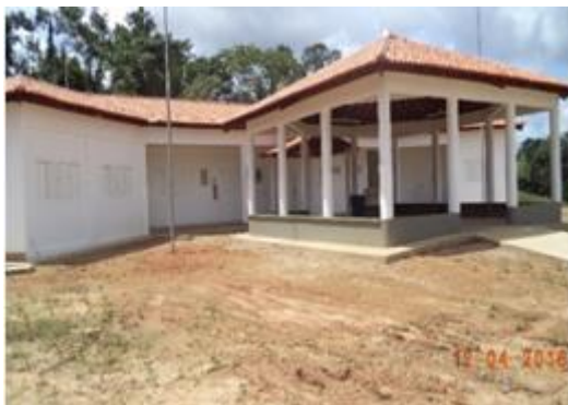
Figura 6 - 42 – Obra: Construção de Escola – Empresa Illuminare - PCNI/UHE Belo Monte (abril/2016).
