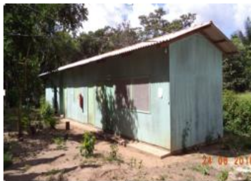
Figura 6 - 95 – Alojamento de trabalhadores - Empresa LGS - PCNI/UHE Belo Monte (junho/2016).
