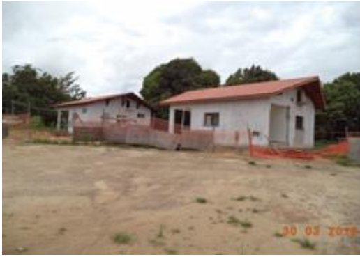
Figura 6 - 116 – Obra: Construção de Alojamento da UBS – Empresa Gomes & Sales - PCNI/UHE Belo Monte (março/2016).
