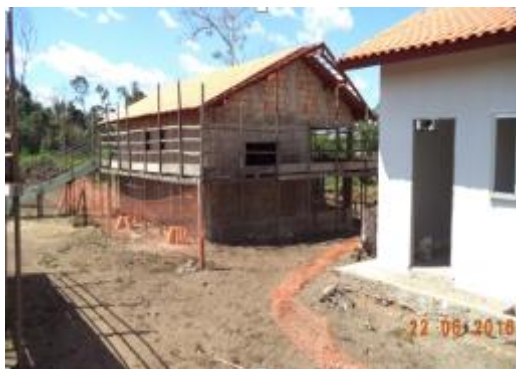
Figura 6 - 86 – Obra: Construção da UBS/alajamento – Empresa Gomes & Sales - PCNI/UHE Belo Monte (junho/2016).
