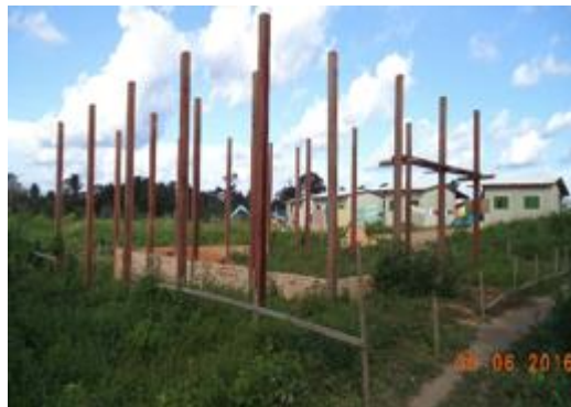
Figura 6 - 65 – Obra: Construção da Casa de Farinha - Empresa MCC Construções - aldeia Rapkô - PCNI/UHE Belo Monte (junho/2016).
