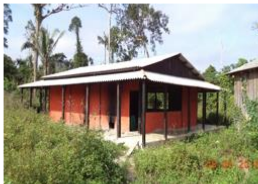
Figura 6 - 61 – Obra: Construção da Casa de Farinha - Empresa W Brasil - aldeia Py-takô - PCNI/UHE Belo Monte (junho/2016).
