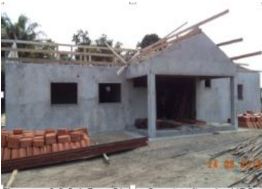
Figura 6 - 96 – Obra: Construção da UBS – Empresa Gomes & Sales - PCNI/UHE Belo Monte (junho/2016).
