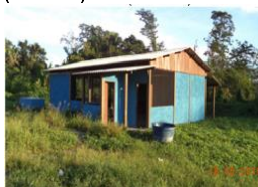
Figura 6 - 59 – Obra: Construção da Casa de Farinha - Empresa W Brasil - aldeia Kenkudjoy -PCNI/UHE Belo Monte (maio/2016).
