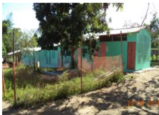
Figura 6 - 109 – Alojamento de trabalhadores - Empresa Gomes & Sales - PCNI/UHE Belo Monte (junho/2016).
