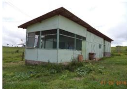
Figura 6 - 119 – Alojamentos de trabalhadores - Empresa Gomes & Sales - PCNI/UHE Belo Monte (março/2016).
