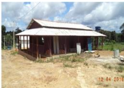
Figura 6 - 44 – Obra: Construção do pátio da casa de farinha – Empresa RJL - PCNI/UHE Belo Monte (abril/2016).
