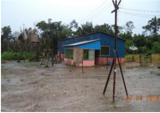
Figura 6 -52 – Alojamentos de trabalhadores - Empresa Illuminare - PCNI/UHE Belo Monte (abril/2016).
