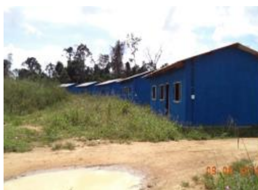
Figura 6 - 70 – Obra: Construção de Casas de moradia - Empresa W Brasil - aldeia Mrõtidjãm - PCNI/UHE Belo Monte (junho/2016).
