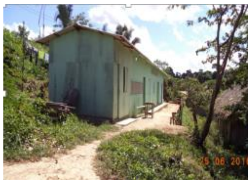
Figura 6 - 107 – Alojamento de trabalhadores - Empresa LGS - PCNI/UHE Belo Monte (junho/2016).
