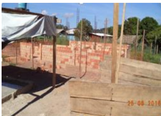
Figura 6 - 108 – Obra: Construção da UBS/alojamento – Empresa Gomes & Sales - PCNI/UHE Belo Monte (junho/2016).
