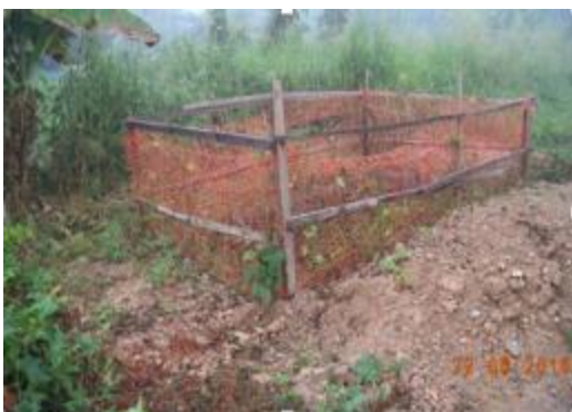
Figura 6 - 79 – Local de descarte de lixo – Empresa Gomes & Sales - PCNI/UHE Belo Monte (junho/2016).
