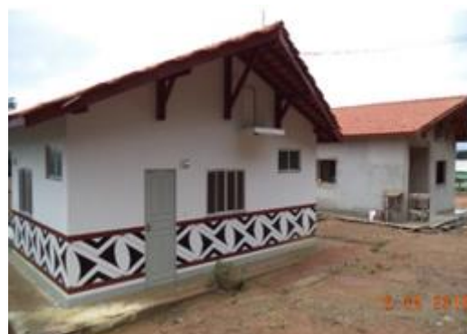
Figura 6 - 31 – Construção de UBS/alajamento - Empresa RJL - PCNI/UHE Belo Monte (abril/2016).
