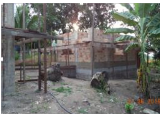
Figura 6 - 82 – Obra: Construção da UBS/alajamento – Empresa Gomes & Sales - PCNI/UHE Belo Monte (junho/2016).
