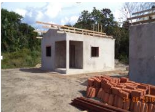
Figura 6 - 98 – Obra: Construção o alojamento da UBS – Empresa Gomes & Sales - PCNI/UHE Belo Monte (junho/2016).
