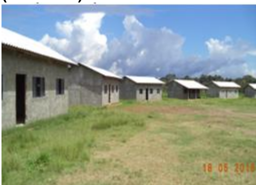
Figura 6 - 58 – Obra: Construção de Casas de moradia - Empresa W Brasil - aldeia Pat-krô - PCNI/UHE Belo Monte (maio/2016).
