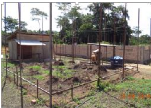
Figura 6 - 88 – Obra: Construção da UBS/alajamento – Empresa Gomes & Sales - PCNI/UHE Belo Monte (junho/2016).
