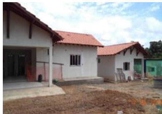
Figura 6 - 37a– Obra: Construção de UBS e alojamento – Empresa Gomes & Sales - PCNI/UHE Belo Monte (abril/2016).
