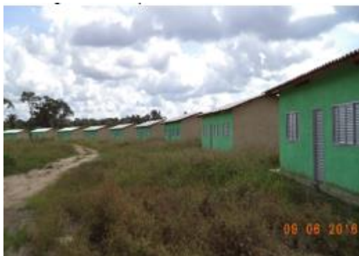
Figura 6 - 68 – Obra: Construção de Casas de moradia - Empresa W Brasil - aldeia Bacajá - PCNI/UHE Belo Monte (junho/2016).
