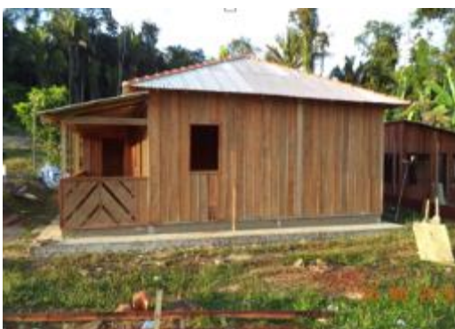
Figura 6 - 104 – Obra: Reformas de Casas de Moradia – Empresa Gomes & Sales - PCNI/UHE Belo Monte (junho/2016).
