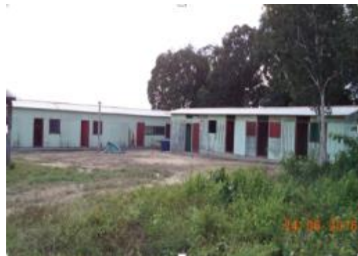
Figura 6 - 99 – Alojamento de trabalhadores - Empresa Gomes & Sales - PCNI/UHE Belo Monte (junho/2016).
