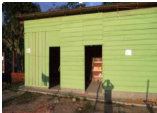
Figura 6 - 103– Local de armazenamento de material – Empresa Gomes & Sales - PCNI/UHE Belo Monte (junho/2016).
