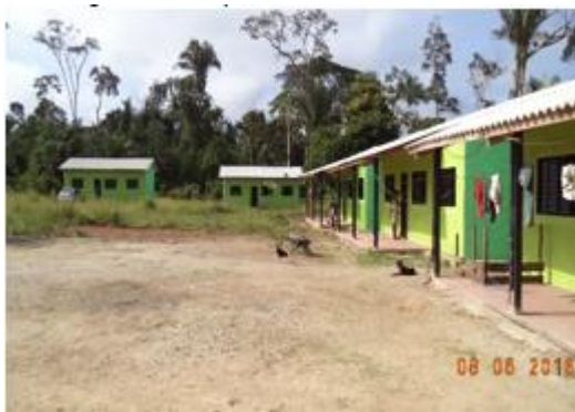
Figura 6 - 62 – Obra: Construção de Casas de moradia - Empresa W Brasil - aldeia Py-takô - PCNI/UHE Belo Monte (junho/2016).
