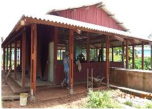
Figura 6 - 38 – Obra: Construção do pátio da casa de farinha – Empresa R JL - PCNI/UHE Belo Monte (abril/2016).
