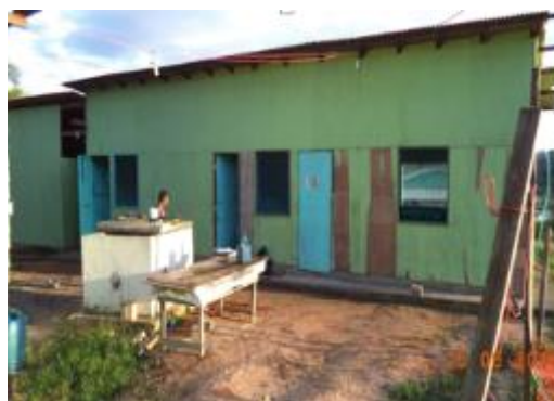
Figura 6 - 105– Alojamento de trabalhadores - Empresa Gomes & Sales - PCNI/UHE Belo Monte (junho/2016).
