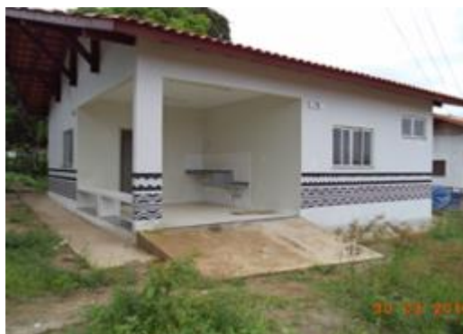
Figura 6 - 115 – Obra: Construção de UBS – Empresa Gomes & Sales - PCNI/UHE Belo Monte (março/2016).
