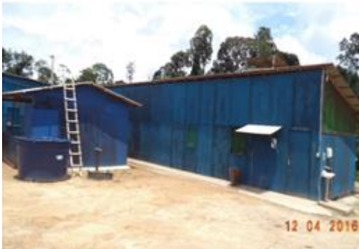
Figura 6 - 40 – Alojamentos de trabalhadores - Empresa Illuminare - PCNI/UHE Belo Monte (abril/2016).
