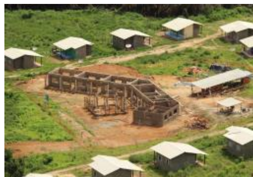
Figura 6 - 17 – Vista aérea da construção da Escola Indígena na aldeia Terrawangã. (fevereiro/2016).
