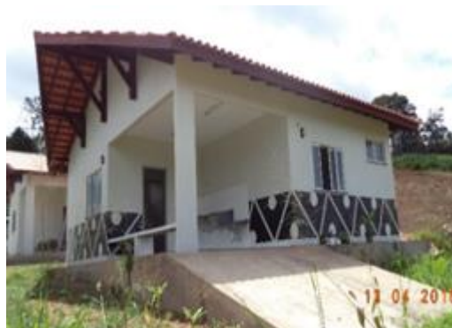
Figura 6 - 43 – Obra: Construção de UBS e alojamento – Empresa Gomes & Sales - PCNI/UHE Belo Monte (abril/2016).
