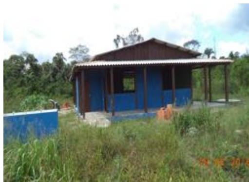
Figura 6 - 67 – Obra: Construção da Casa de Farinha - Empresa W Brasil - aldeia Bacajá - PCNI/UHE Belo Monte (junho/2016).
